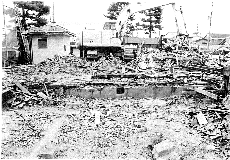
写真18-22 主体部北側布基礎
