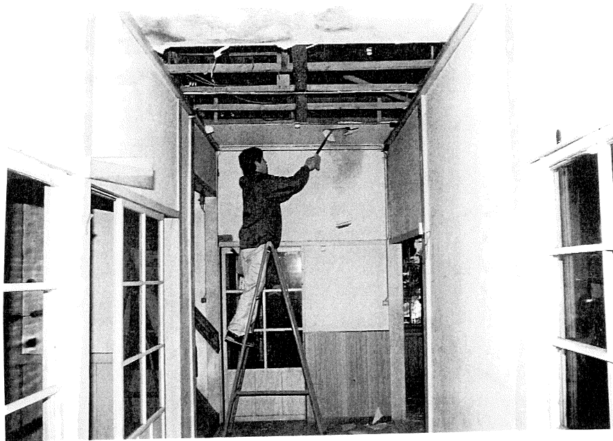
造作解体調査
