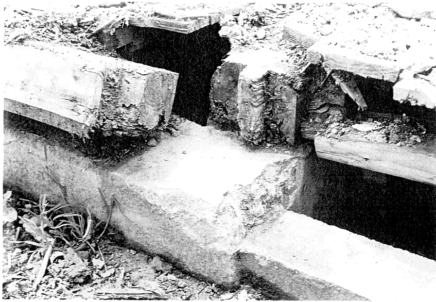
写真19-4 北東部隅土台納り
