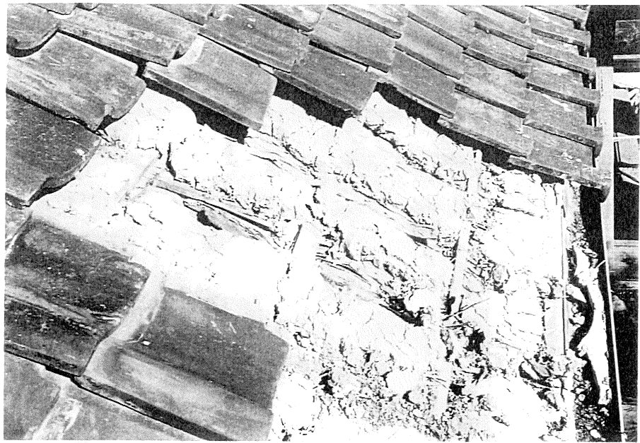
写真17-16 棧瓦葺の状況
