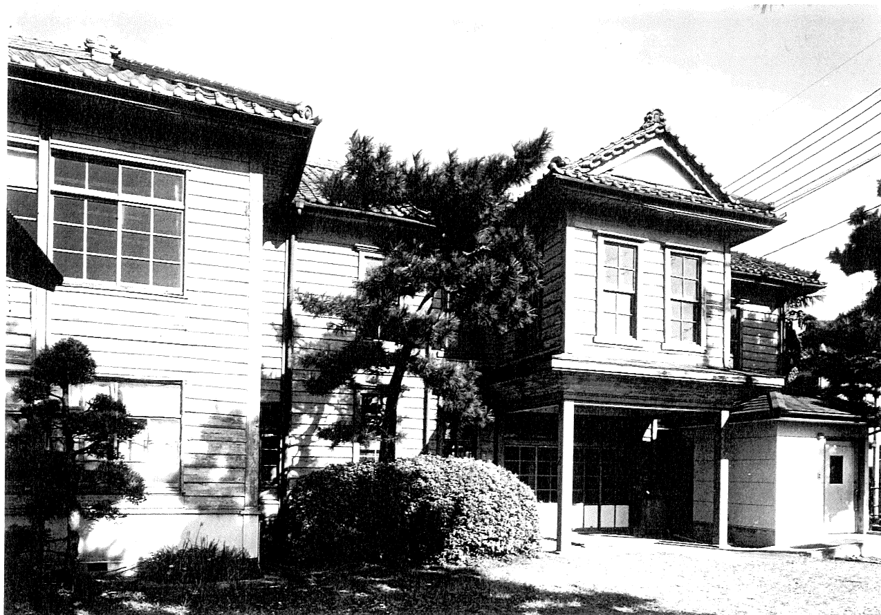
3 正面全景（南西より見る）
