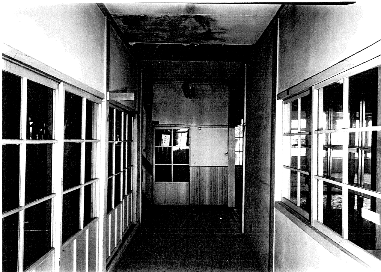
14 1階開架室西側廊下（南より見る）
