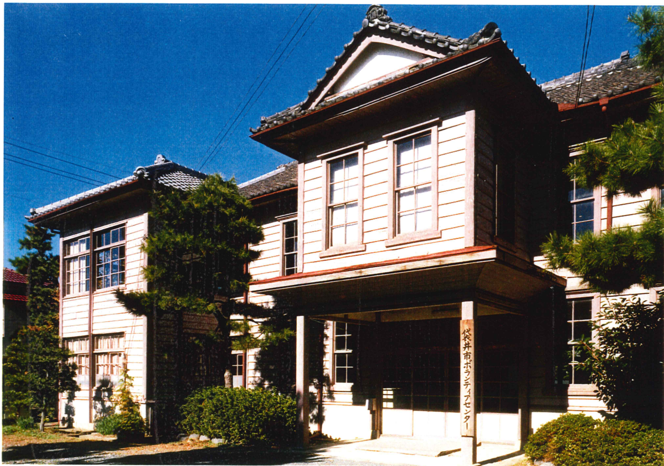
旧袋井町役場庁舎（袋井市ボランティアセンター時代）
