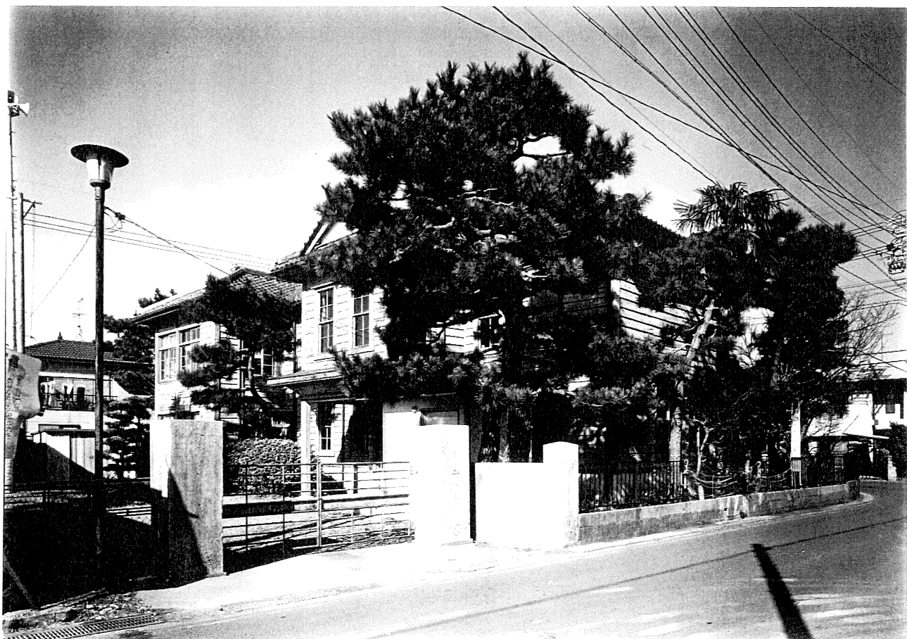
1 全景（南東より見る）
