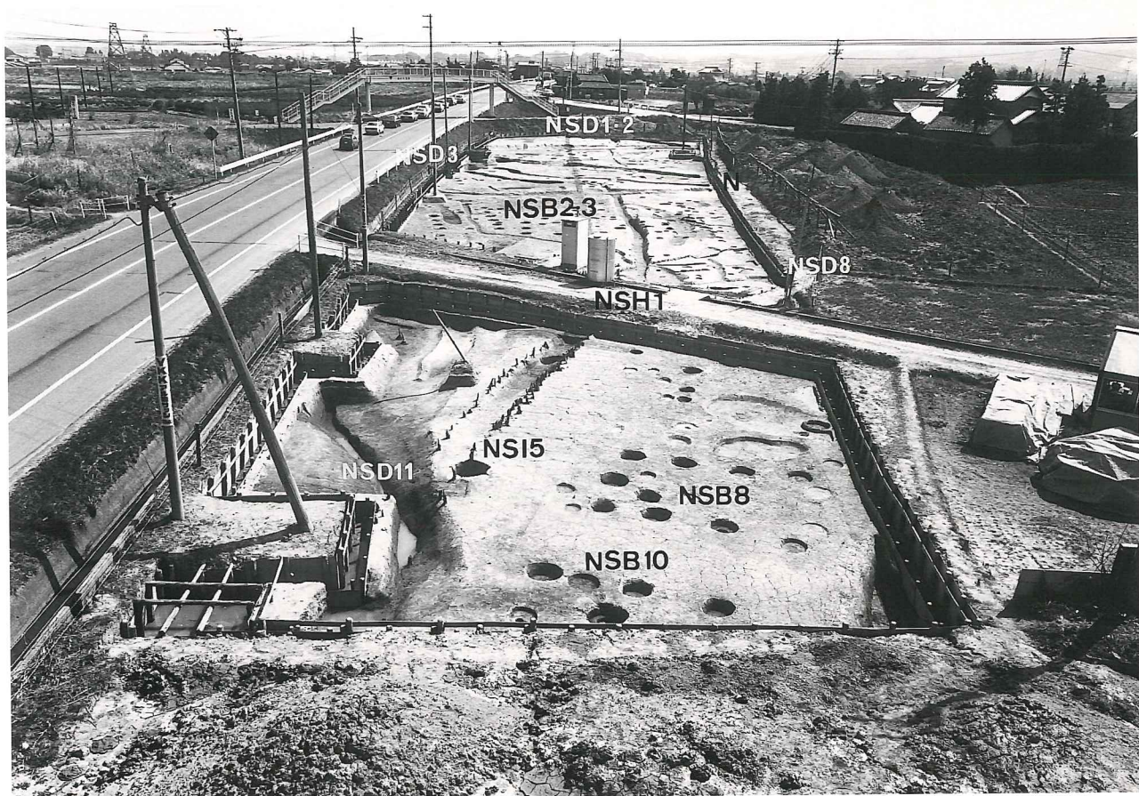
2・3 F～2・3 J 区完掘全景－国道南側・西から－
