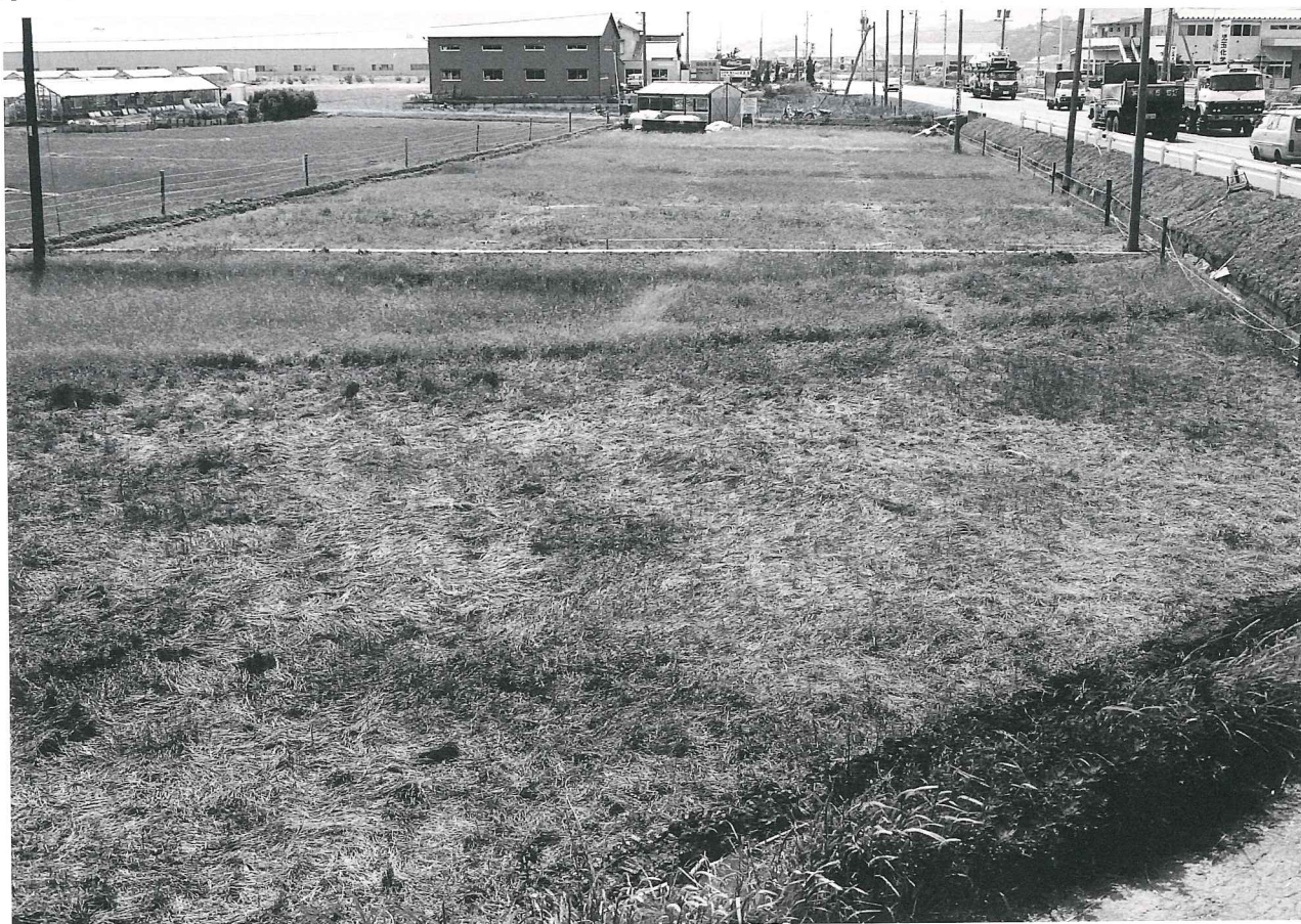
2・3F～2・3J区発掘調査前全景－国道南側・東から－
