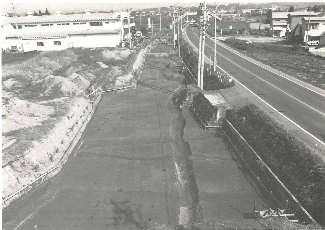
2 A ~ 2 D 区完掘全景 (国道北側・西から)
