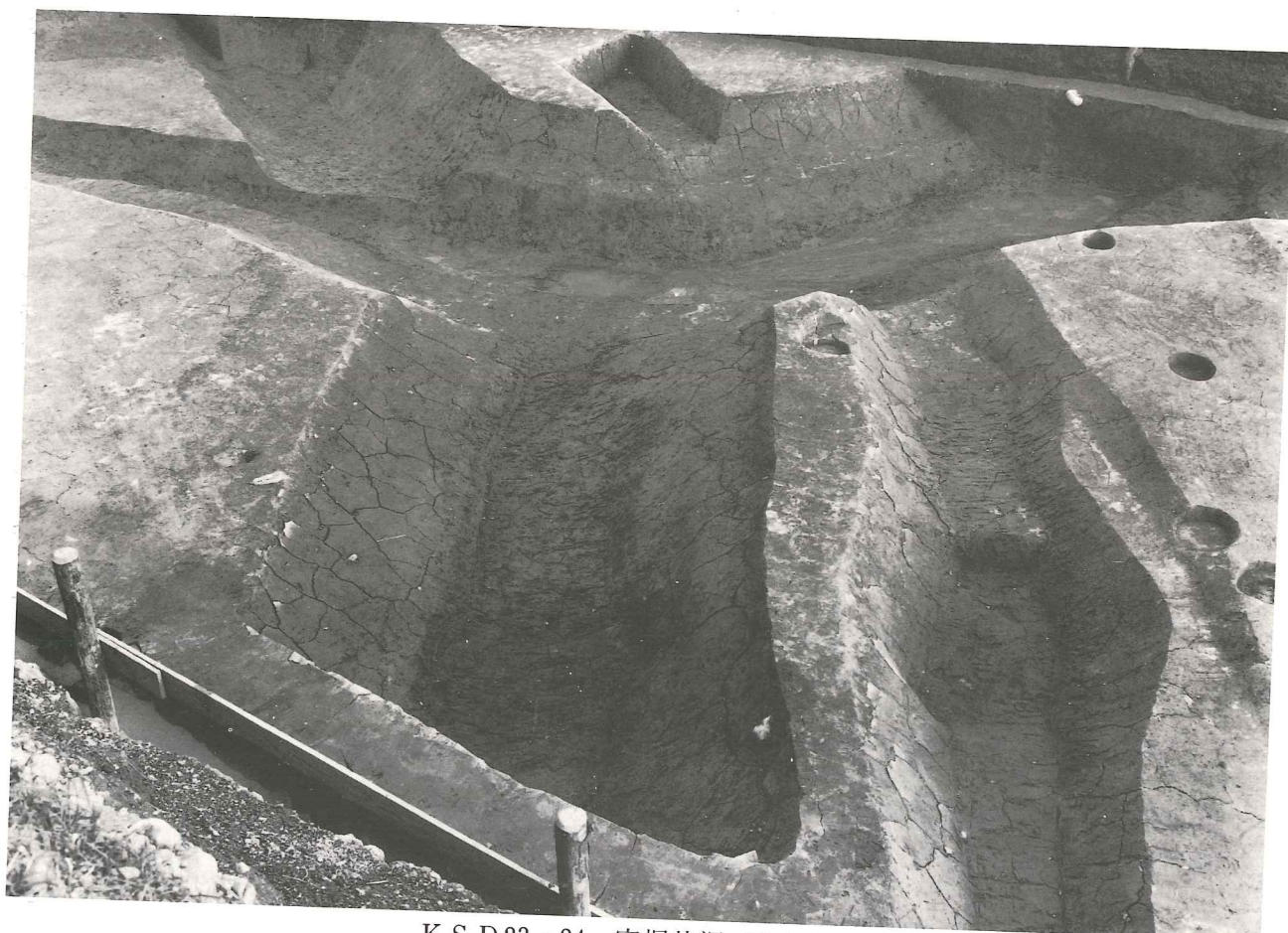
K S D 23・24 完掘状況 (北から)
