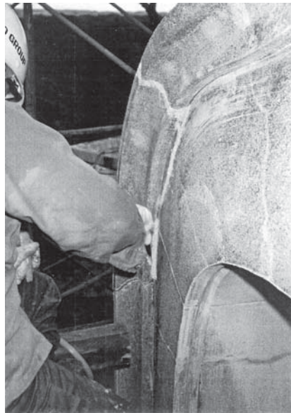
第 1 次保存修理 防水剤塗布作業状況
