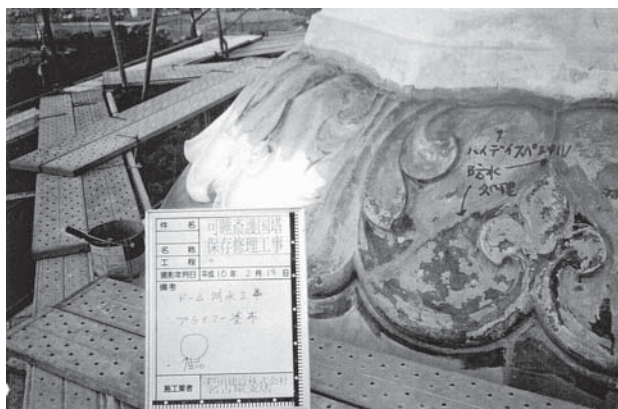
第2次保存修理 ハイソートコート塗布前プライマー処理状況
