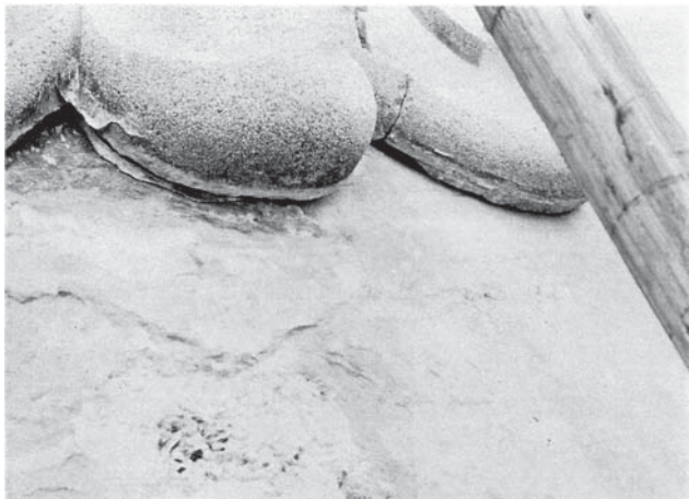
第 1 次保存修理前 劣化状況
