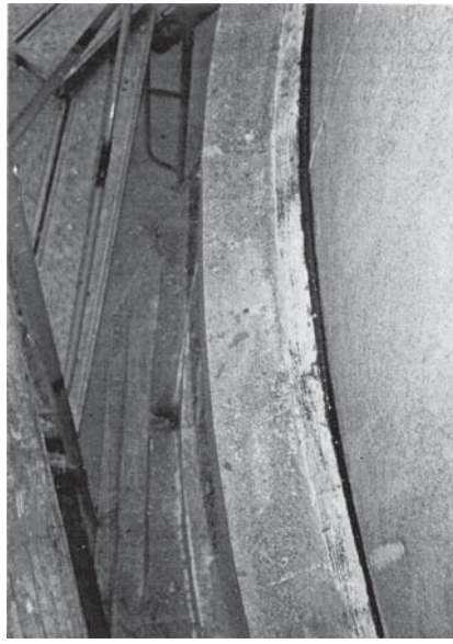
第 1 次保存修理 防水剤充填状況
