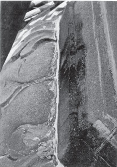
第 1 次保存修理 防水剤充填状況
