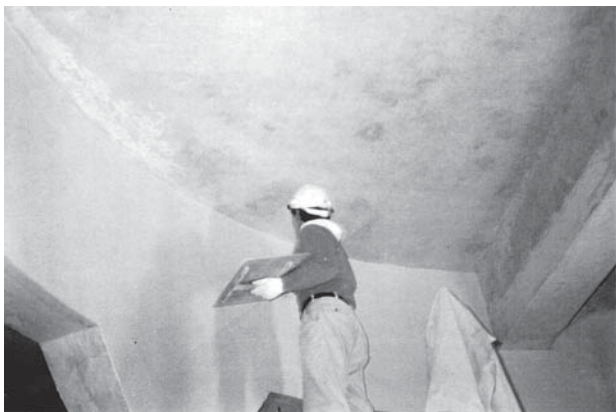
第2次保存修理 基壇内部梁部漆喰仕上作業
