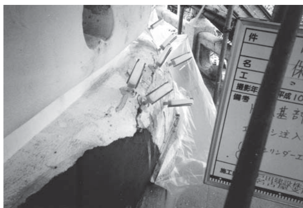
第2次保存修理 塔身下部亀裂再接着用ポリーシ樹脂注入作業
