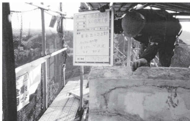
第2次保存修理 塔身下部剥落防止用ステンレスピン挿入作業
