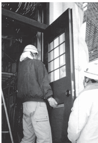
第2次保存修理 塔身建具取付作業
