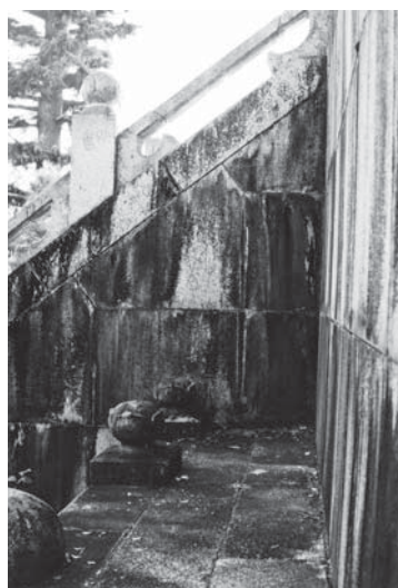
第2次保存修理前 正面階段状況
