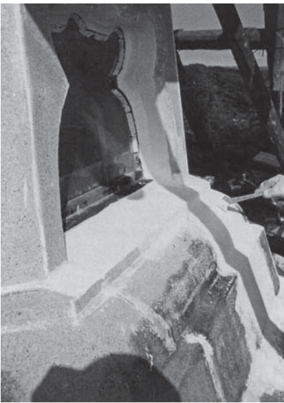
第 1 次保存修理 防水剤塗布作業状況
