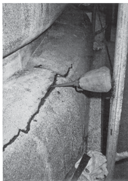
第1次保存修理 亀裂充填材状況
