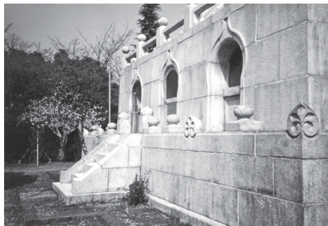
第2次保存修理竣工 西面基壇
