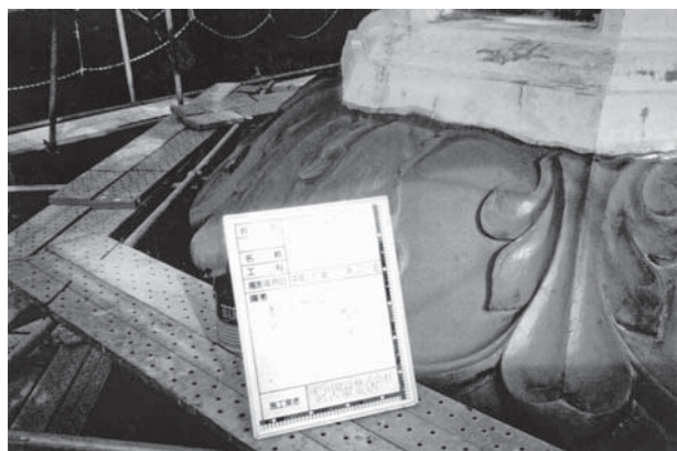
第2次保存修理 ハイソートコート防水剤塗布状況
