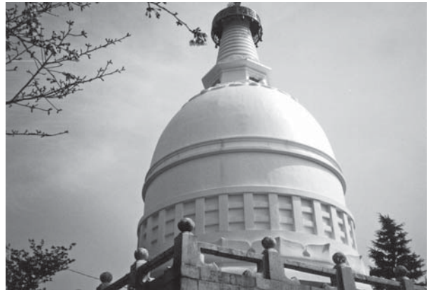
第2次保存修理竣工 塔身背面 近景
