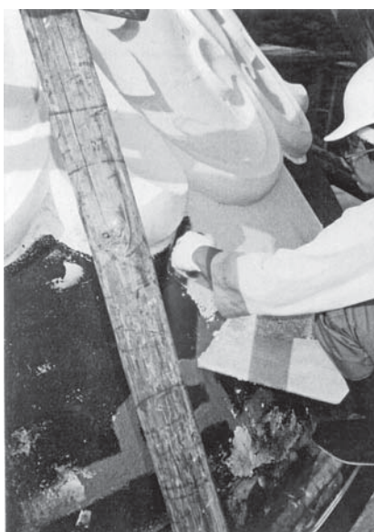
第1次保存修理 左官工事状況
