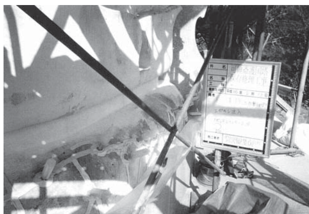
第2次保存修理 塔身下部亀裂再接着用ポリーシ樹脂注入作業
