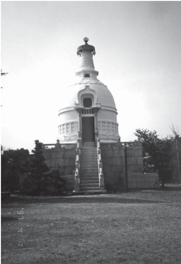
第2次保存修理竣工 正面
