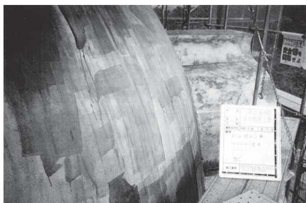
第2次保存修理 (ハイソートコート)下地処理プライマー塗布状況
