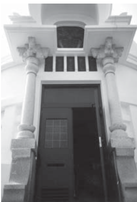
第2次保存修理竣工 塔身入口付近
