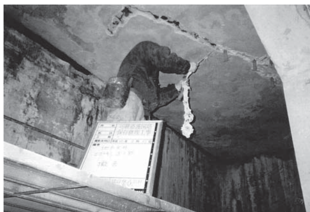
第2次保存修理 樹脂注入後クラック撤去作業
