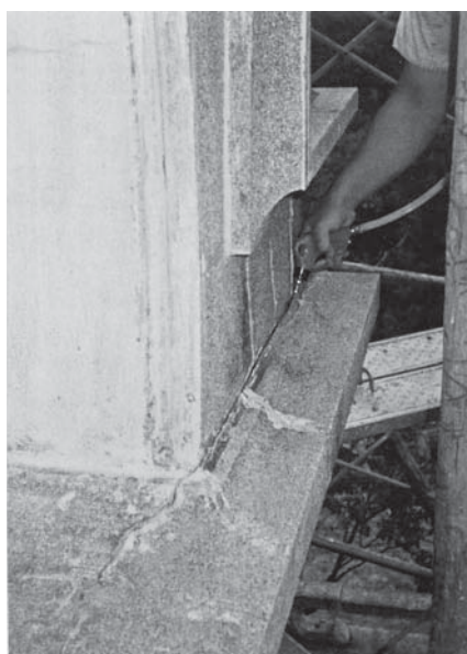
第1次保存修理 細部清掃状況
