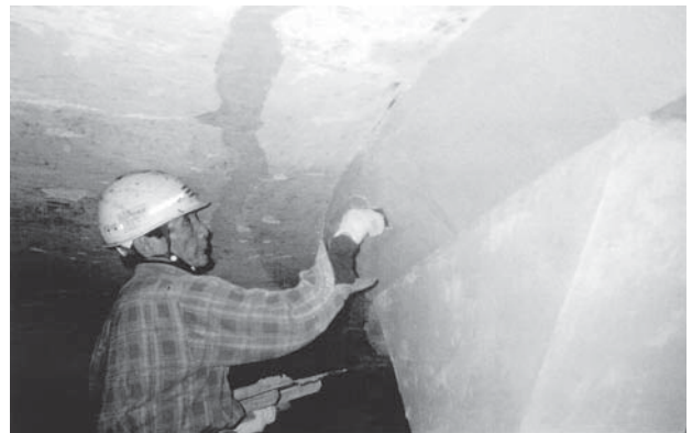
第2次保存修理 基壇内部梁部漆喰仕上作業
