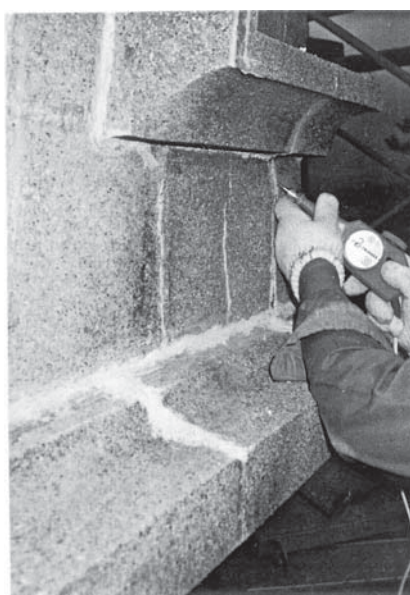
第1次保存修理 細部ハツリ状況
