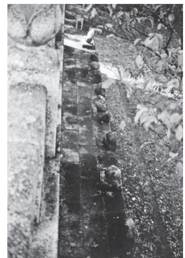
第2次保存修理前 基壇状況
