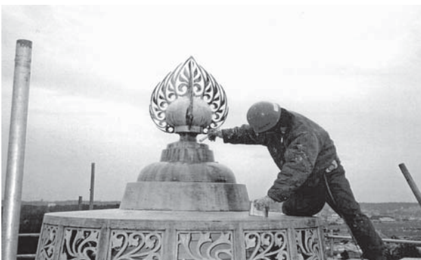
第2次保存修理 相輪防水剤塗布作業
