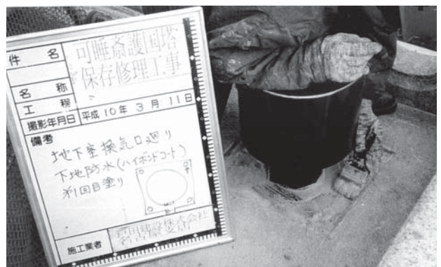
第2次保存修理 換気筒周囲防水処理
