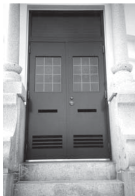
第2次保存修理竣工 塔身入口内部
