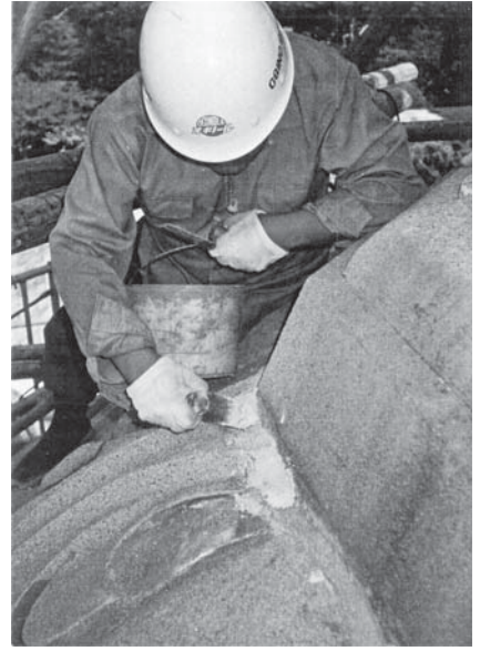
第 1 次保存修理 防水剤充填状況
