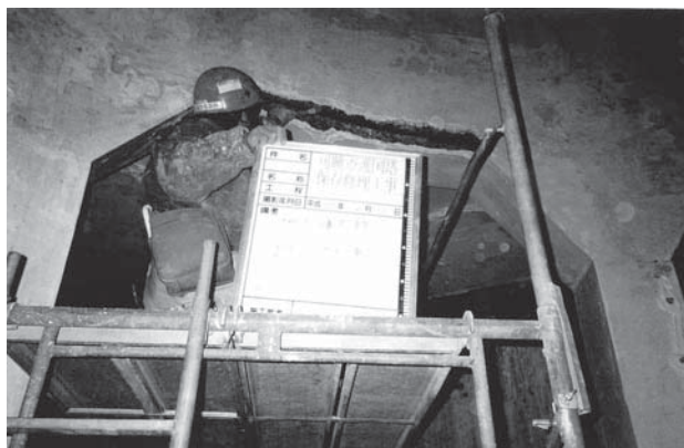
第2次保存修理 基壇内部梁鉄筋錆落作業
