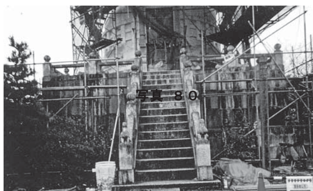
第2次保存修理 正面階段作業前状況
