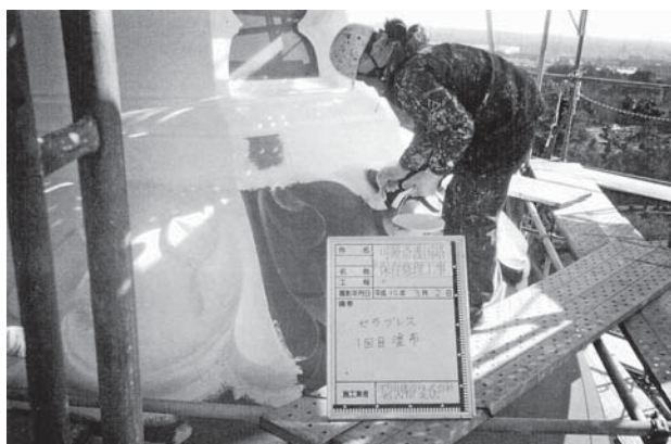
第2次保存修理 下地塗装作業
