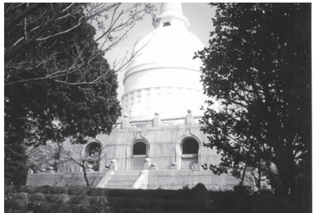
第2次保存修理竣工 塔身背面 遠景
