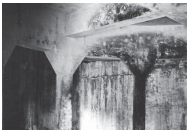
第2次保存修理前 地下室内部状況
