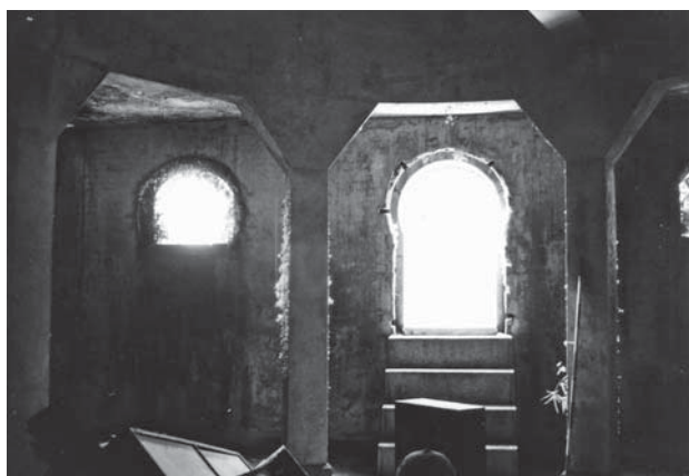
第2次保存修理前 地下室内部状況
