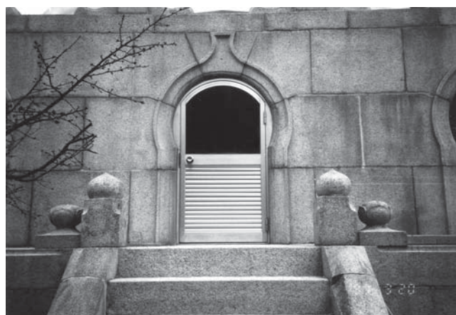
第2次保存修理竣工 基壇出入口
