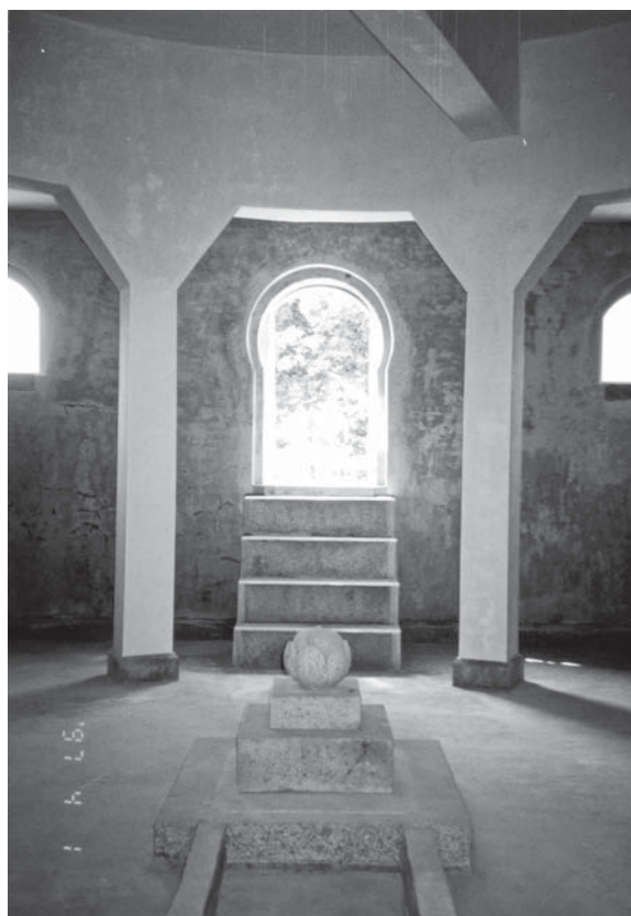
第2次保存修理竣工 地下室・祭壇
