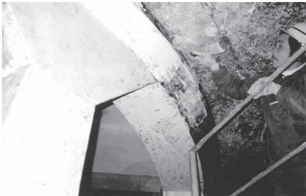
第2次保存修理 基壇内部付着藻類・カビ類の除去作業
