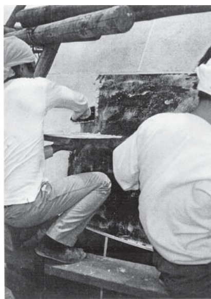
第1次保存修理 左官工事状況
