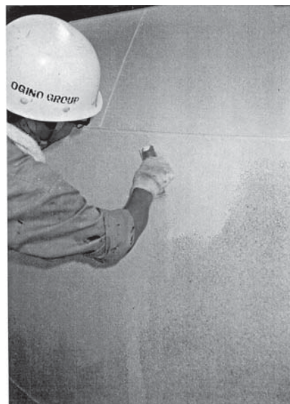
第 1 次保存修理 仕上作業状況
