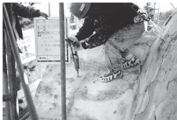
第2次保存修理 塔身亀裂再接着用ポリーシ樹脂注入作業
