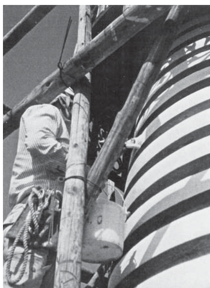
第1次保存修理 防水材塗布状況
