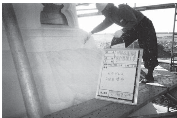
第2次保存修理前 中塗塗装作業
