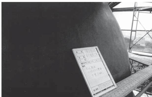
第2次保存修理 ハイソートコート防水剤塗布状況
