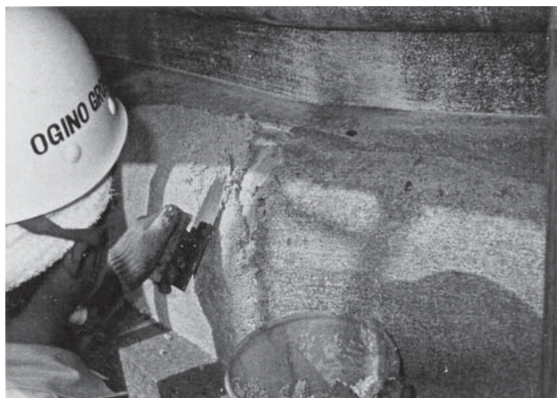
第1次保存修理 充填材塗布状況
