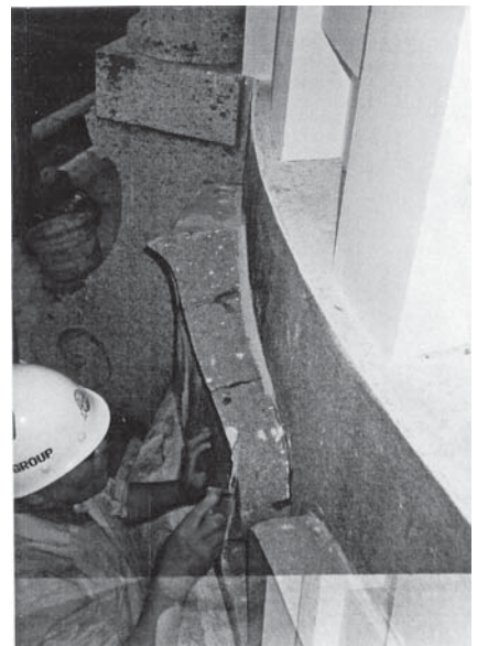
第 1 次保存修理 防水剤塗布作業状況
