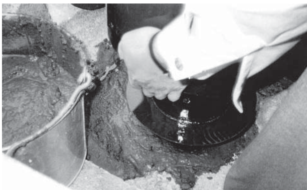
第2次保存修理 換気筒設置作業
