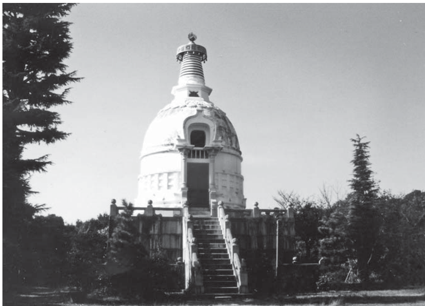
第2次保存修理前 全景（南より）
