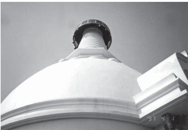
第2次保存修理竣工 塔身上部・相輪
