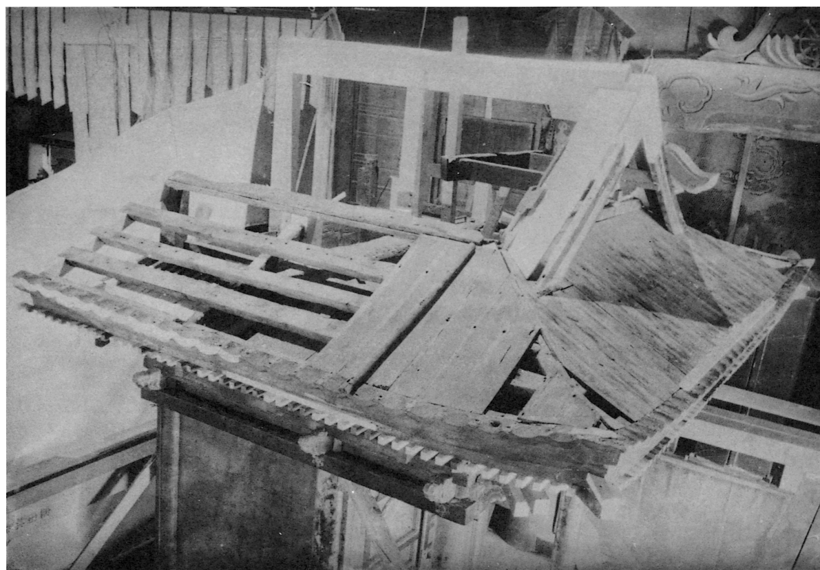
116 組立 小屋組及屋根
