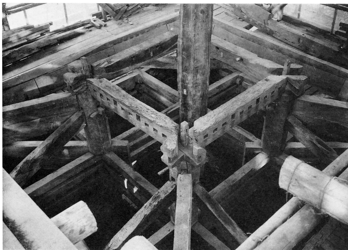
59 解体 一重 檼掛 各面とも中2本の檼尻を突通し鼻栓打ちにしてあった。
