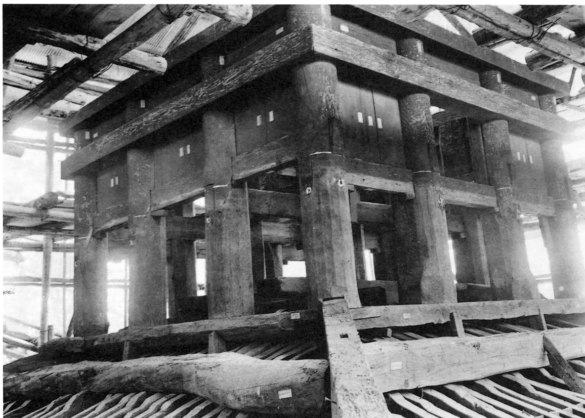
41 解体 三重軸部 軸部材、長押ともすべて当初のものである。柱の露出面の風化は大きく就中東面の風蝕は甚だしかった。現在腰貫の楔が桁行、梁行ともに下楔になっているが、大正修理時に打替えられたもので当初は梁行が上楔で、貫には3種咬合わせの仕口になっていた。
