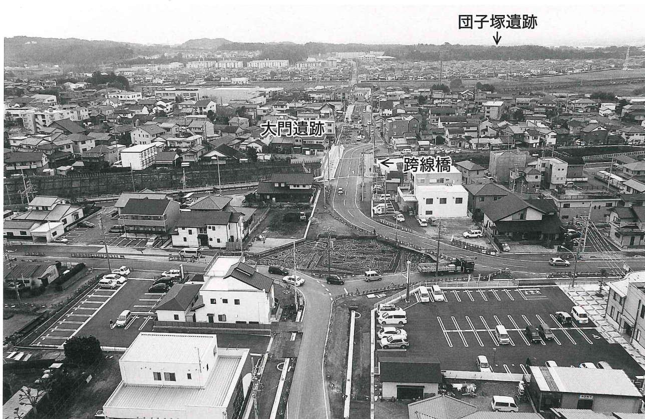
(1) 第84次－1発掘調査区空中写真遠景 (遺跡の南端に近い場所の調査区である。J R東海道線の跨線橋より 南側は大門遺跡となる。さらに奥の段丘には団子塚遺跡が所在する。北より)
