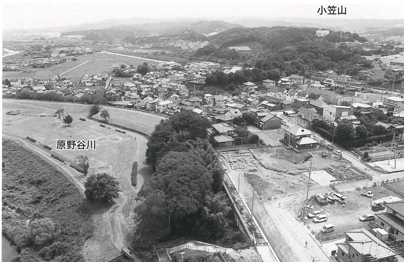
(1) 第81次・第82次－1 北発掘調査区空中写真遠景 (遺跡の北東端に近い場所の調査区である。左側に原野谷川が浸食する段丘崖線、上方には小笠山山麓が展開している。西より)
