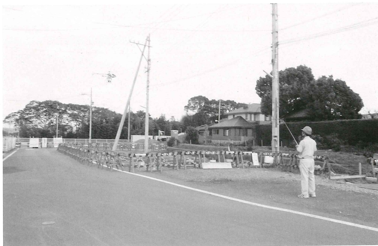
(2) ラジコンヘリによる写真撮影・測量作業風景
