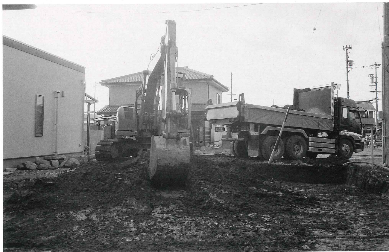
(2) 重機による表土掘削作業 (1区ではほとんど包含層は存在しなかったため、遺構確認面まで表土を除去した。)
