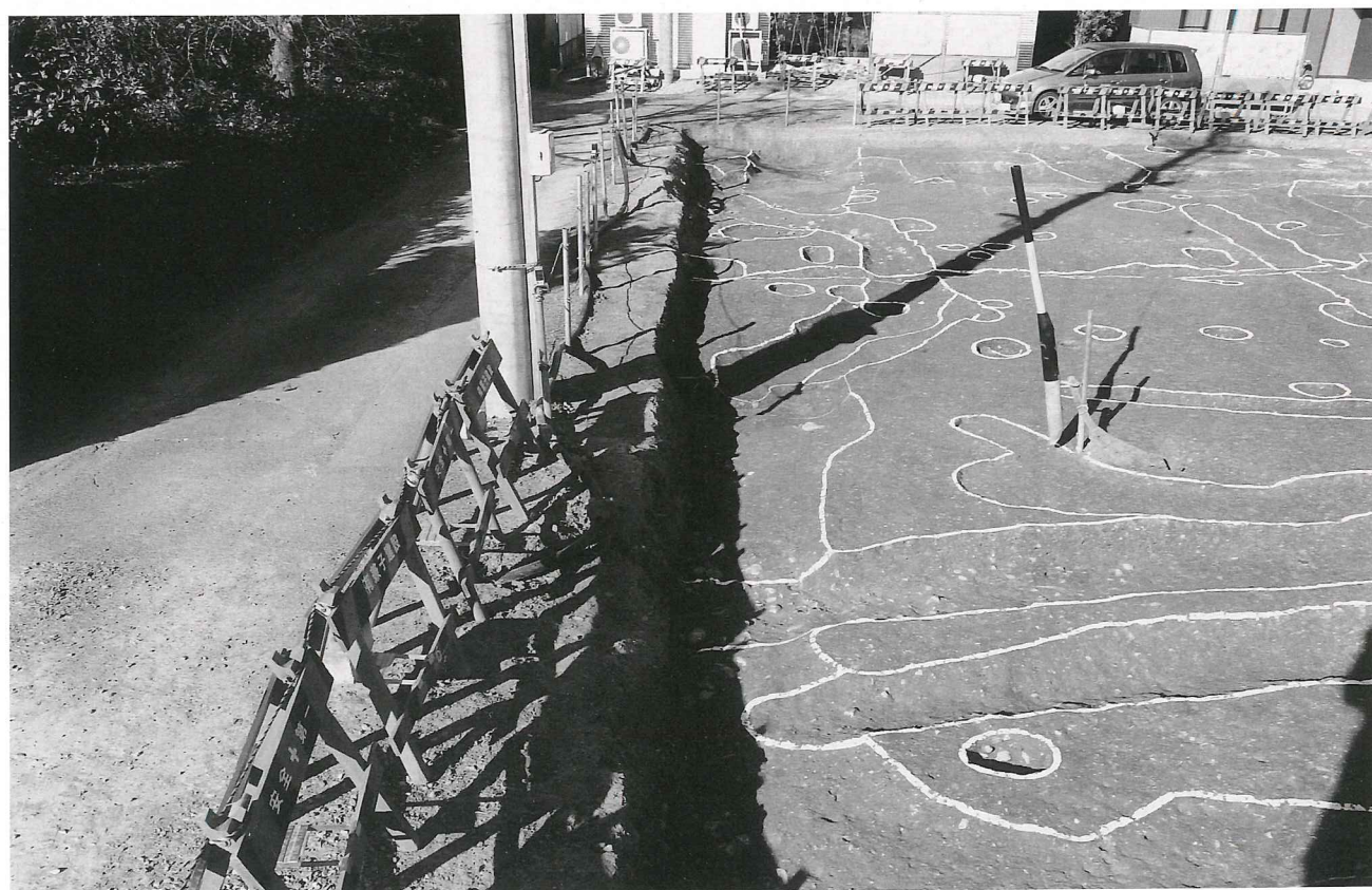
(2) S D68 (南北方向の近世の区画溝が検出された。蛇行しているため排水の用途も考えられる。南より)
