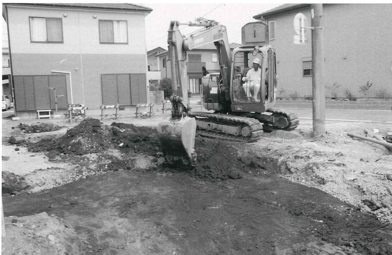
(1) 重機による表土掘削作業 (調査区内での包含層は全く存在しなかったため、遺構確認面まで表土を除去した。)
