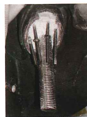
開口部から覗く 内部に樹脂が充填されている（矢印は開口部端部）
