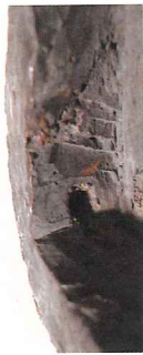
写真 15 ホゾ孔 右側側壁 はつり痕
