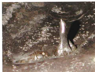
写真11 欠損5の体躯内のハンダ
