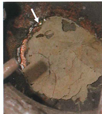
写真 21 頭部内部 頂蓮華部分
