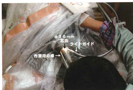
芯金固定作業
