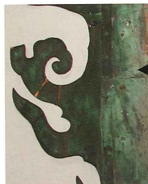
写真10 元に戻した状態
