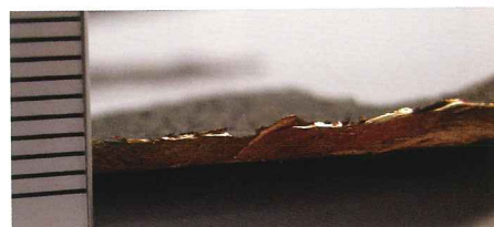
写真 100 ホゾ取り付け部分切除後の断面
