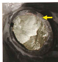
開口部から覗く 内部に樹脂が充填されている（矢印は開口部端部）
