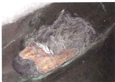
写真10 欠損5 ハンダを一部取り除いた状態
