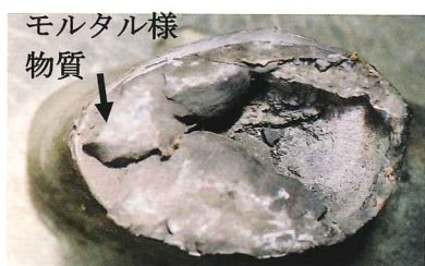
写真 91 ホゾ取り付け部分
