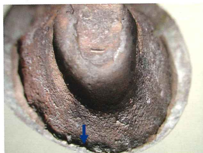
写真 102 中子砂を全て除去後踵側の内部
