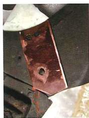
写真17 銅板の裏打ち
