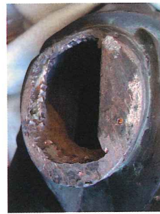
写真 23 切除作業 途中
