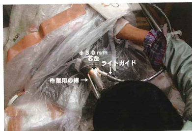
足の芯金の固定作業 文字通り手探り状態です
