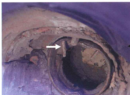
写真 26 体躯内部 首の留め金具 右側
