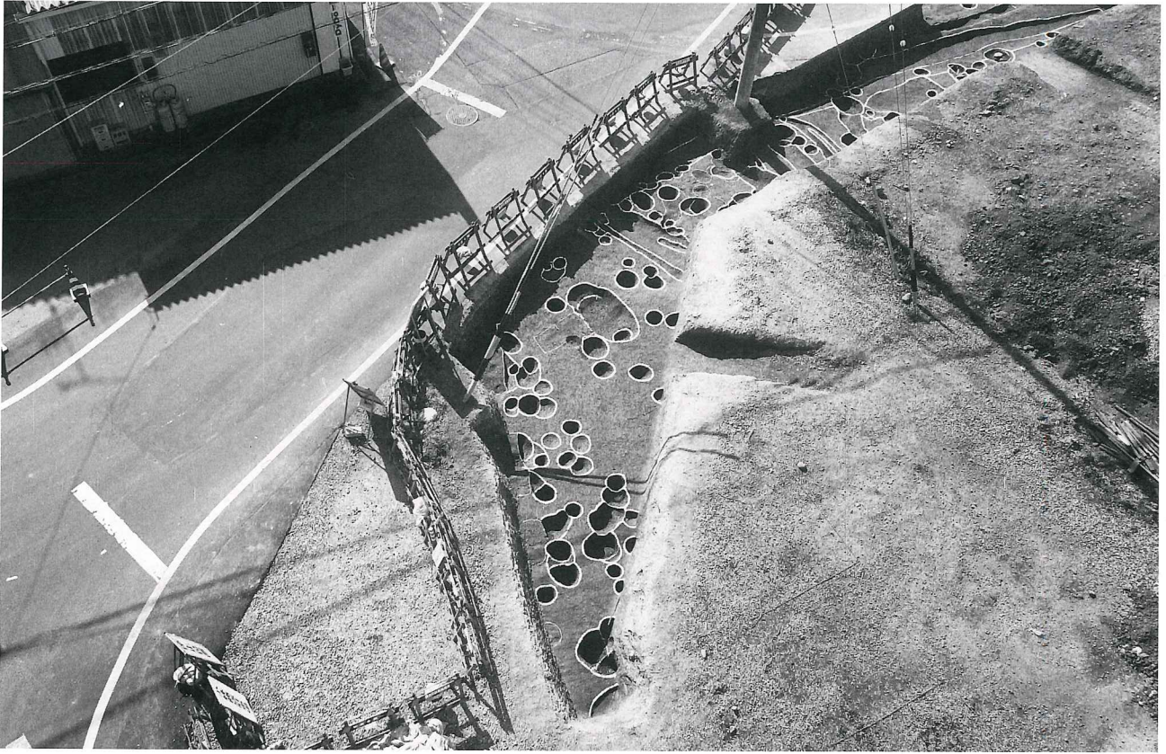
(1) 第77次発掘調査区東半部分空中写真全景 (遺構面の保存状況は良く、弥生時代後期の竪穴住居、柱穴や土坑が多数見られる。北東より)
