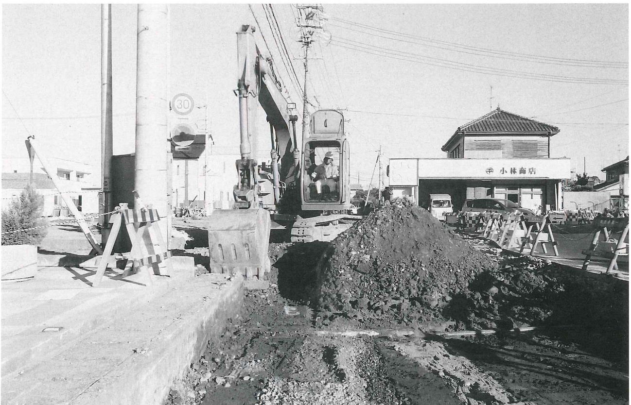
(2) 重機による表土掘削作業 (西半部分では包含層がほとんど存在していないため、遺構確認面まで表土を除去した。)
