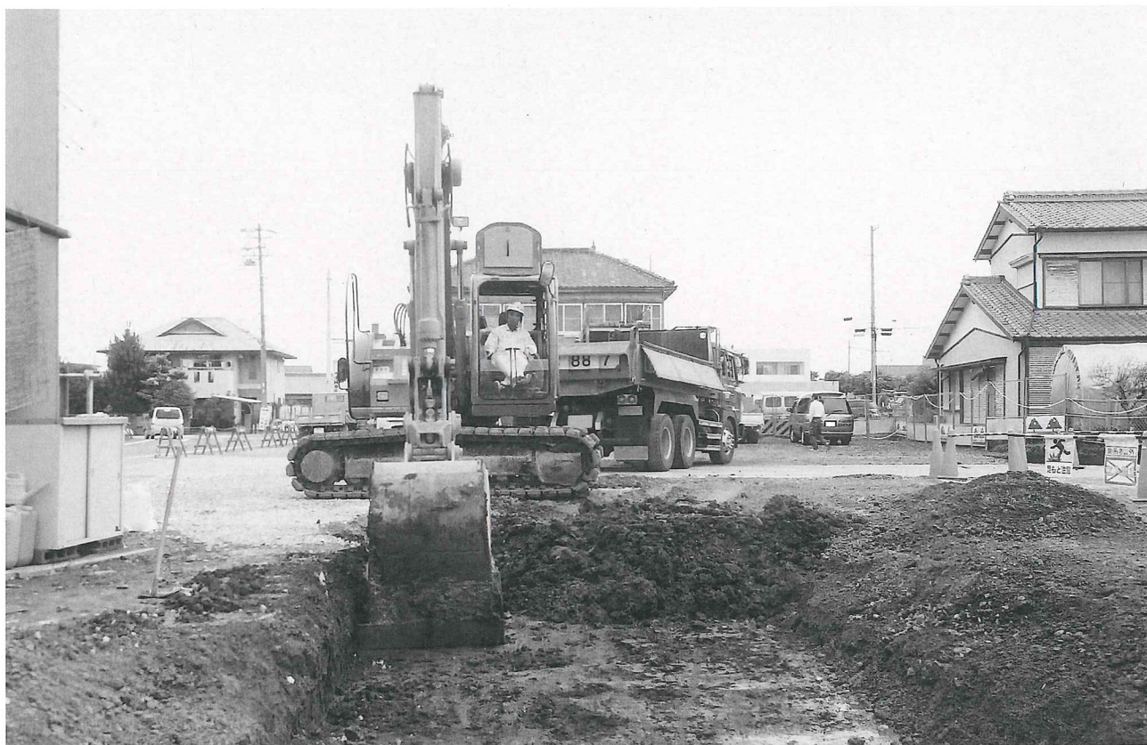
(1) 重機による表土掘削（第70次－1発掘調査区部分である。）
