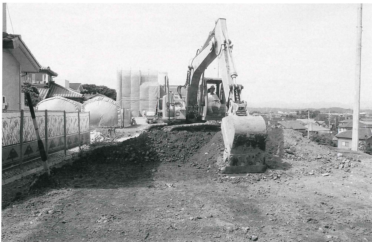
(2) 重機による表土掘削作業 (包含層がほとんど存在していなかったため、遺構各確認面まで表土を除去することができた。)
