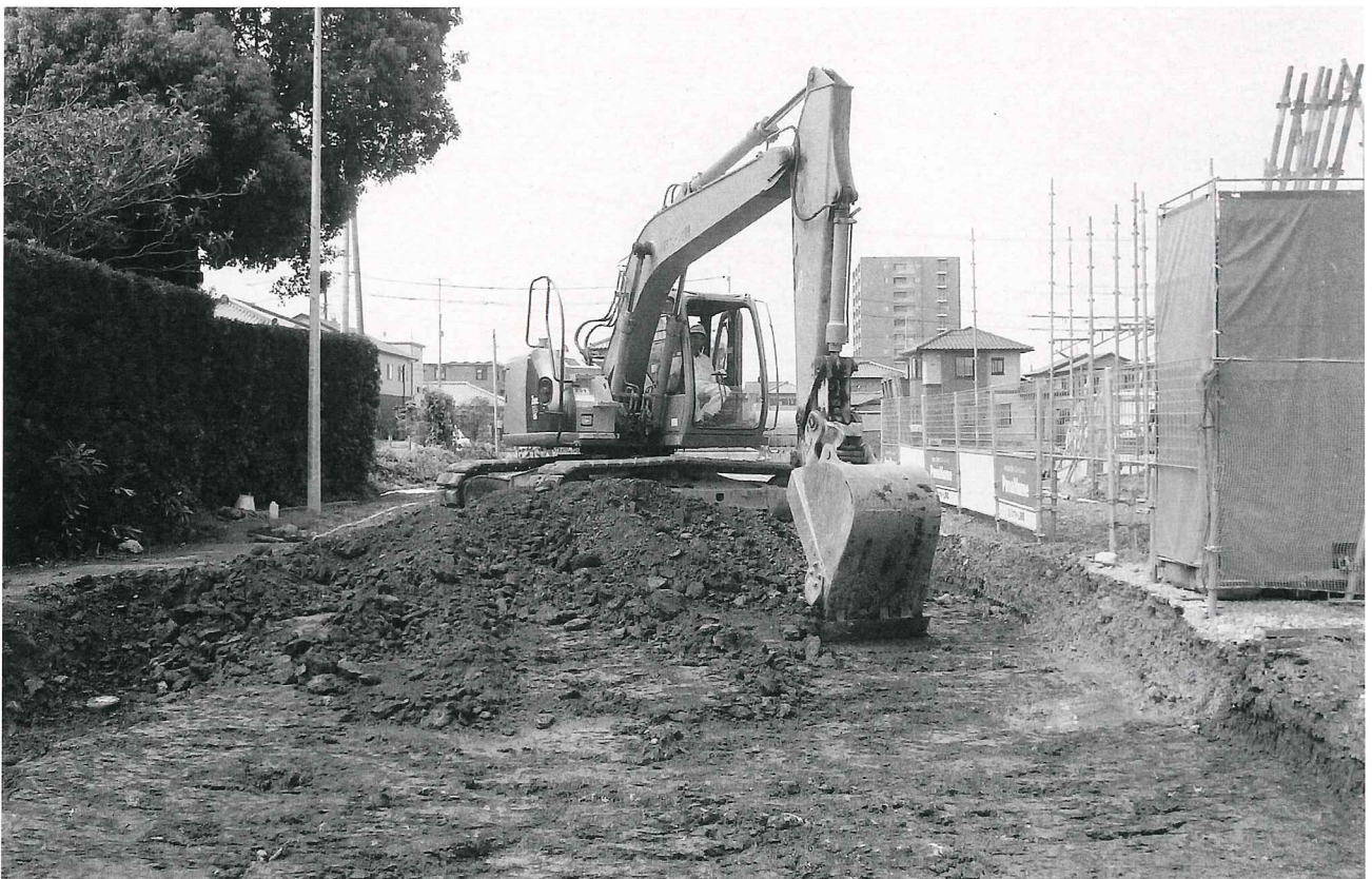
(2) 重機による表土掘削作業（表土の掘削を行った。）
