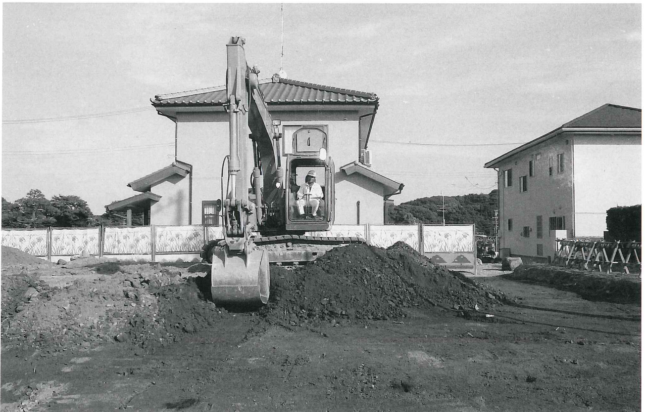
(2) 重機による表土掘削作業 (包含層がほとんど存在していなかったため、遺構確認面まで表土を除去することができた。)
