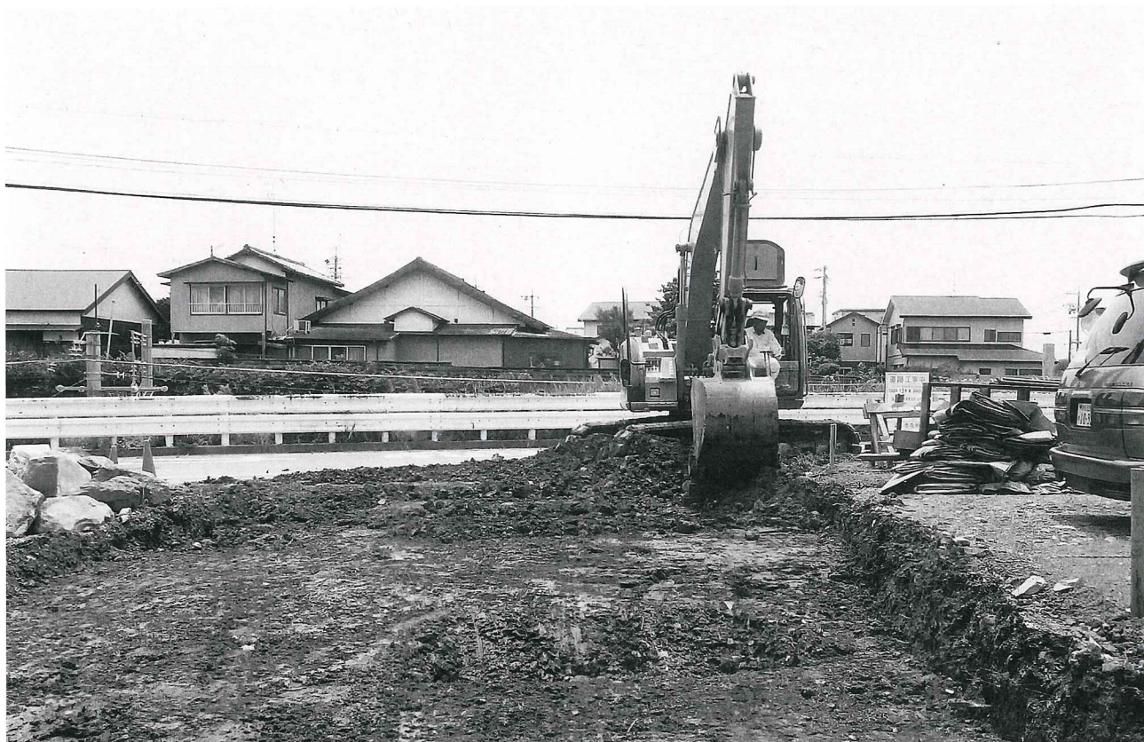
(1) 重機による表土掘削（包含層がほとんどなかったため遺構確認面までの表土を掘削した。）
