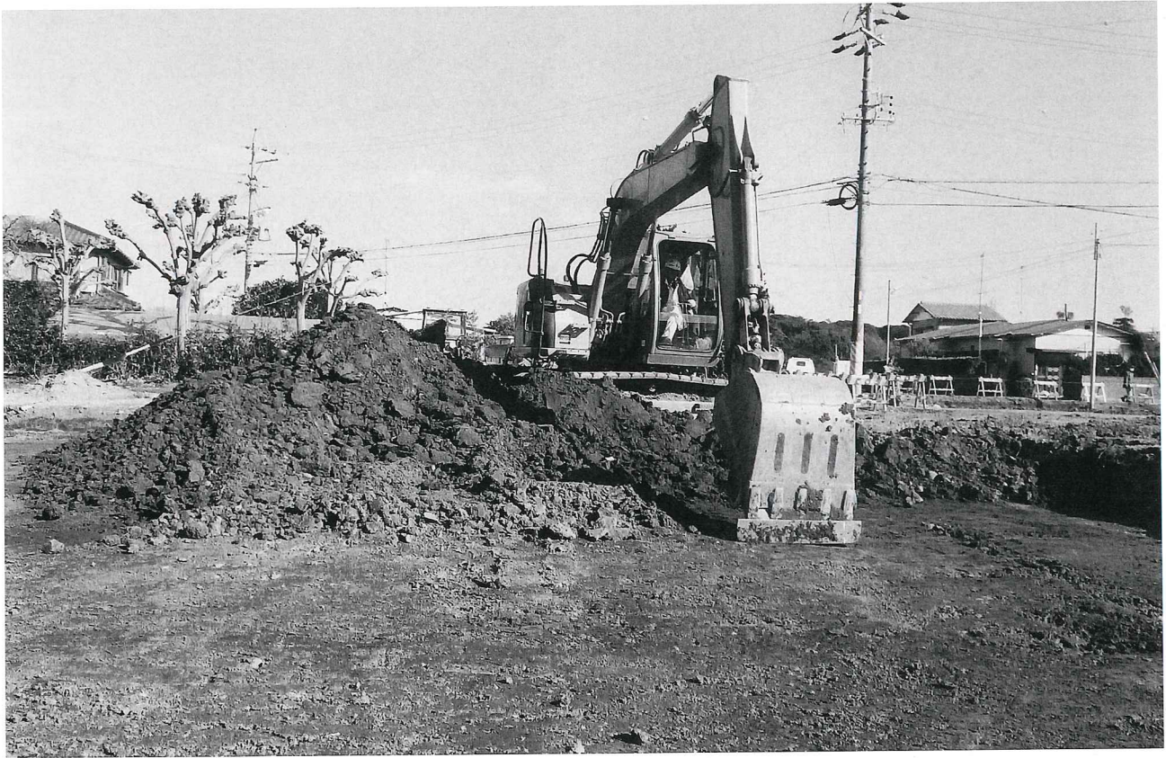
(1) 重機による表土掘削作業（包含層の上面まで表土を掘削した。）
