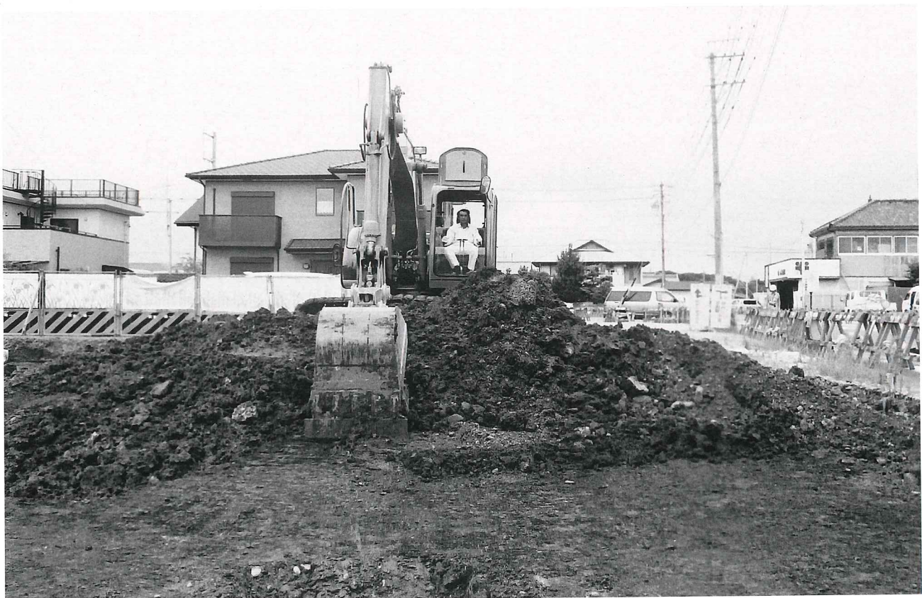
(2) 重機による表土掘削
