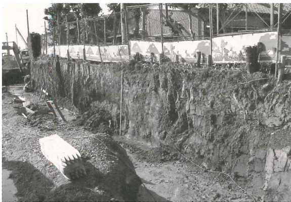
7. 浅羽大囲堤 道路部分截ち割り状況
