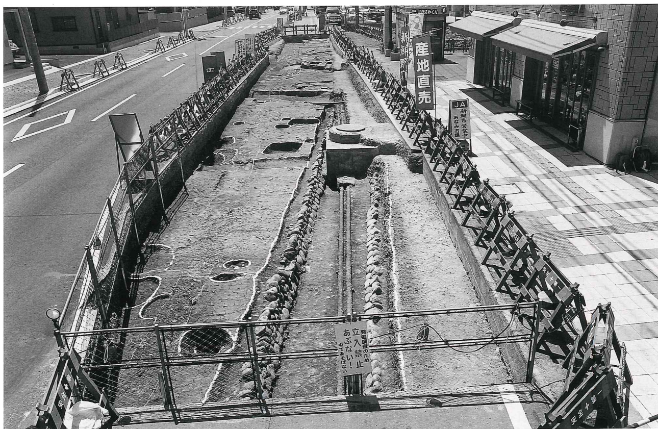
(2) 第58次発掘調査区全景 (手前の石垣をもつ溝は近代の屋敷地の南側を区画する溝である。東より)
