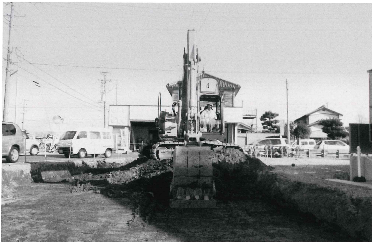
(1) 重機による表土掘削作業風景 (東端で一部包含層は確認できたが、概ね表土を遺構確認面まで除去することができた。)
