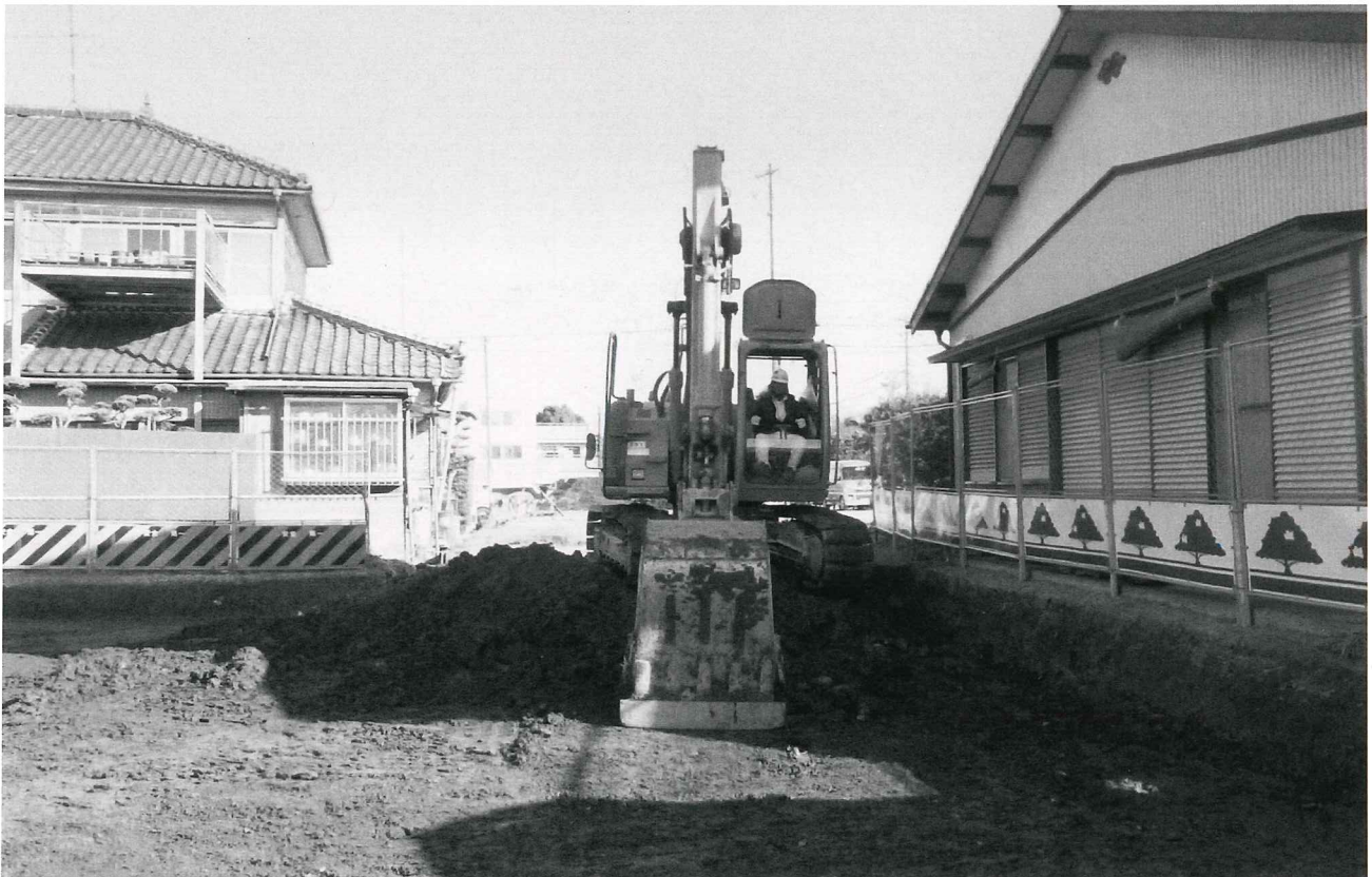
(2) 重機による表土掘削作業風景（包含層上面まで表土を除去することができた。）
