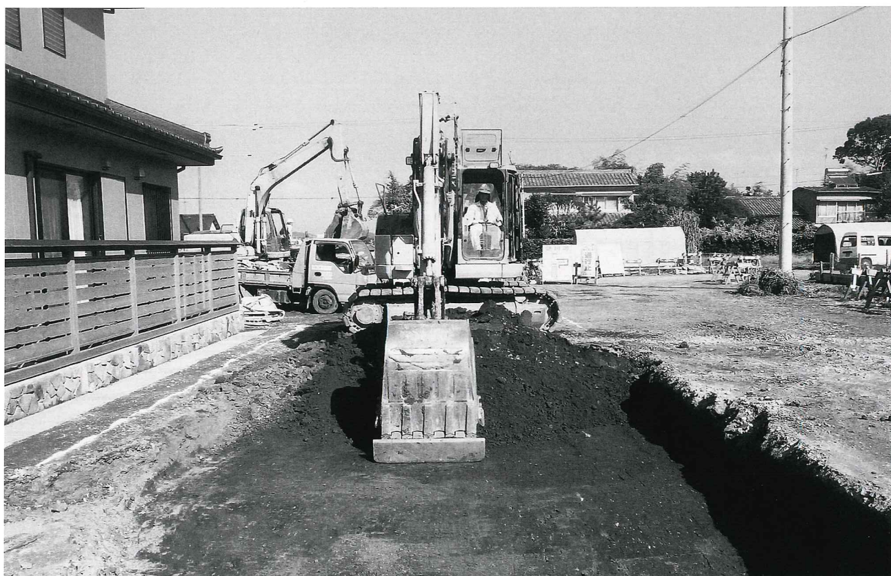
(2) 重機による表土掘削作業風景 (包含層がほとんど存在していないため、遺構確認面までの表土を除去した。)
