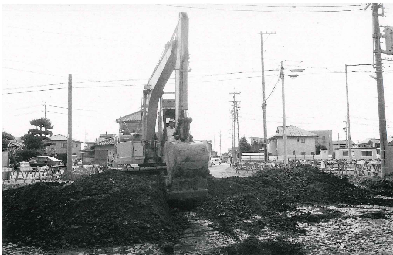
(2) 重機による表土掘削作業風景 (良好な包含層が存在していたため、包含層上面までの表土を除去した。)
