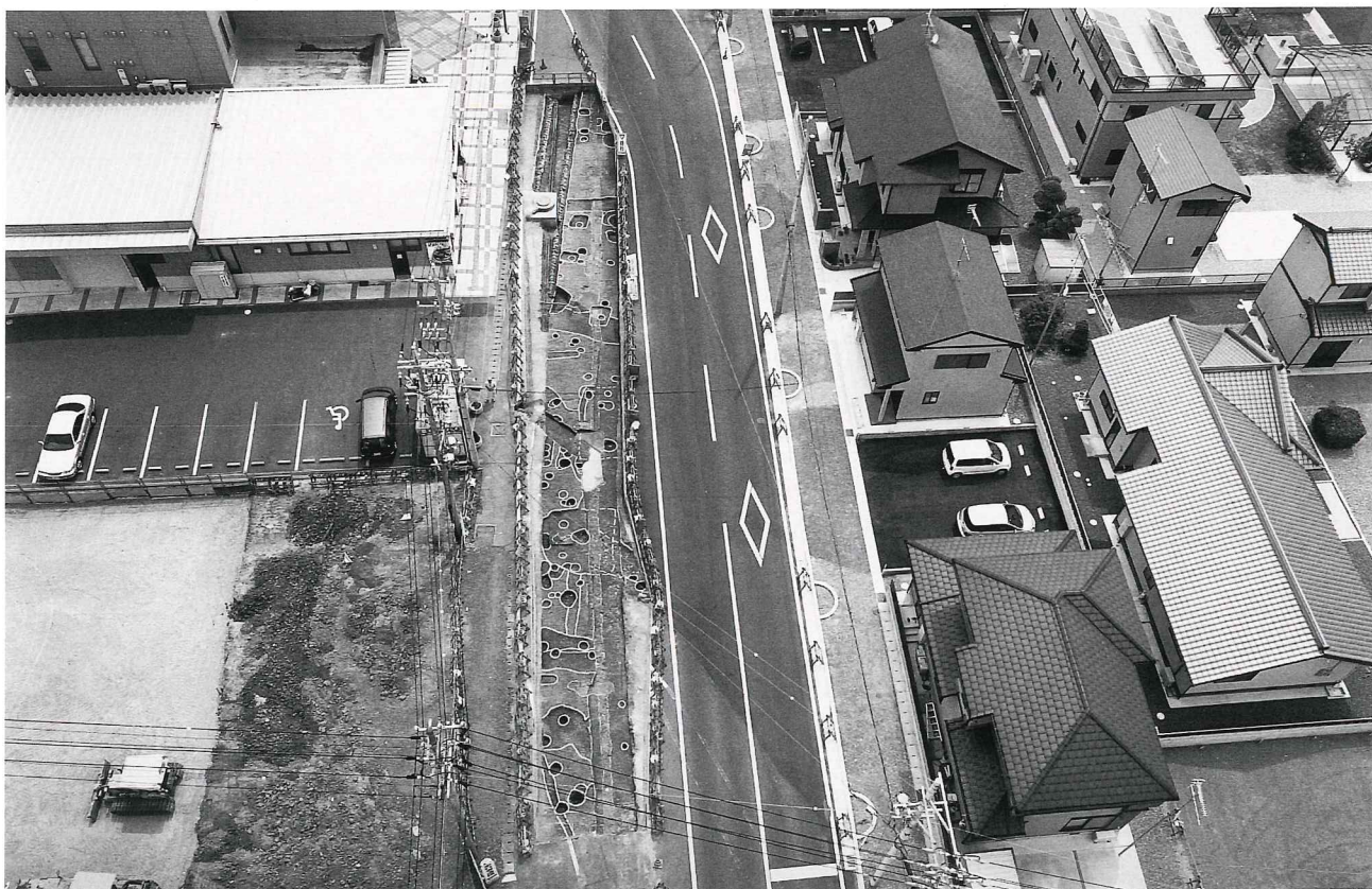
(2) 第58次発掘調査区空中写真全景 (奥の方に奈良時代の土間式の大型掘立柱建物が、手前には弥生後期と古墳後期の竪穴住居が見られる。西より)
