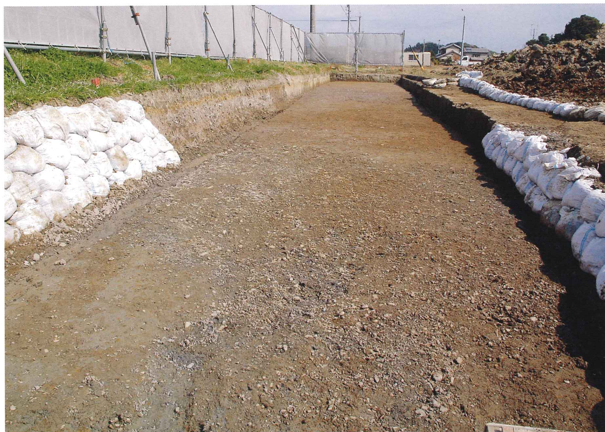
2 : 東工区／調査区西側（西から）
