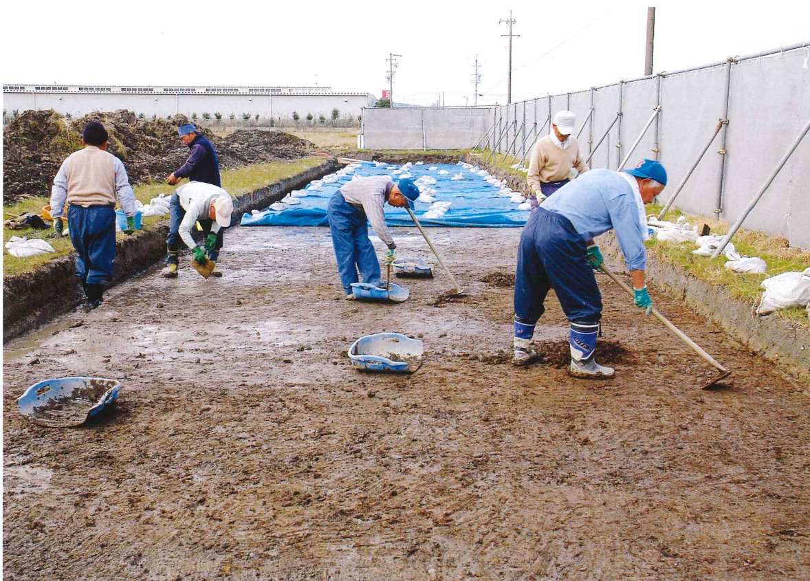
2：遺構検出作業風景
