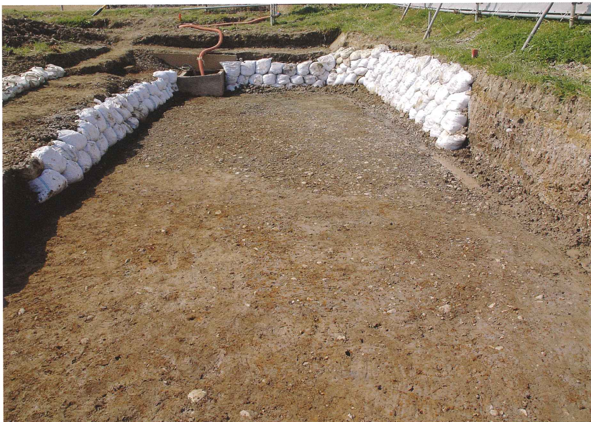
1 : 東工区／調査区西側（東から）
