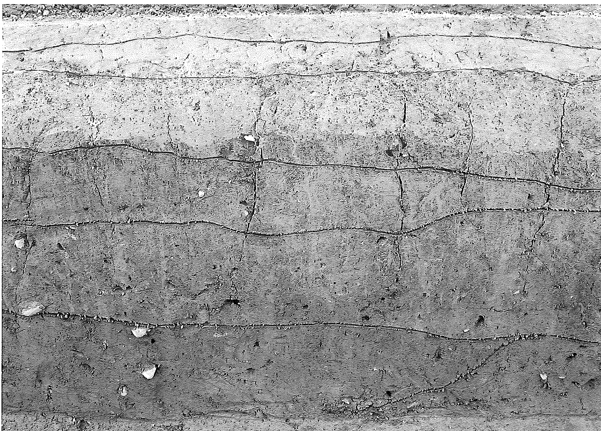
2：平成18年度 第3工区／調査区西壁・噴砂検出状況（東から）
