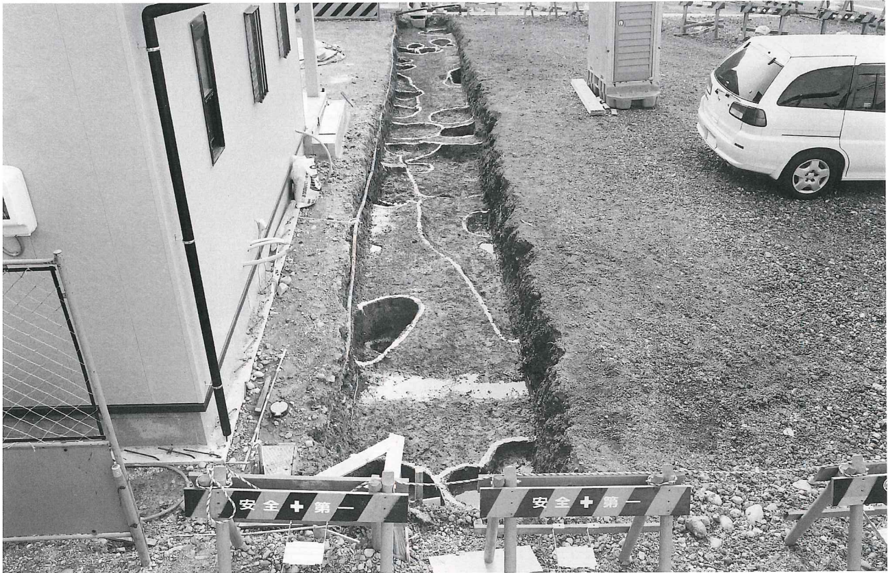
(1) 南側溝分西調査区全景 (S H18柱穴やS Z16の溝が検出されている。東より)
