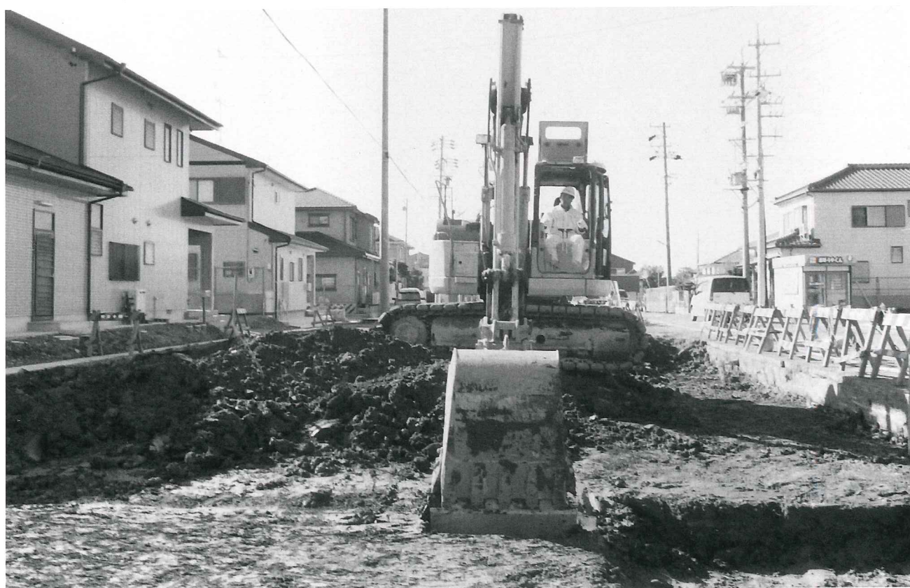
(2) 重機による表土掘削作業 (東端で一部包含層が確認できたが、概ね表土を遺構確認面まで掘削することができた。)
