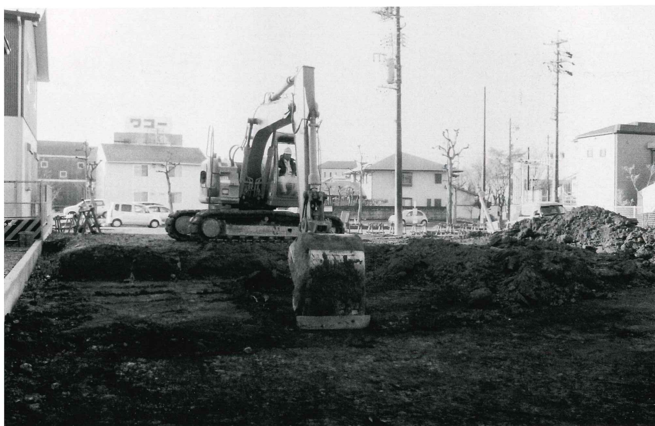
(2) 重機による表土掘削作業風景 (包含層が存在しなかったため、遺構確認面まで表土掘削をすることができた。)
