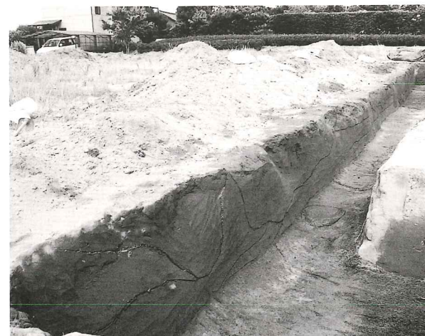
6. 松原居廻遺跡 南トレンチ全景（西から）
