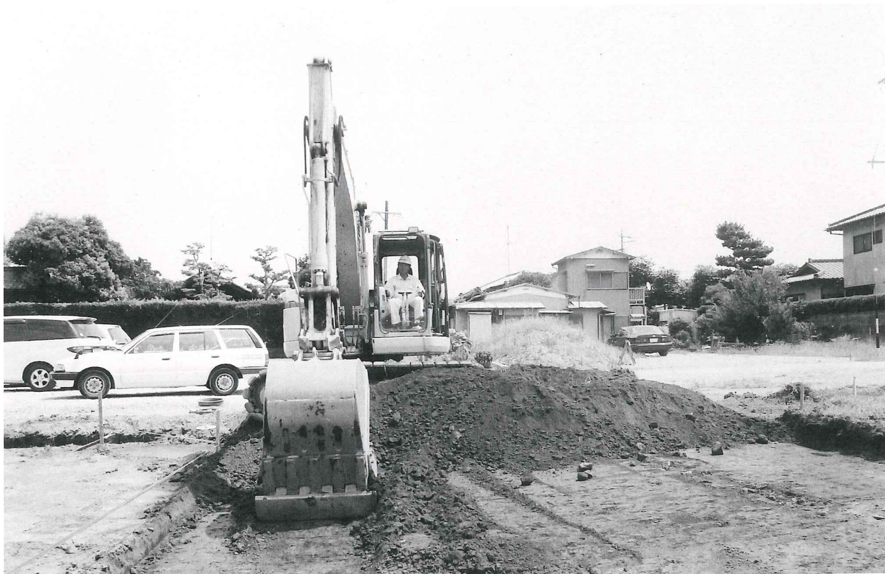
(1) 重機による表土掘削作業風景（包含層上面まで表土を掘削することができた。）
