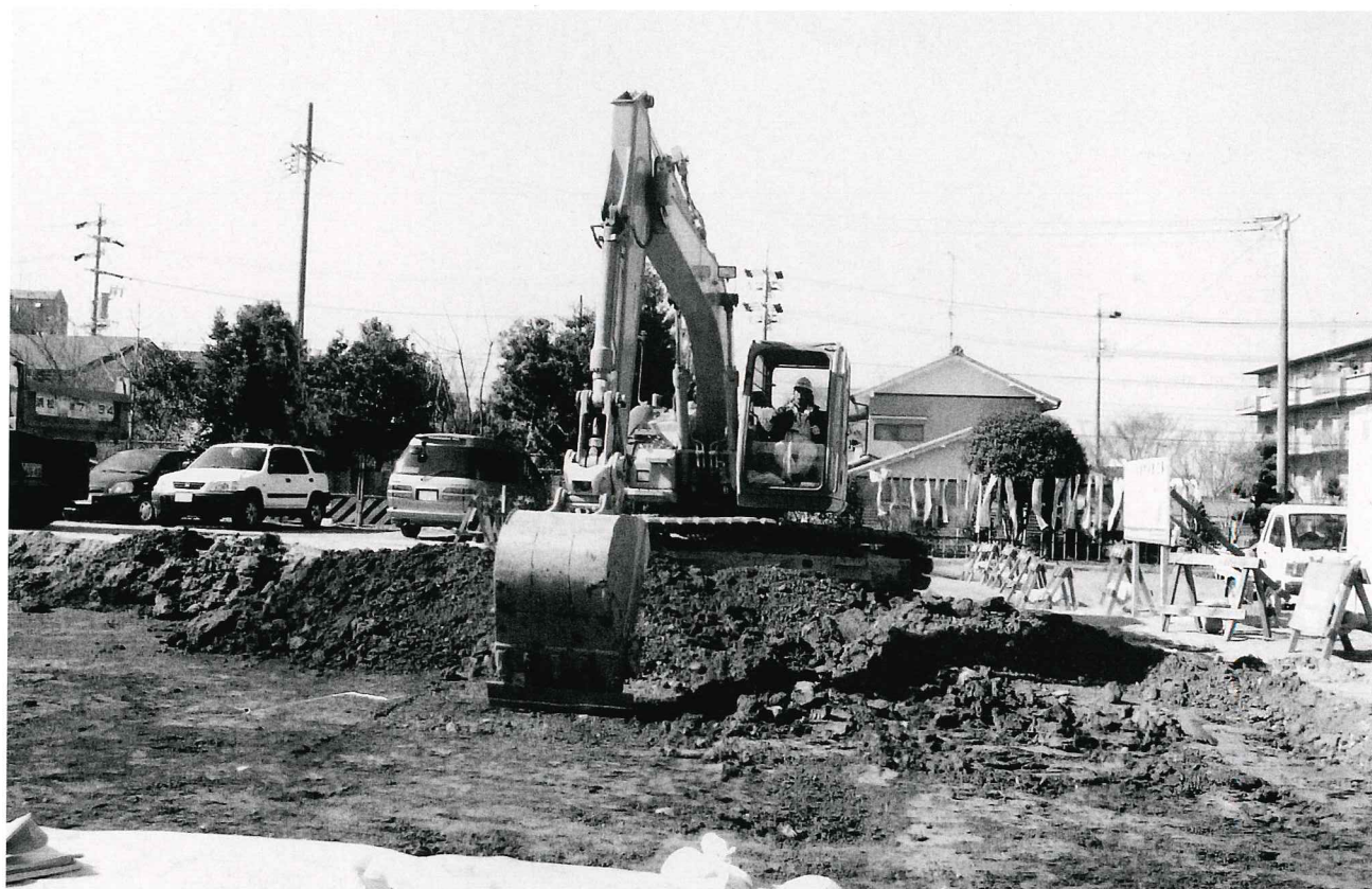
(1) 重機による表土掘削作業風景 (包含層が存在しなかったため、遺構確認面まで表土掘削をすることができた。)
