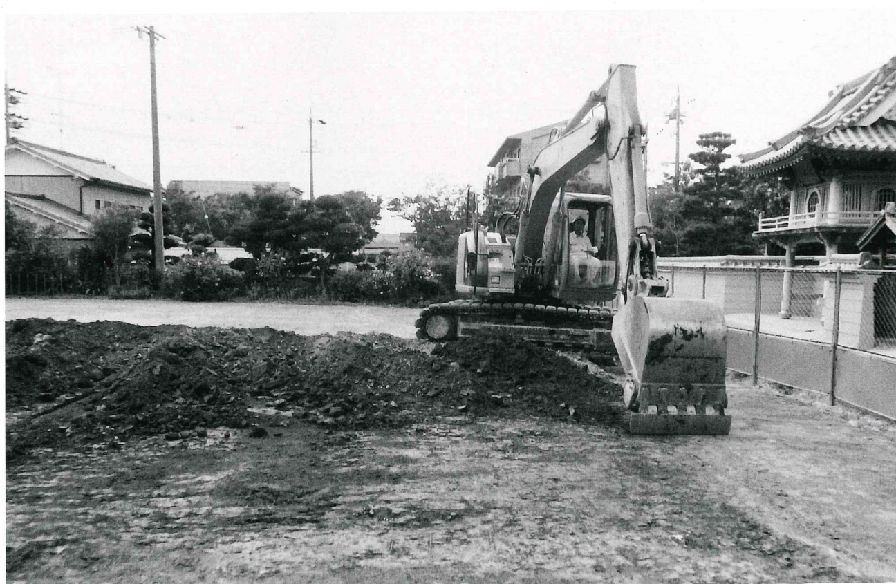
(2) 重機による表土掘削作業風景 (包含層が存在しなかったため、表土を遺構確認面まで掘削することができた。)
