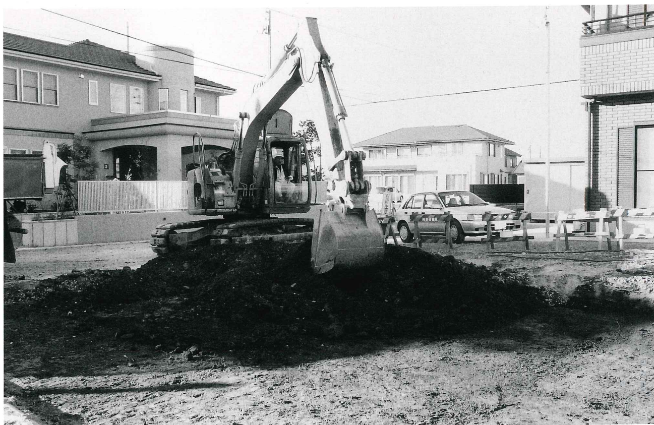
(2) 重機による表土掘削作業風景 (包含層が存在しなかったため、遺構確認面まで表土掘削ができた。)
