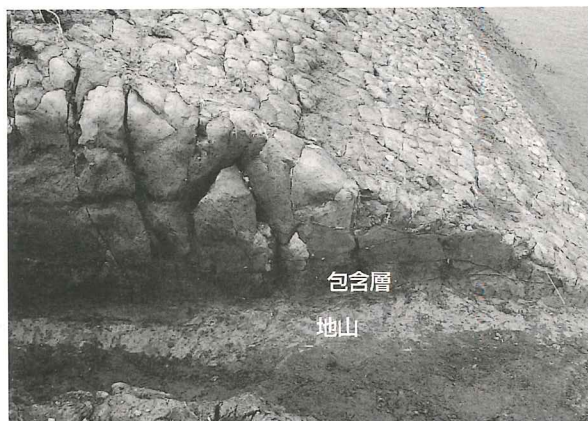
2. 試掘トレンチ断面
