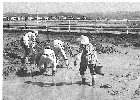
写真2 現場の復旧作業
