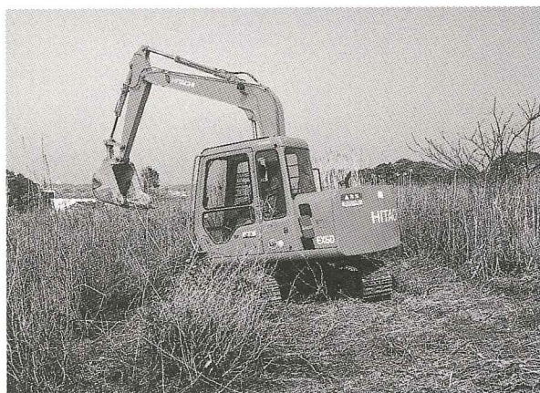
写真1 A地点 伐採作業
