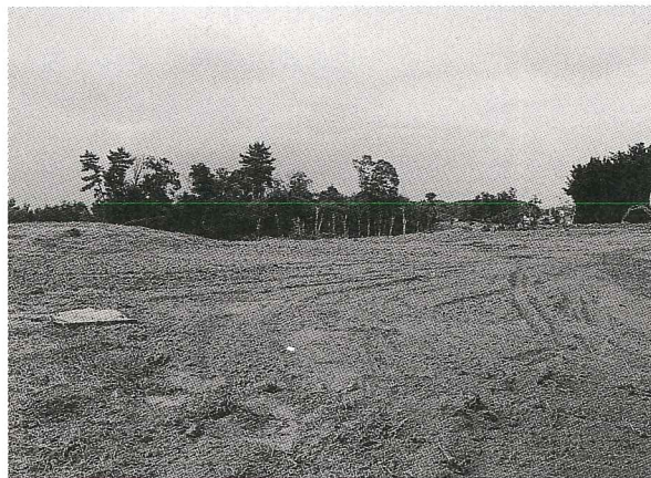
写真10 B地点 埋め戻し作業後（盛土後）
