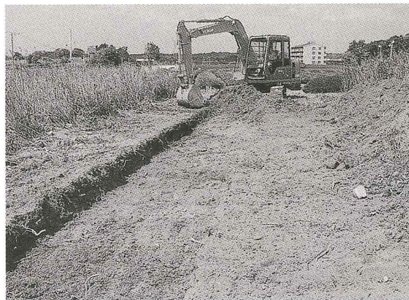
写真2 A地点 掘削作業
