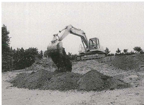
写真9 B地点 埋め戻し作業中（盛土中）
