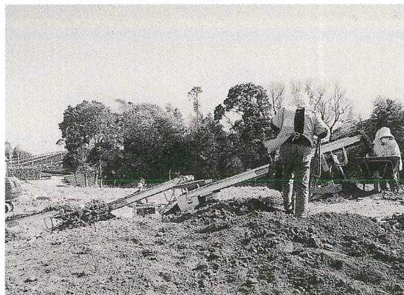
写真6 B地点 埋め戻しの様子
