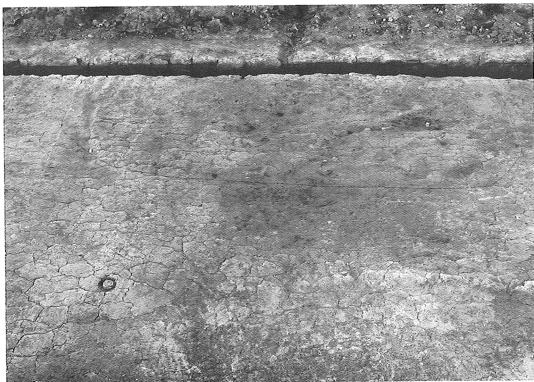
J-1 調査状況（南側から）
