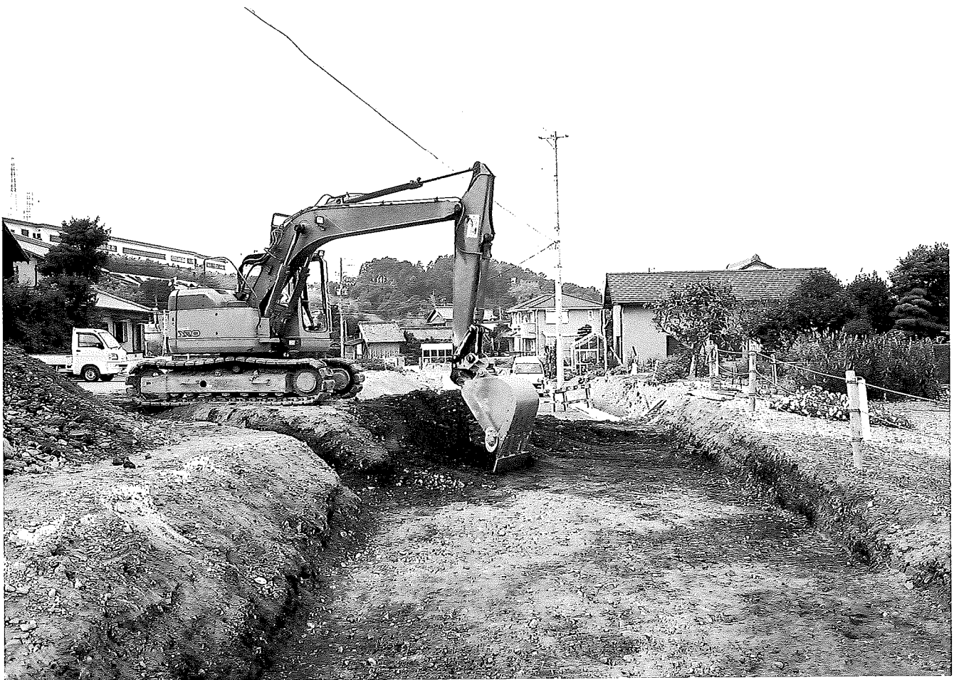
(2) 第8区 重機による表土除去作業
