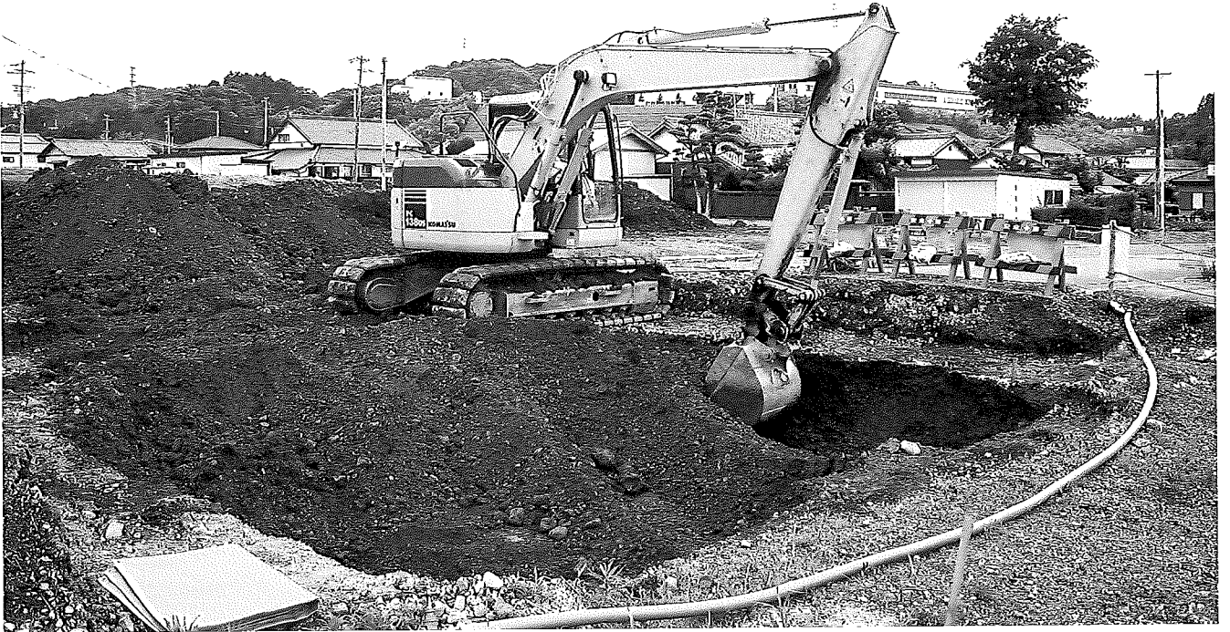
(1) 第10区 重機による表土の除去
