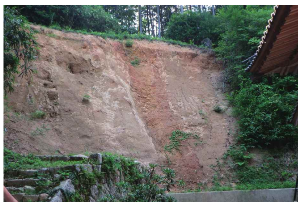
法面崩落状況（東から）
