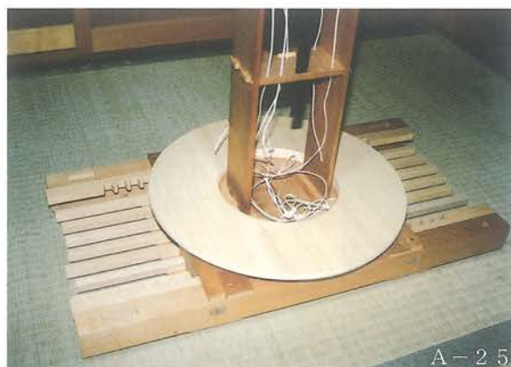
台車部分完成
