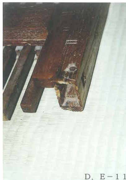
D人形（玉藻之前） 台車連結部 台車枠の木口部の結合部。傷みが著しい。強い力がかかる部分だけに修理が難しい。
