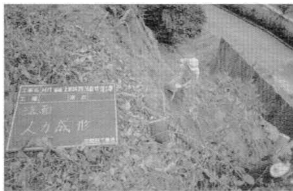
（二の丸南西部）崩落箇所の危険部位除去
