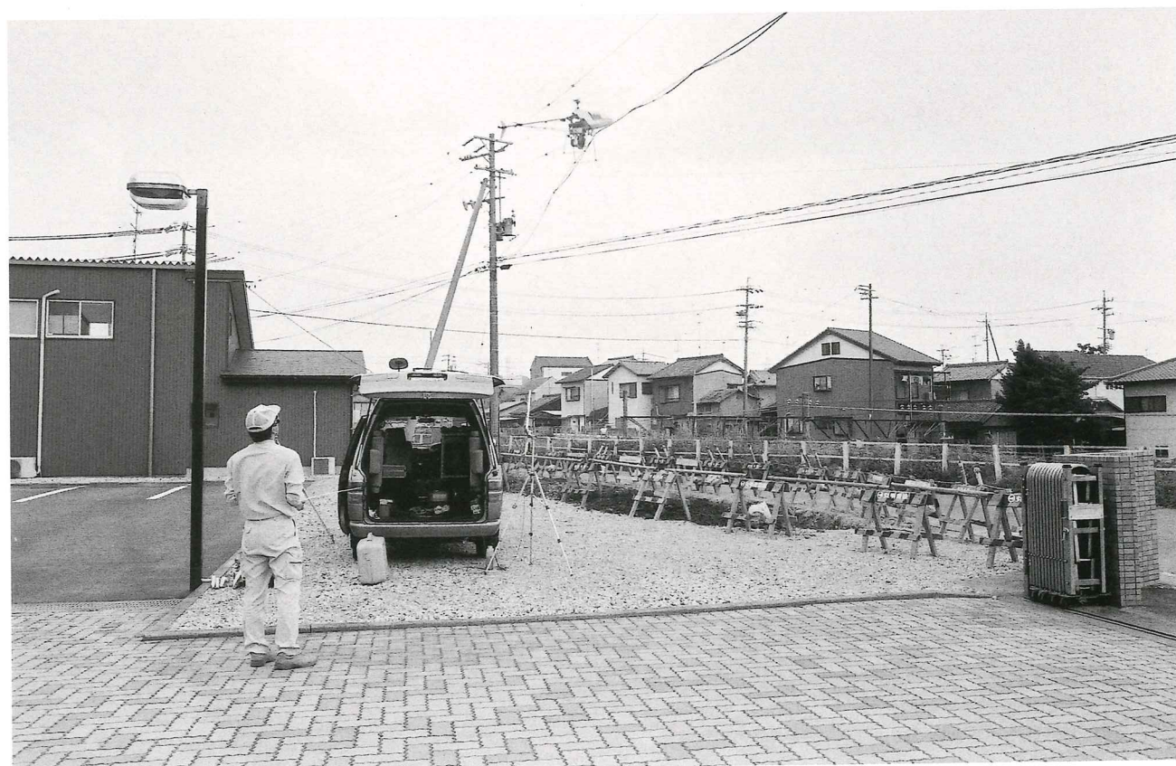
(2) ラジコンヘリによる写真撮影・測量風景
