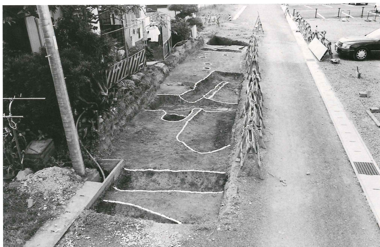
(2) 第32次発掘調査区全景（西より）
