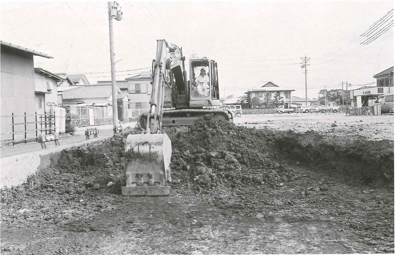
(1) 重機による表土掘削作業風景
