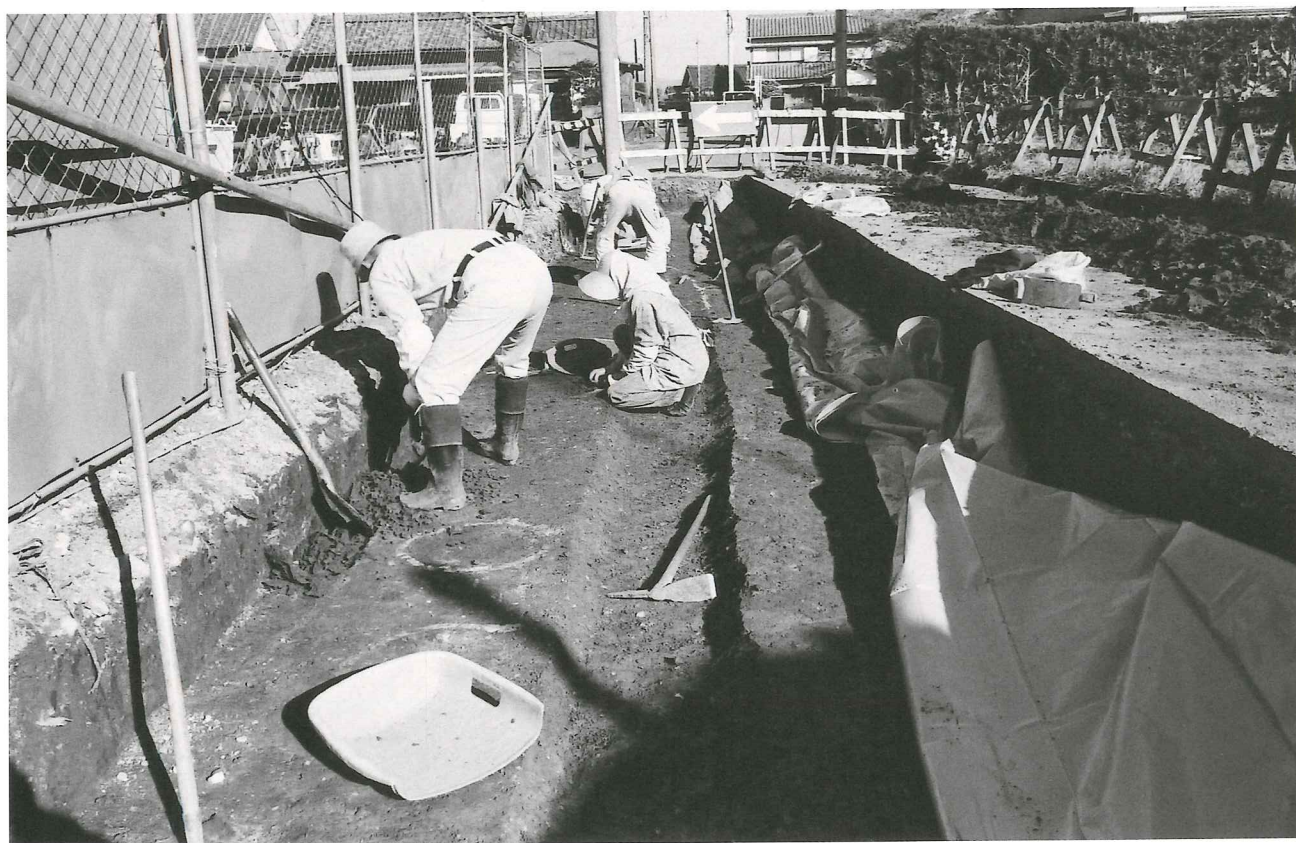
(2) 人力による作業風景
