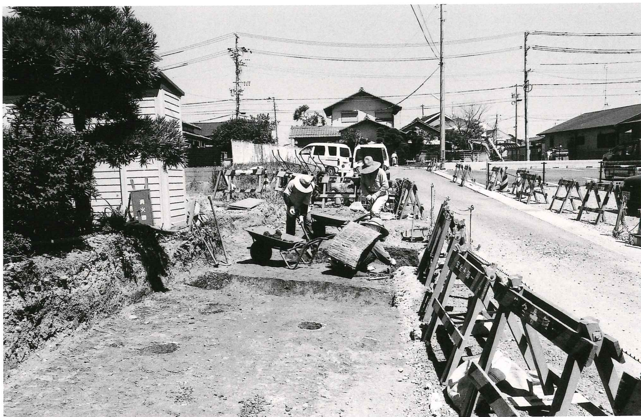
(1) 人力による作業風景
