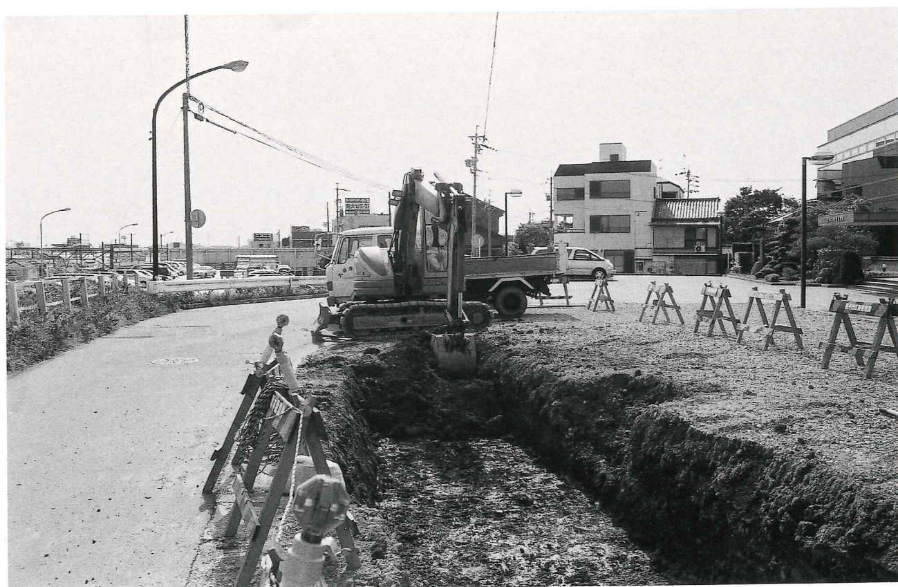
(2) 重機による表土掘削風景
