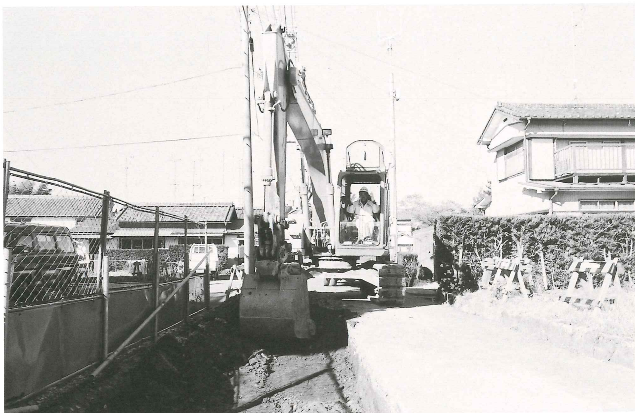
(1) 重機による表土掘削作業風景
