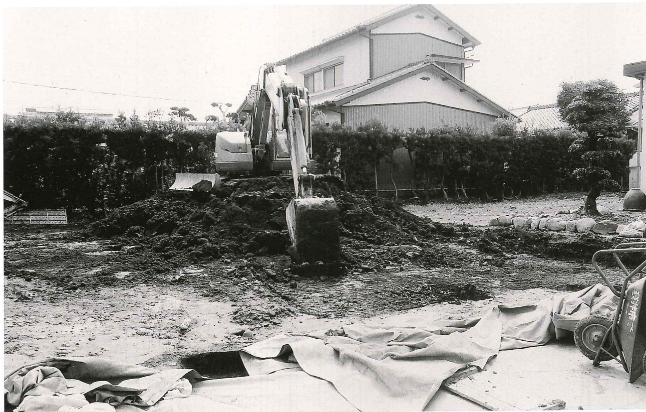
(1) 重機による表土掘削作業風景
