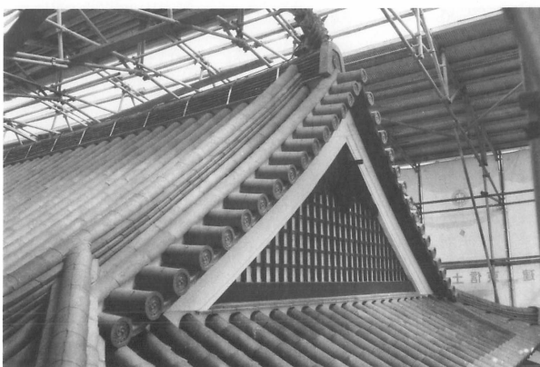
49 施工 二重瓦葺き完了
