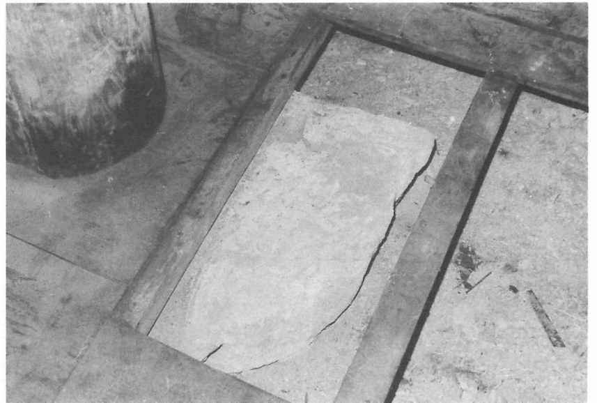
51 真柱礎石 長手3尺ほどで上端は平らに荒仕上げしている
