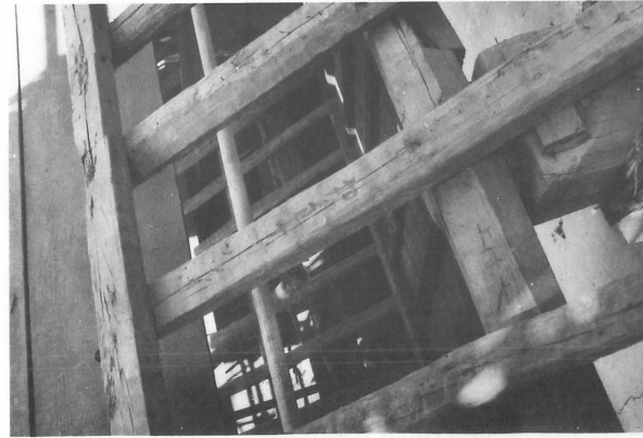
63 施工 出桁・茅負・垂木
