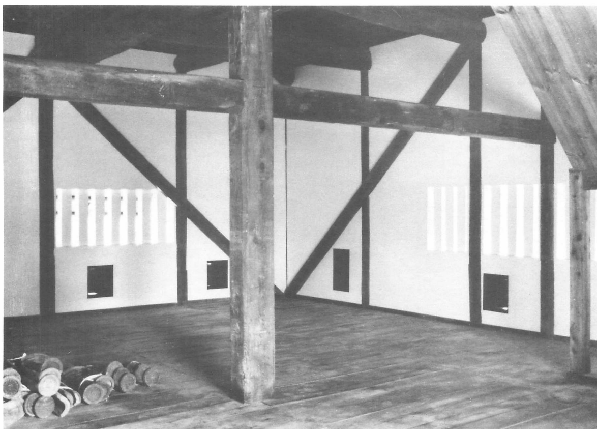
8 竣工 一階内部東北面
