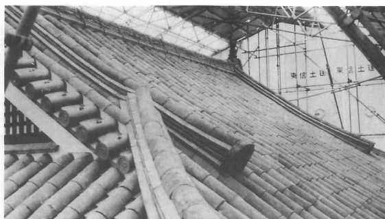
43 施工 二重屋根葺き上げ
