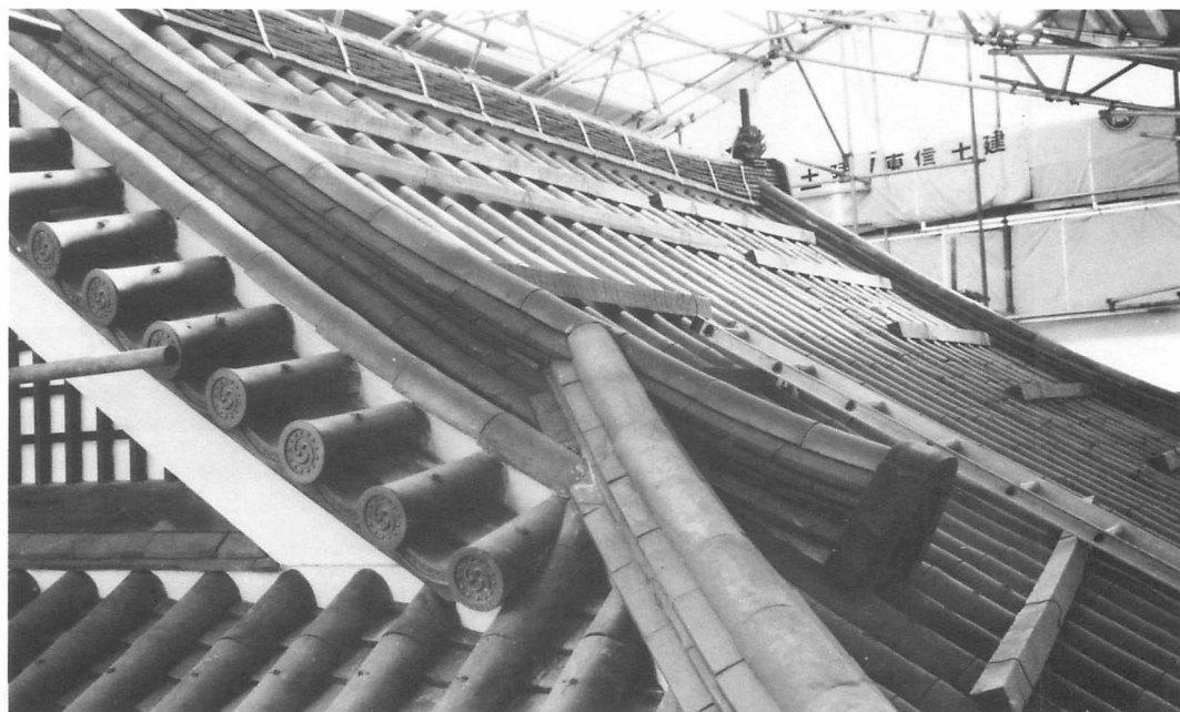
33 施工 二重屋根瓦葺
