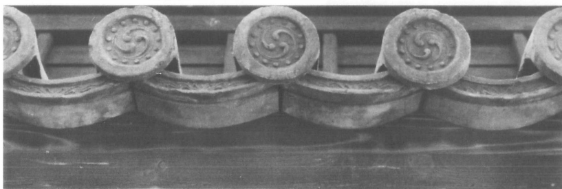
78 竣工 一重軒瓦見上
