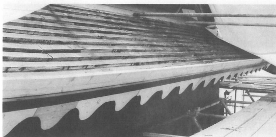
32 施工 二重土居葺き野地
