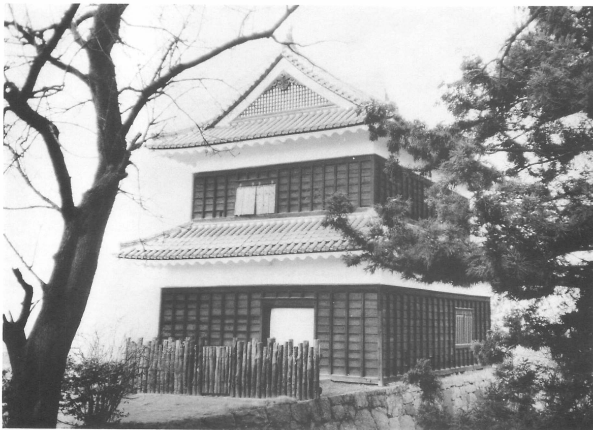
2 竣工 東北面全景
