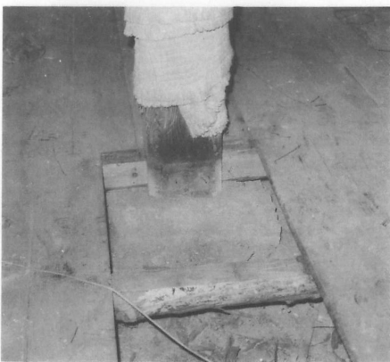
54 施工 一階真柱と礎石
