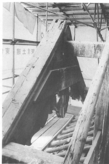
41 施工 二重破風板および布裏甲 内側
