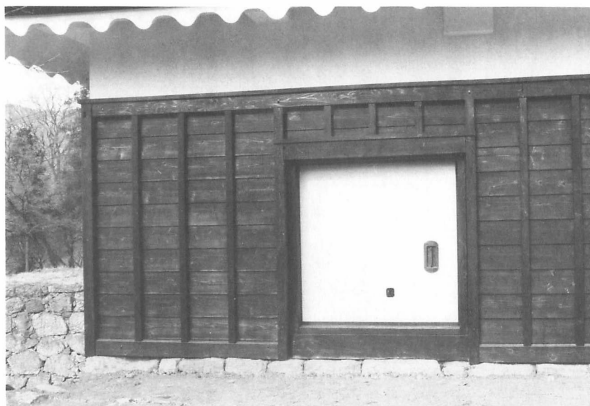
11 竣工 南面出入口外部
