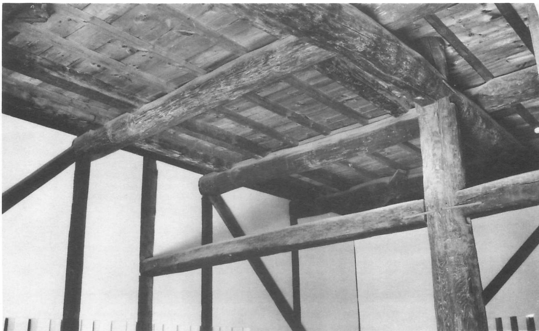
12 竣工 二階床梁および根太見上げ
