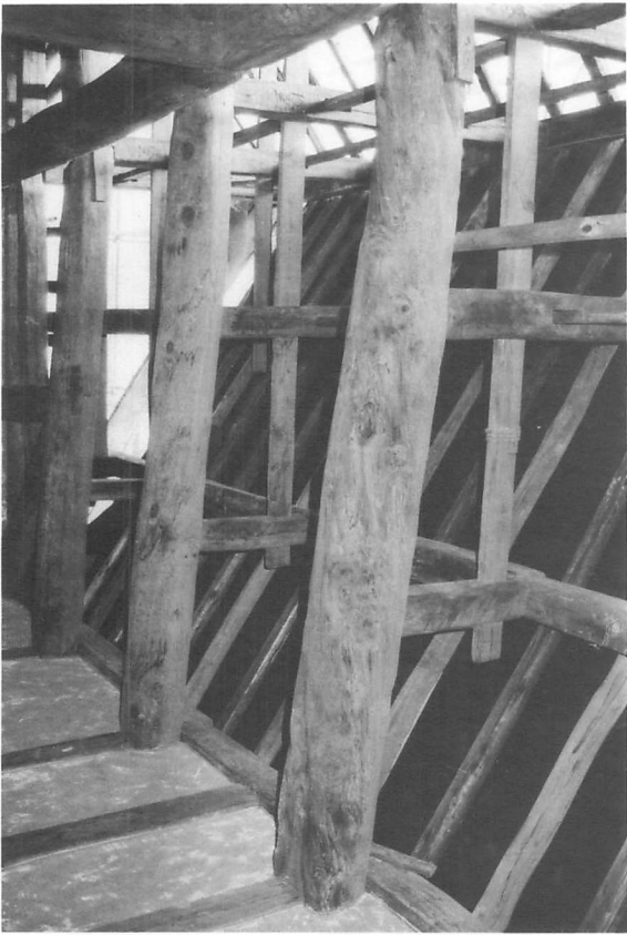
18 施工 二重小屋組軒杵寄見上げ
