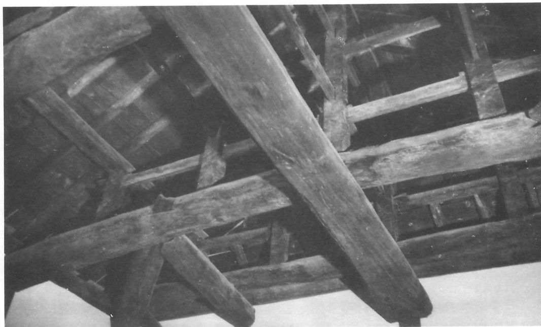
14 竣工 二重小屋組妻部見上げ
