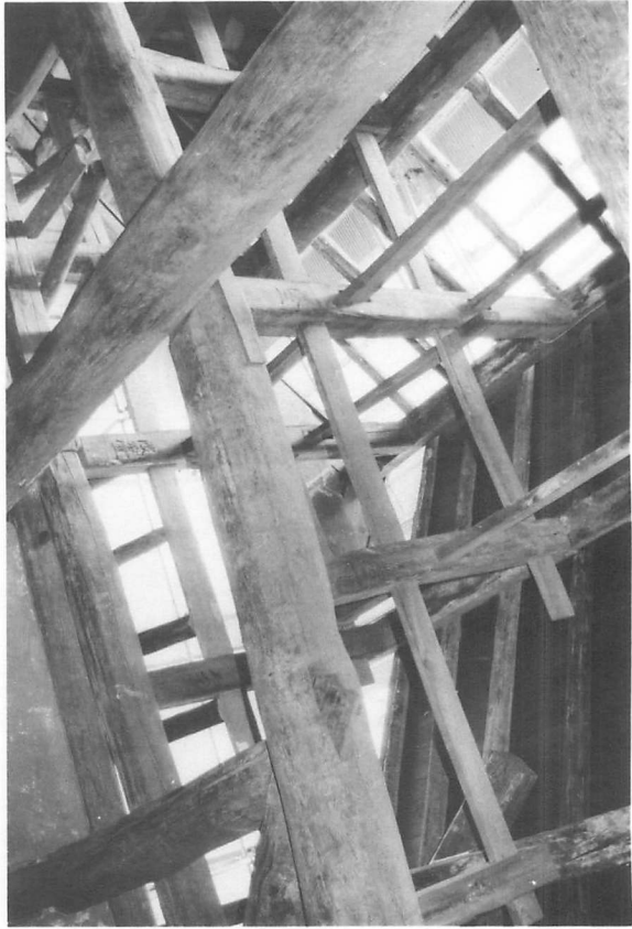
17 施工 二重小屋組中央部見上げ
