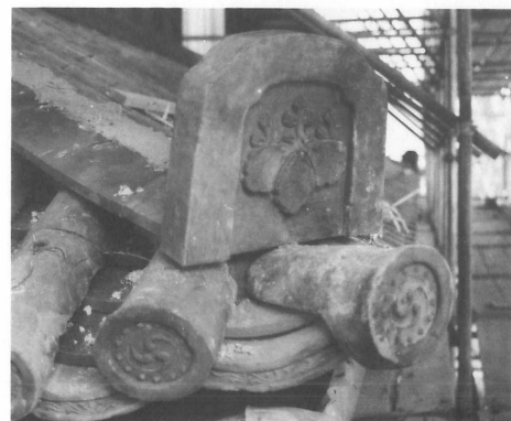
75 施工 隅鬼瓦等据付
