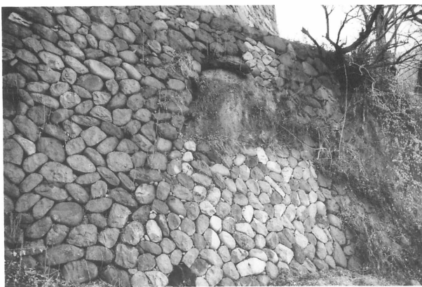
44 資料 南面西端土塁補強石積み
