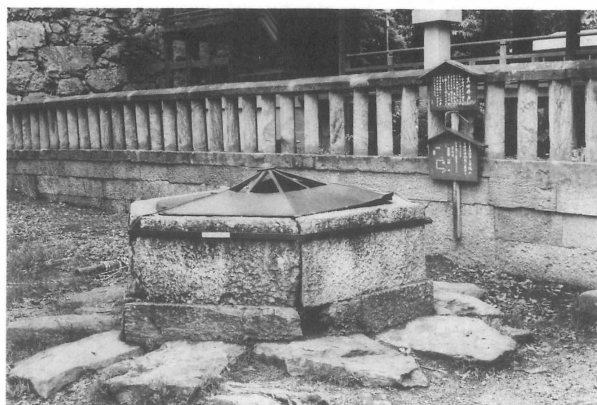
西櫓東方に所在、六角形埴石組、外径1.82メートル、地上高80センチ
