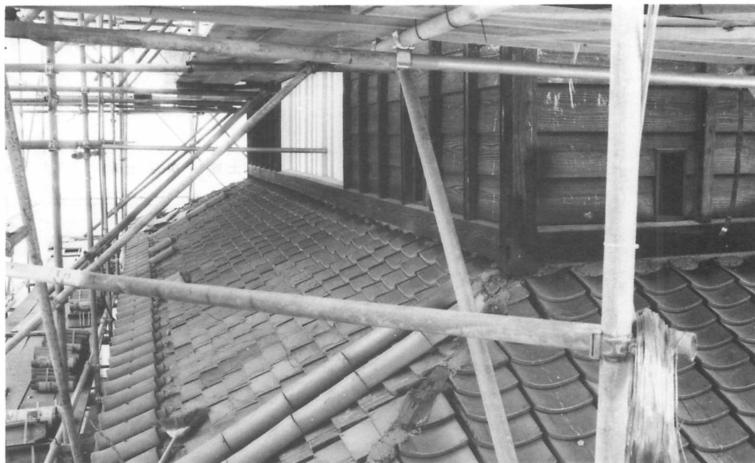
32 施工 一重屋根瓦葺
