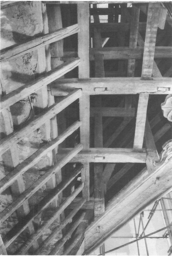
16 施工 二重屋根妻部分
