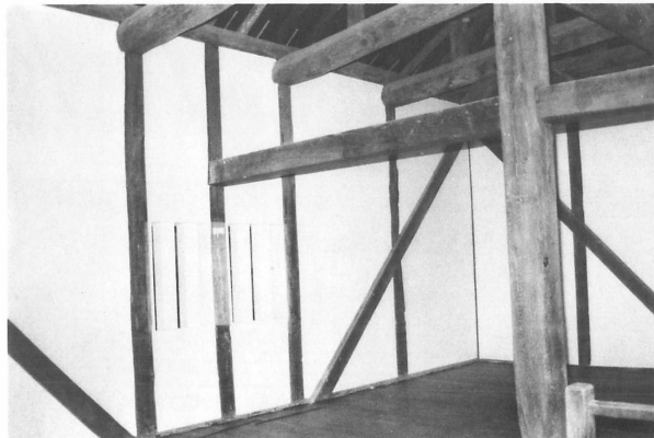
14 竣工 二階内部西北面
