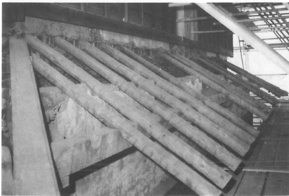
65 施工 一重軒廻り補修
