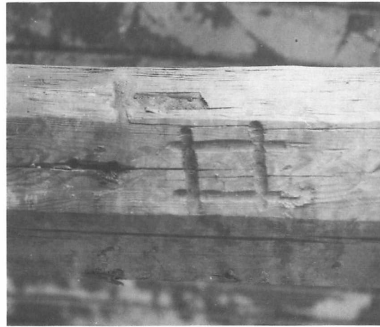
50 出桁上端刻彫番付け 丸ノミを用いて刻している
