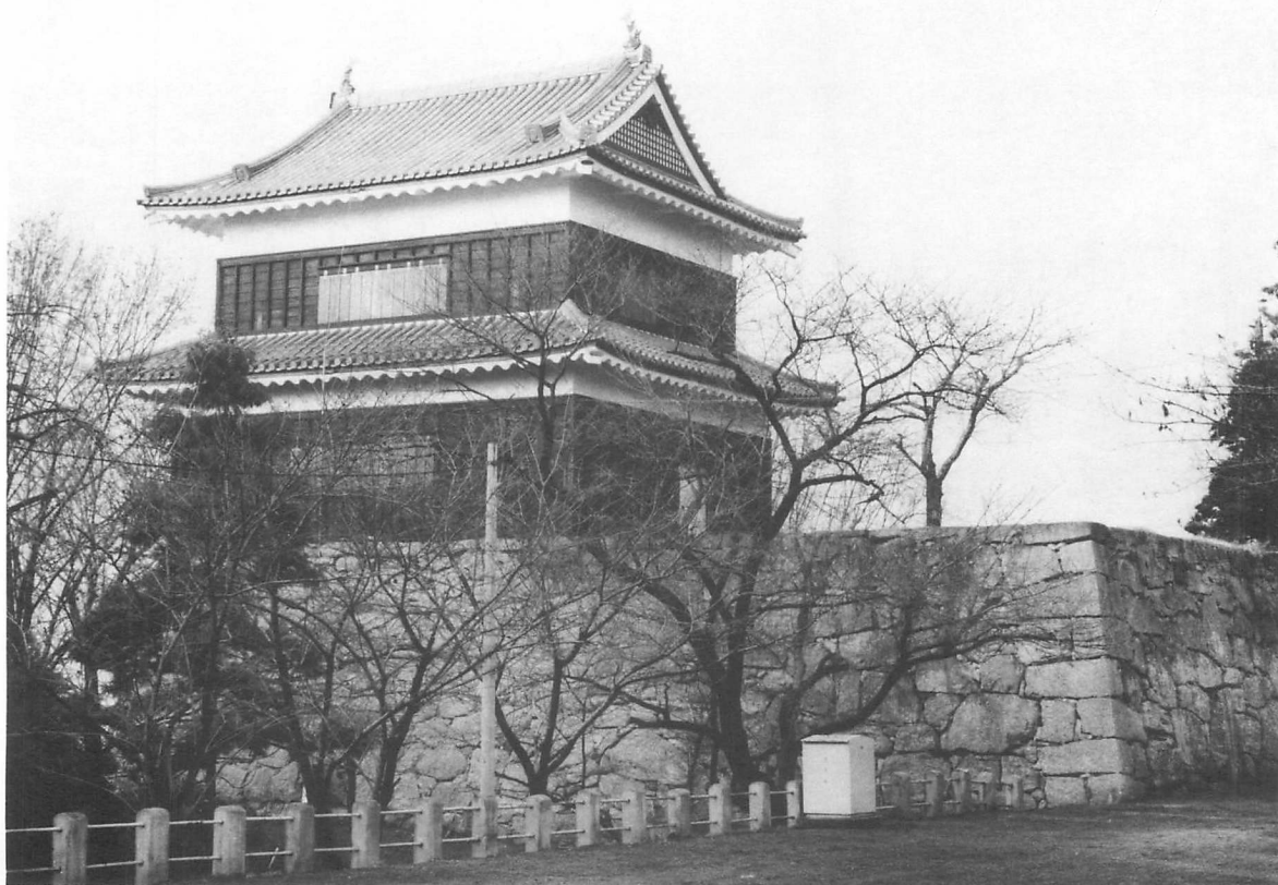
2 竣工 東北面全景
