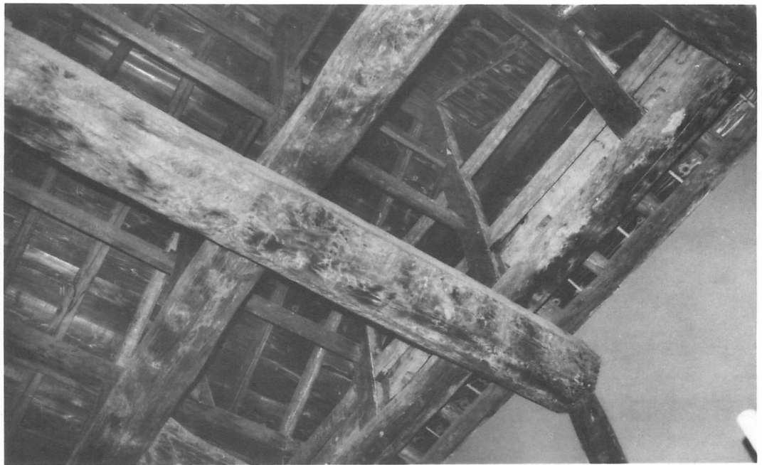
11 竣工 二重屋根裏見上げ
