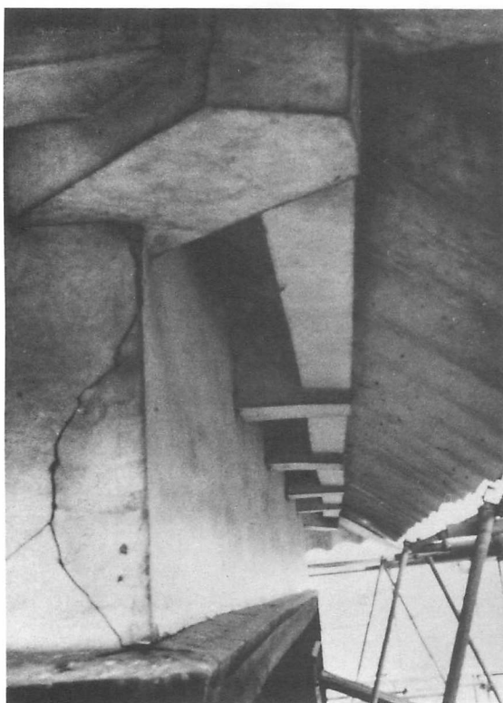
30 修理前 二重軒裏状態
