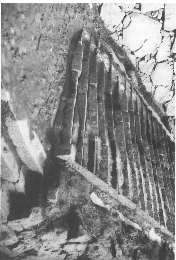
87 修理前 石階段部分詳細
