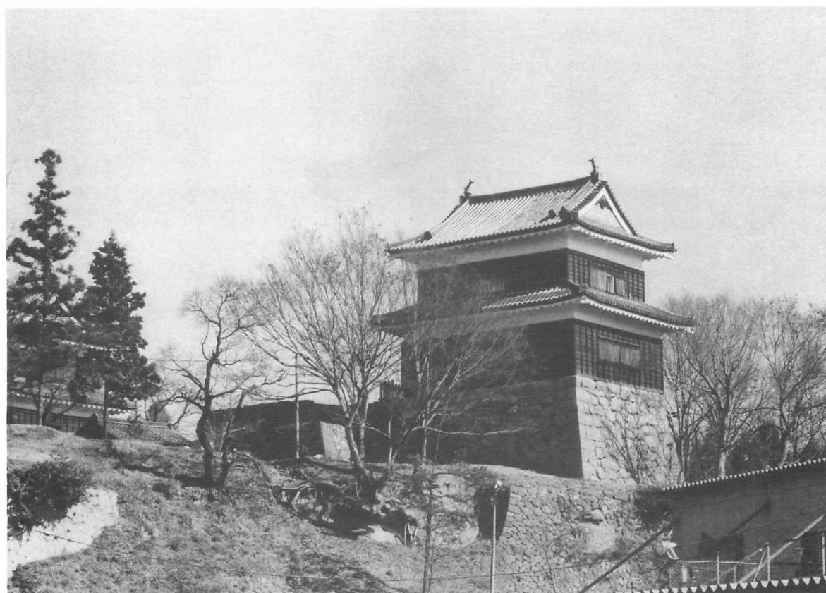
4 竣工 西南面全景
