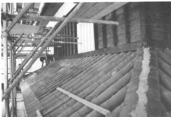
46 施工 一重瓦葺
