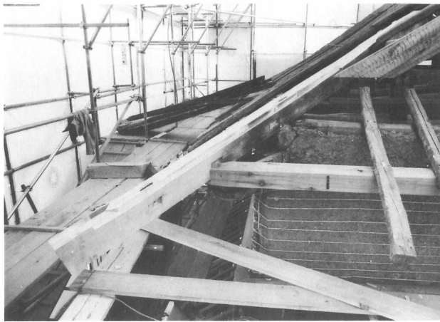
24 施工 二重軒廻り補修
