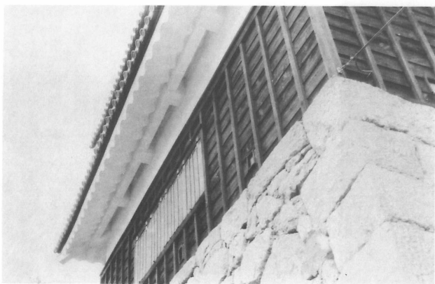
47 竣工 南面軒見上げ
