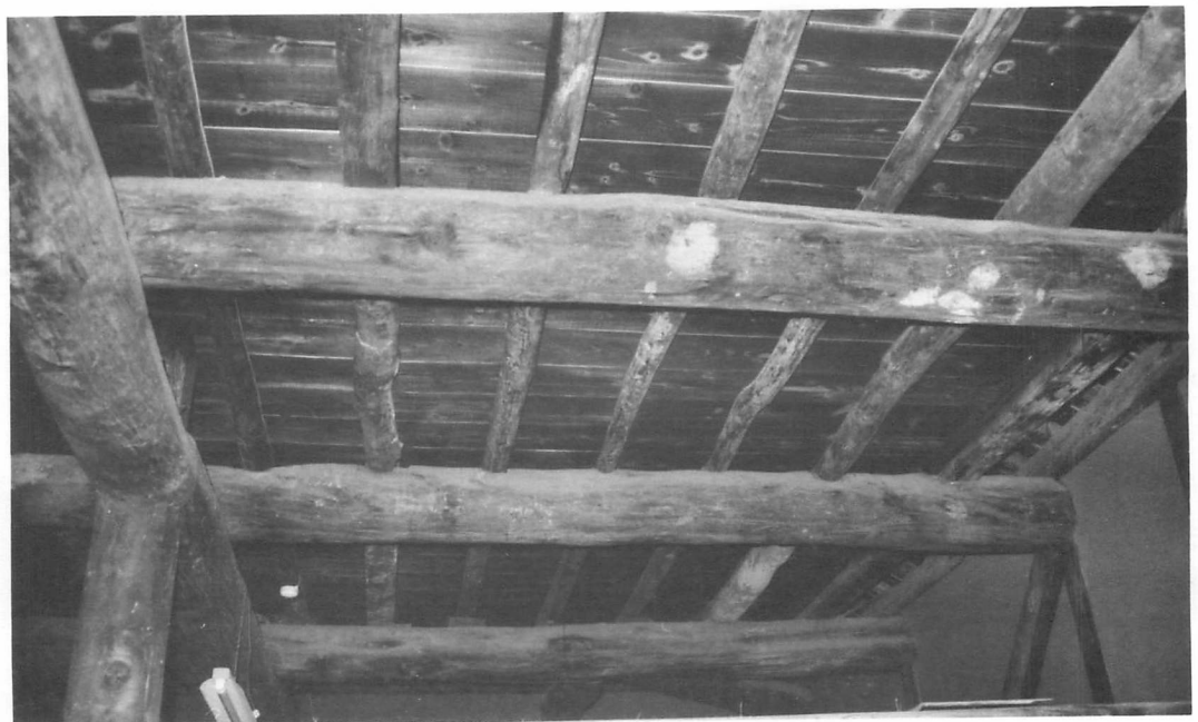
13 竣工 二階床梁および根太見上げ
