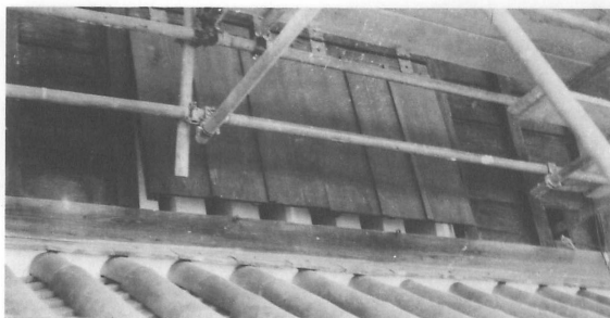
44 施工 二階窓廻り
