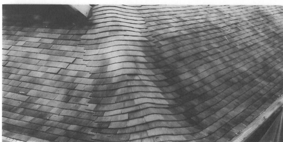
33 施工 二重土居葺
