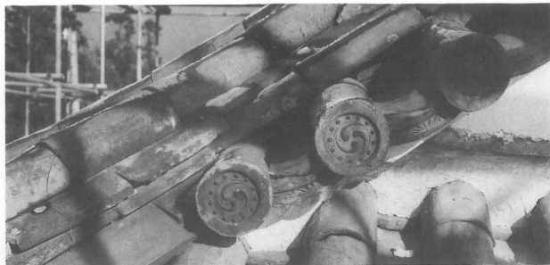
66 修理前 箕甲瓦葺き 現状
