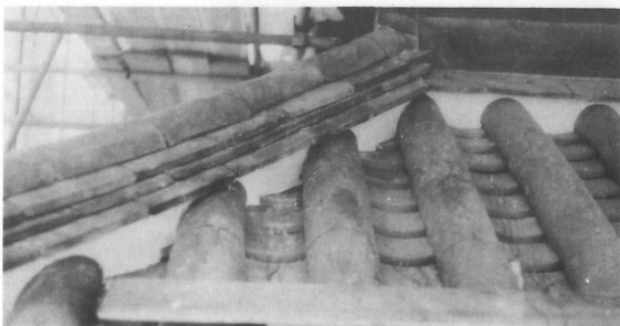
45 施工 二重屋根隅部分
