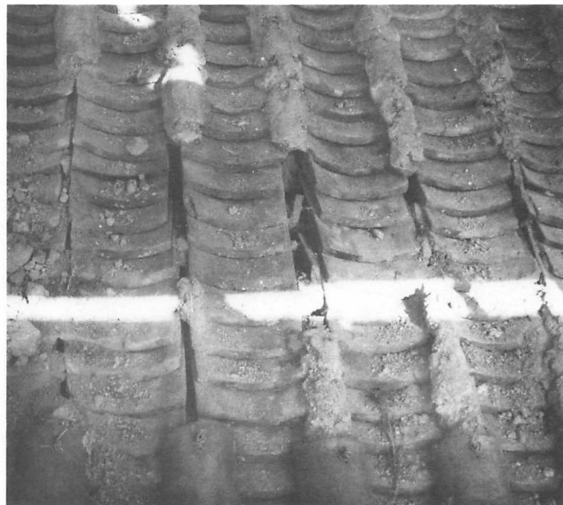
26 解放 屋根平葺き状態
