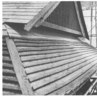
41 施工 二重軒上端土居葺き下地棧
