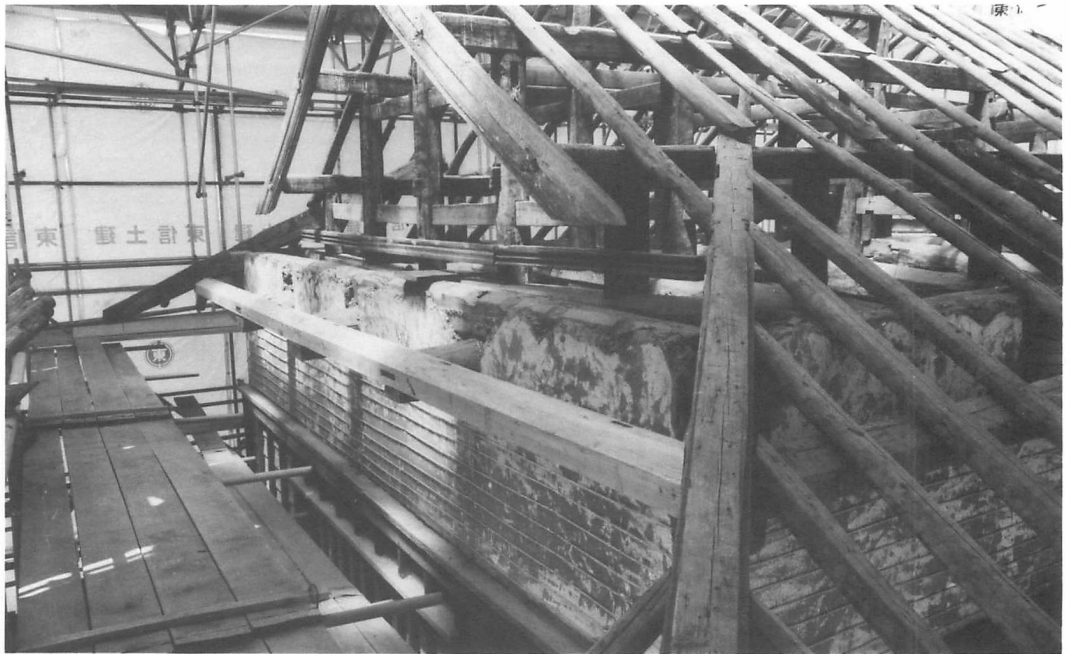
18 施工 二重軒廻り補修
