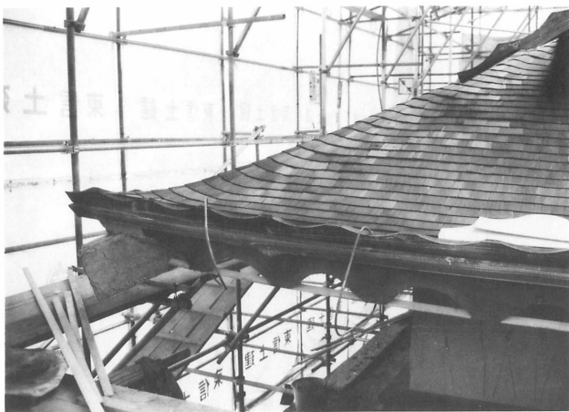
26 施工 二重瓦座と土居葺
