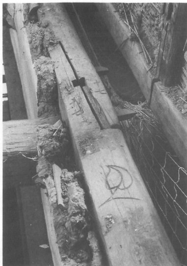
58 解放 二重軒桁継手および合番付
