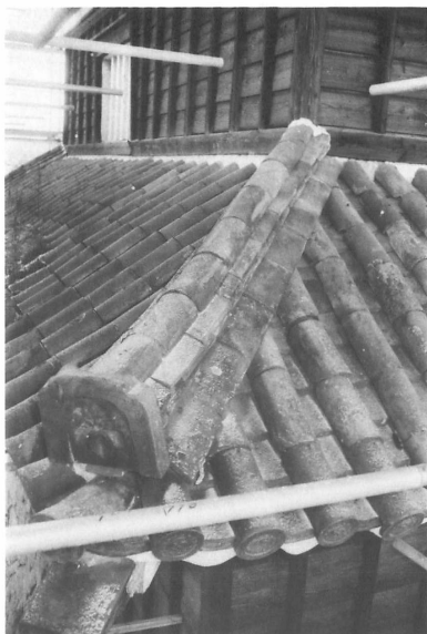
77 修理前 一重屋根隅部現状
