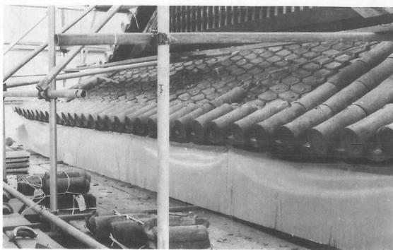
44 施工 二重瓦葺き 妻部分
