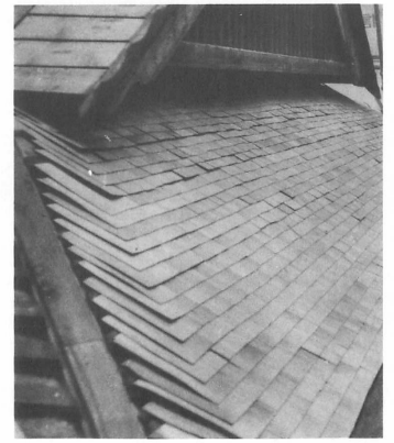
42 施工 土居葺き
