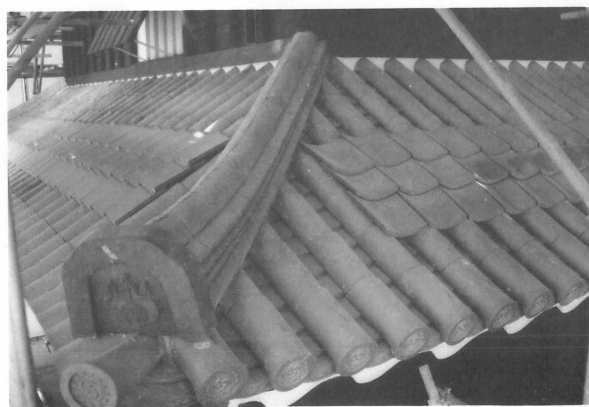
47 施工 一重隅棟および捨瓦
