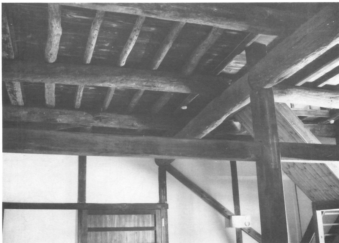
8 竣工 一階内部北面・二階床見上げ
