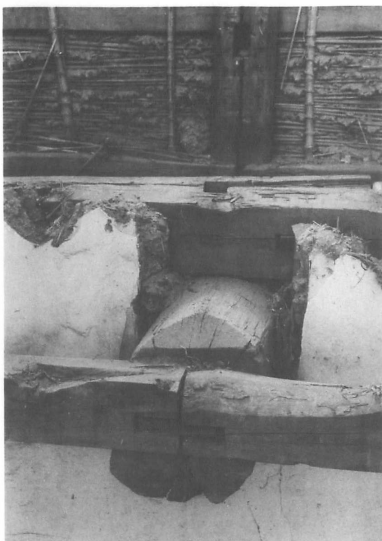
59 解体 一重軒桁および出桁
