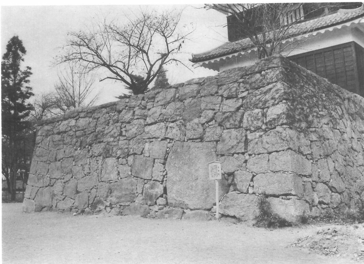
5 竣工 南面石垣 旧多聞櫓跡
