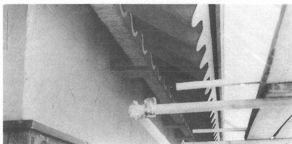
36 施工 軒裏および大かべ中塗
