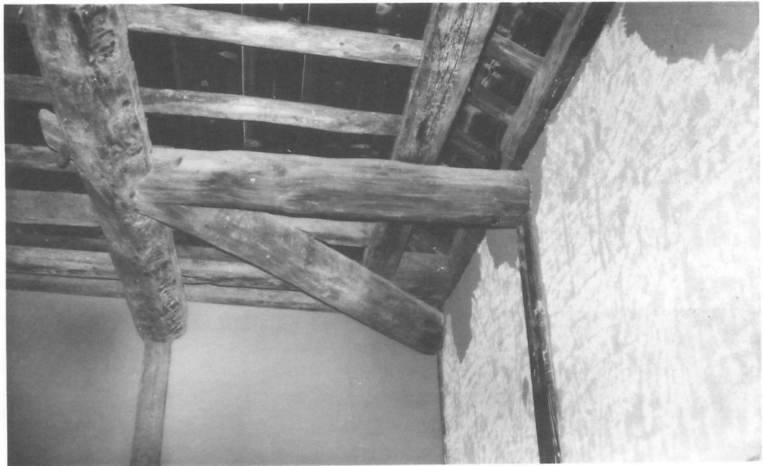
12 竣工 二階床梁組隅部見上げ
