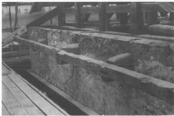
60 施工 二重軒廻り補修
