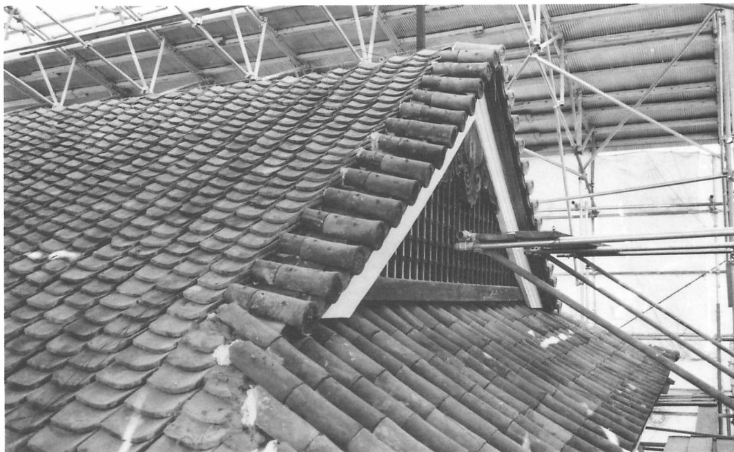
31 施工 二重屋根瓦葺
