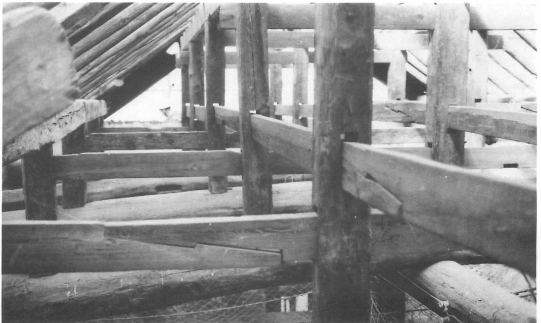
19 施工 二重小屋束および貫現状
