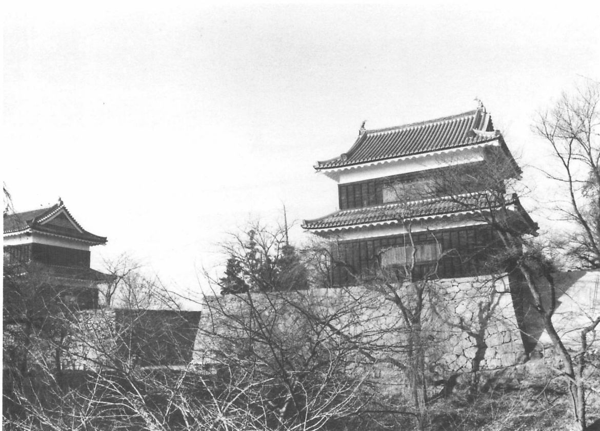
4 竣工 東北面全景
