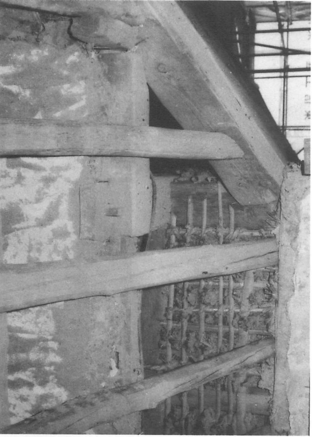
21 施工 二階柱踏桁の初重軒桁への仕口
