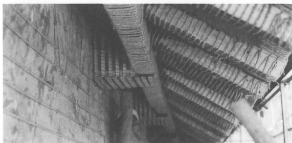
35 施工 軒裏かべ下地
