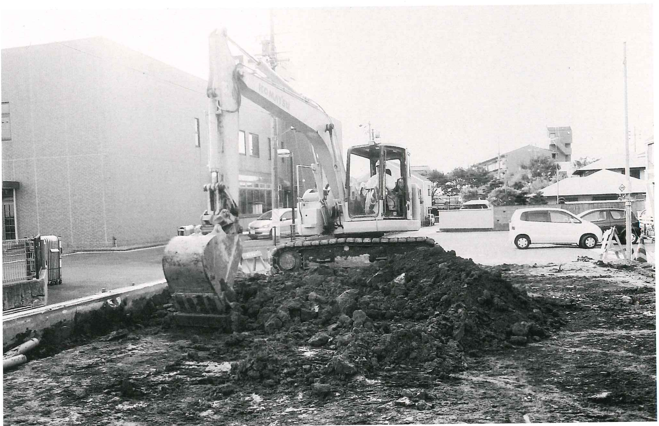
(2) 重機による表土掘削風景
