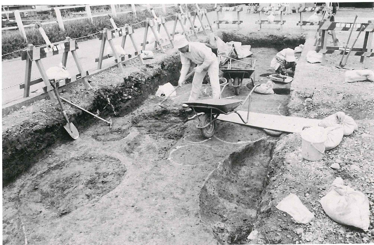
(1) 調査風景（中央区西の土坑群の人力による調査風景。東より）
