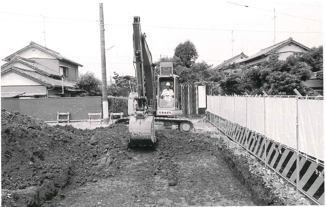
(2) 重機による表土掘削作業風景
