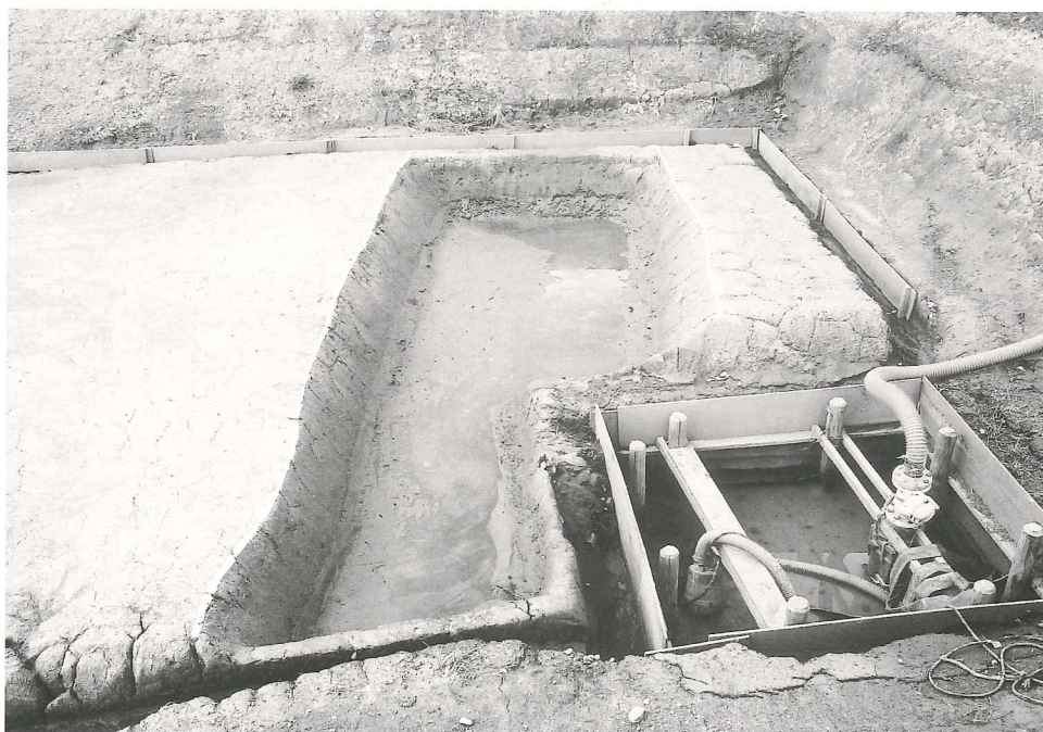
(2) SD1の北側 完了写真 (南より)
