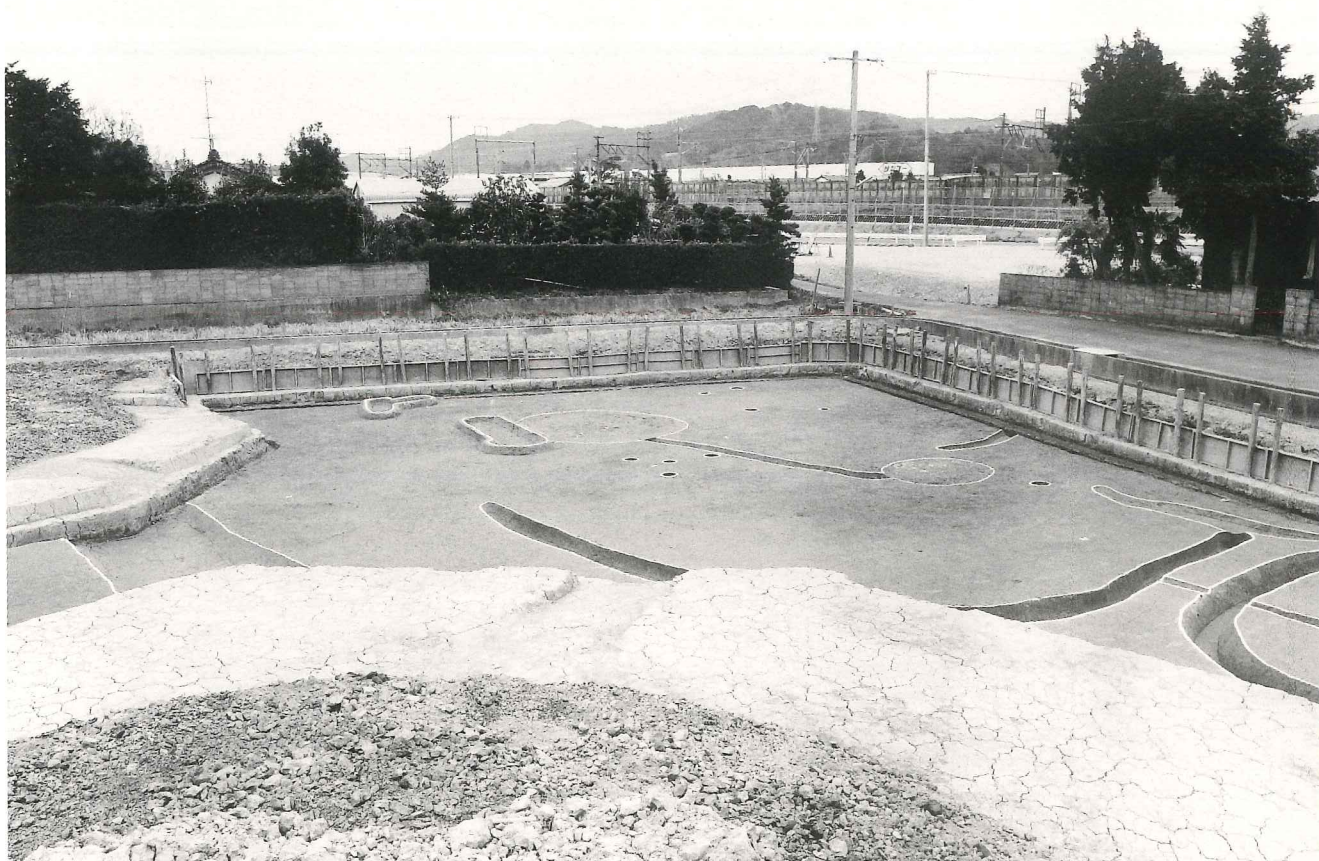
(1) 南地区東側完了写真 (北西より)
