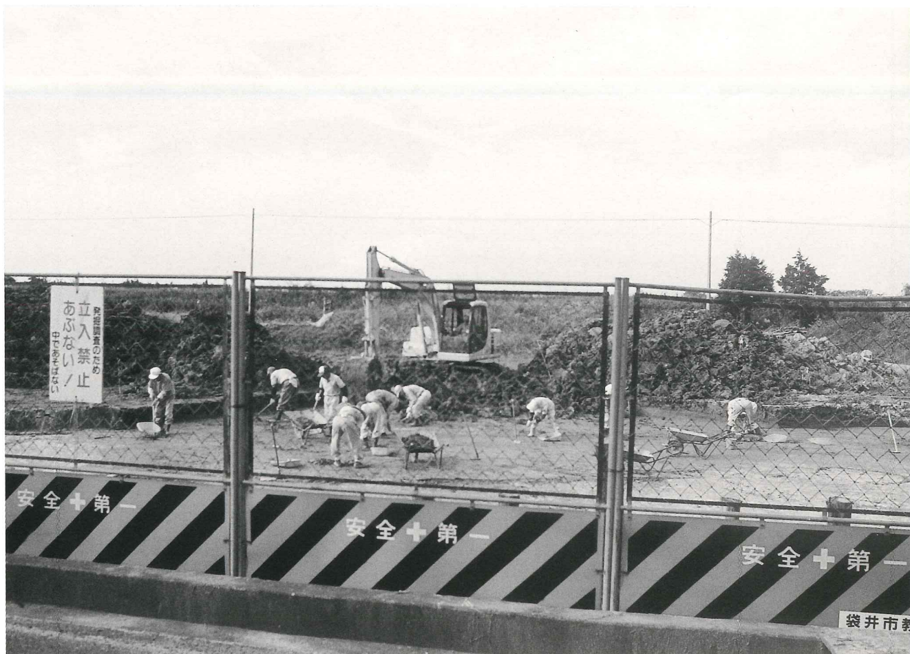
(1) 重機による表土除去作業
