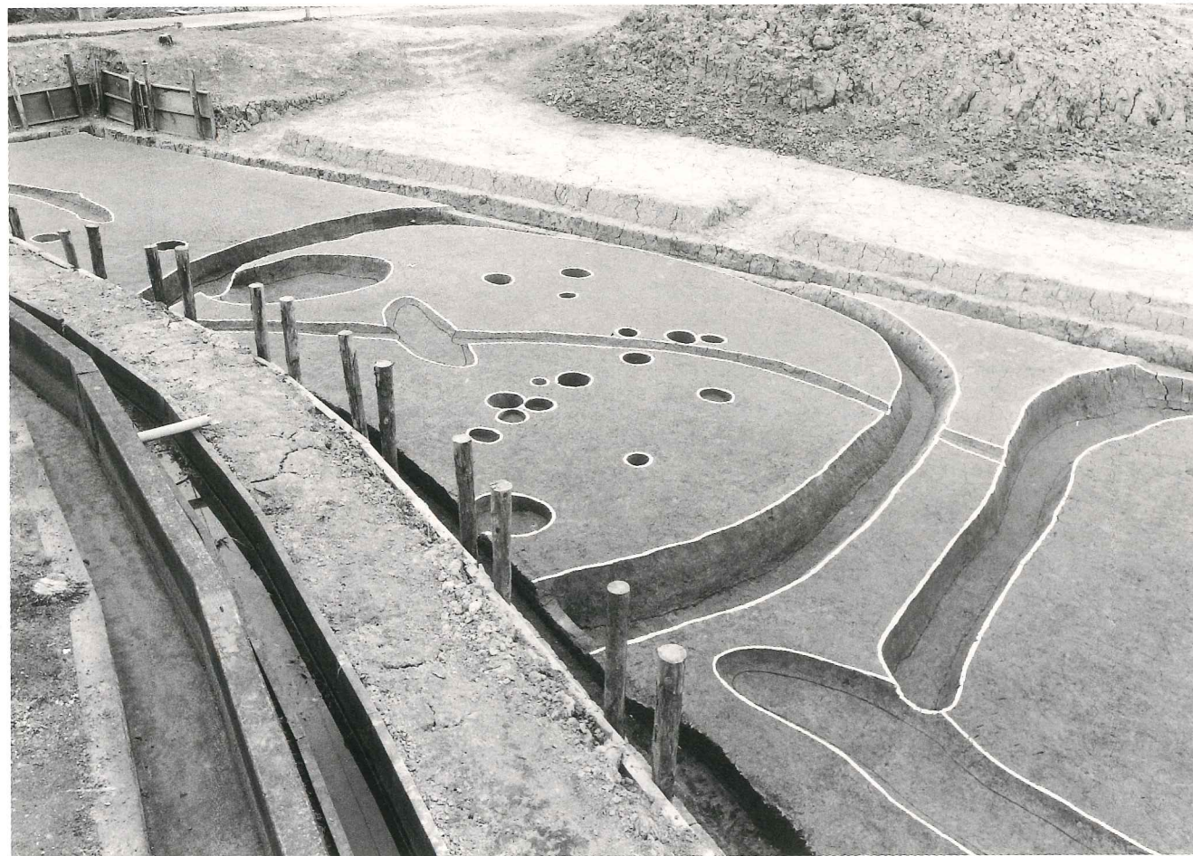
(2) 全景(南東より)
