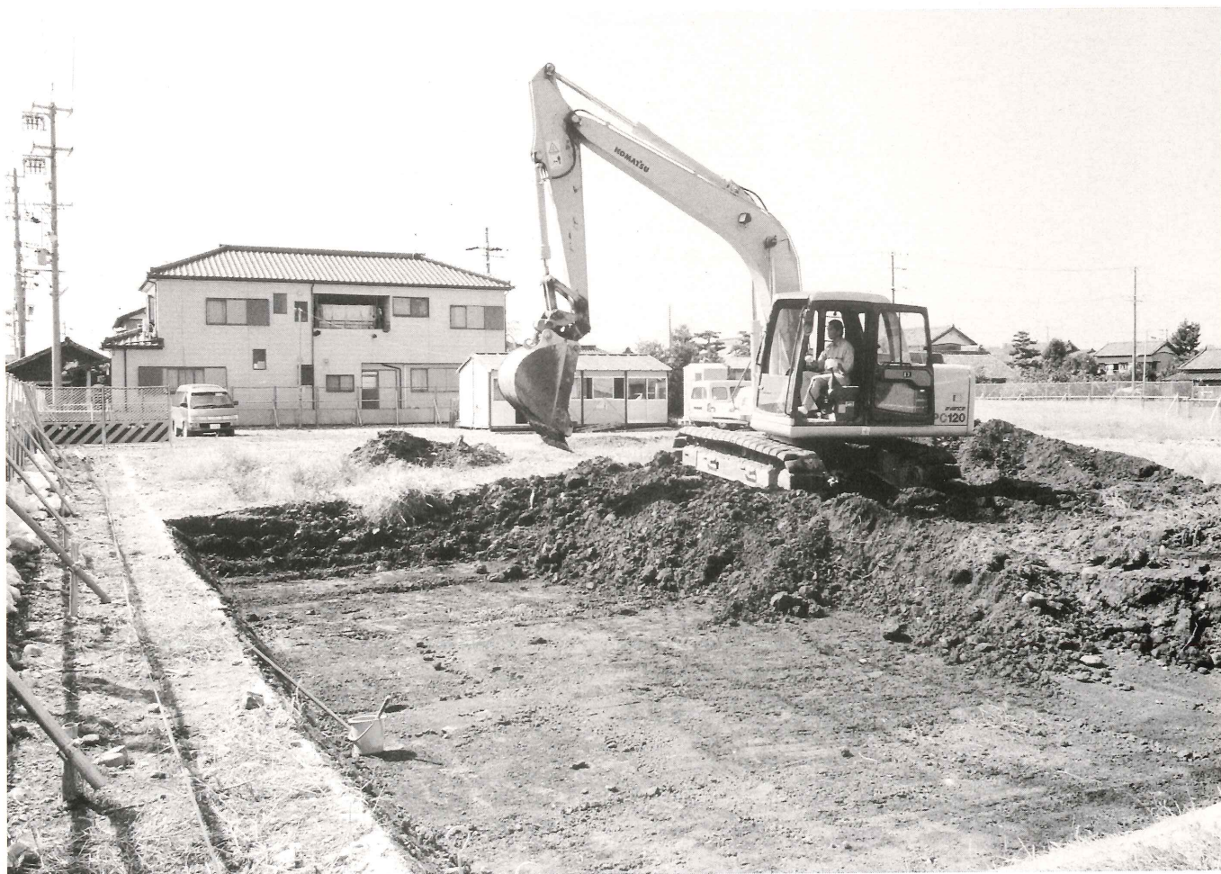
(2) 発掘調査の開始（表土除去作業）
