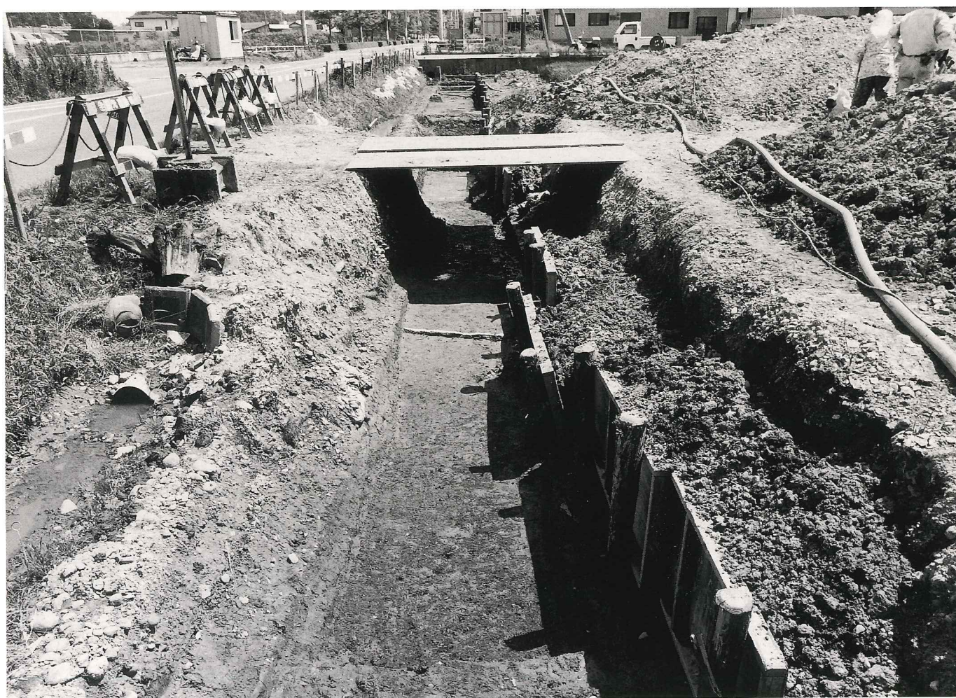
(2) 第2トレンチ (北側) 完了写真
