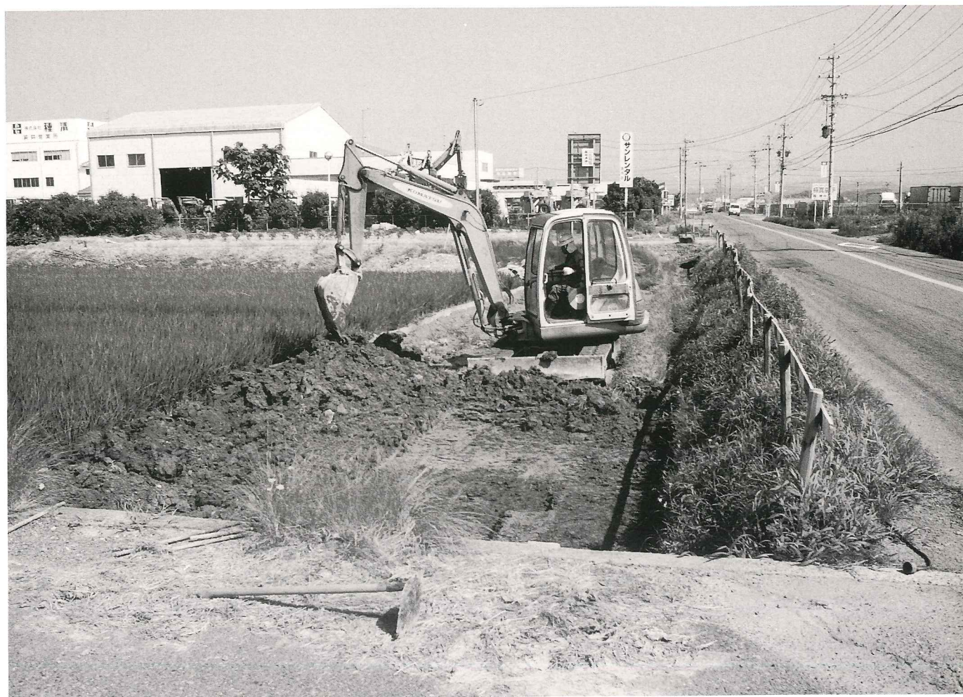
(2) 発掘調査開始時（重機による表土除去）
