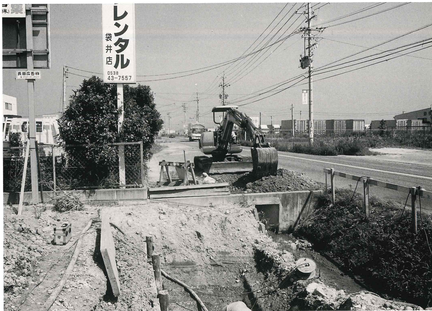
(1) 第3トレンチ発掘状況
