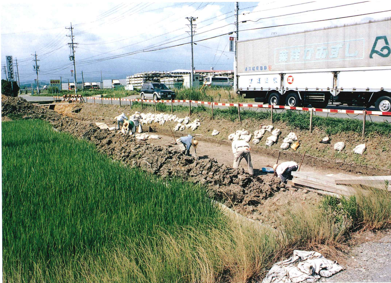
(1) 交通量の多い道路脇の現場
