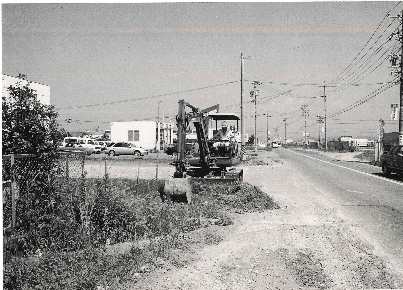
(1) 第5トレンチの掘削状況
