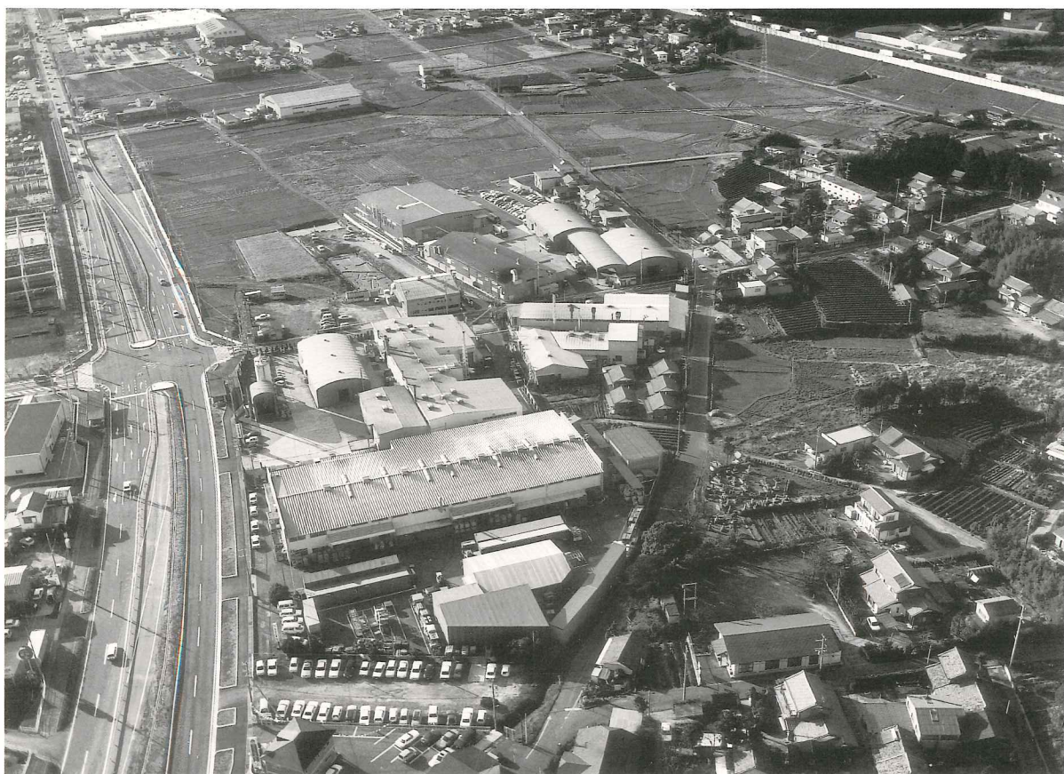
(1) 調査地全景（東より）
