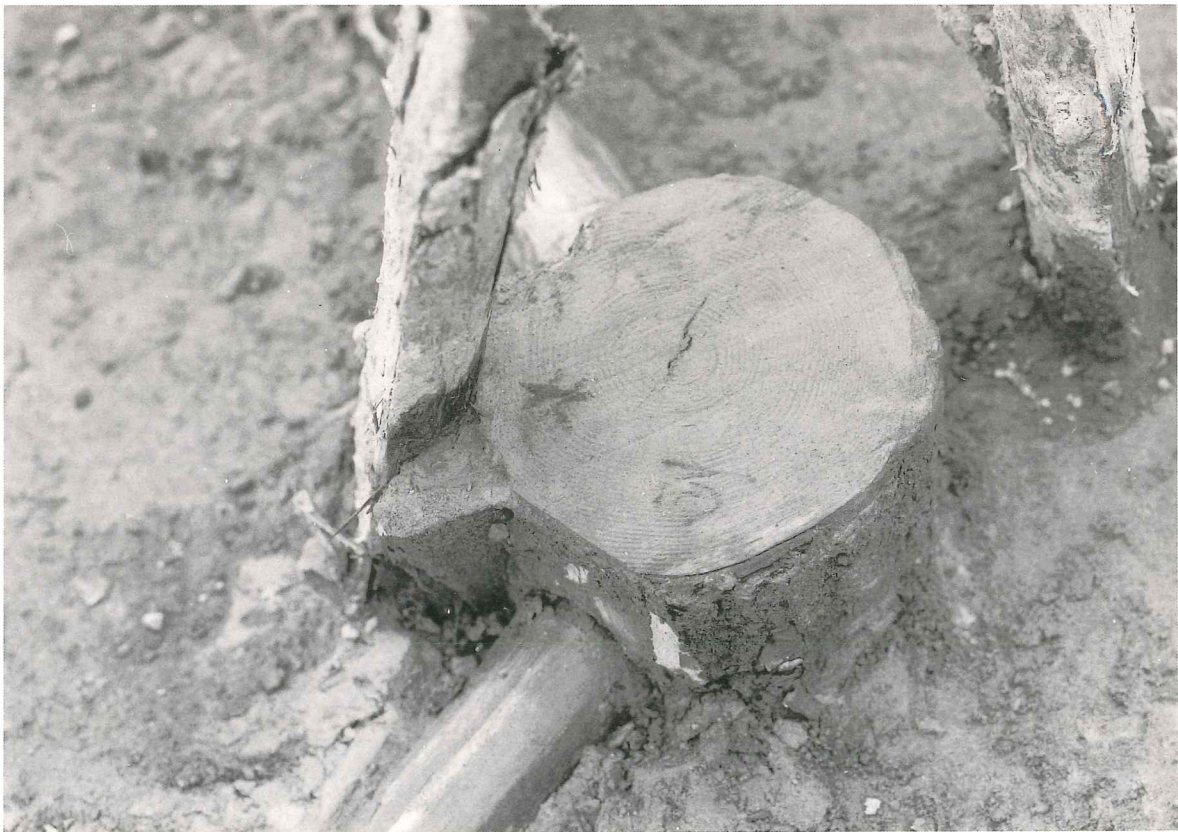
流路内竹樋管ジョイント部
