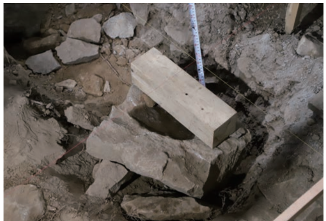
南東礎石据え直し状況（南西から）
