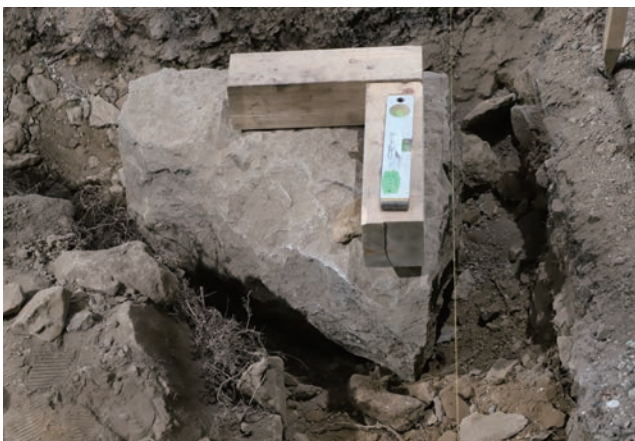
北東礎石据え直し状況（南から）
