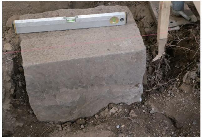
北西礎石据え直し状況（北から）
