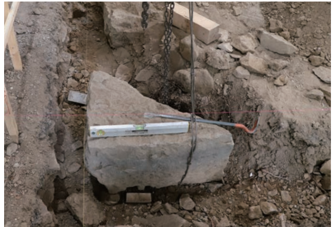
北東礎石据え直し状況（北から）
