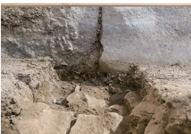
布橋北側石積み底部確認状況（北から）
