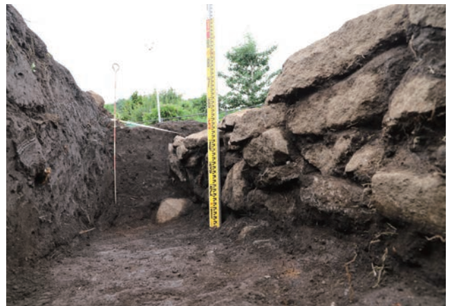
T 2 石積み検出状況・スタッフあり（南から）
