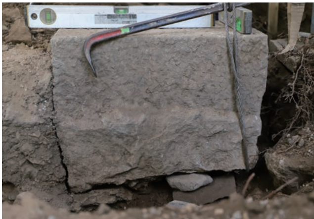
北西礎石据え直し状況（北から）
