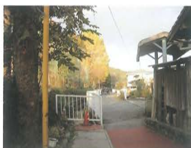
写真3-22 中井手：小学校前の谷川放水門
