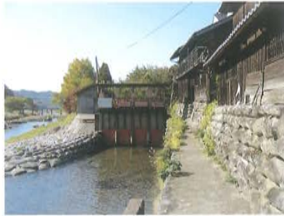
写真3-24 黒木廻水路：取水口
