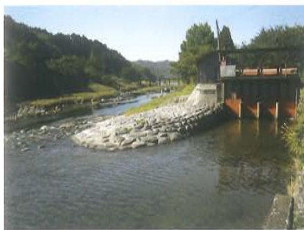
↑ 玉石護岸の黒木廻水路の取水口
