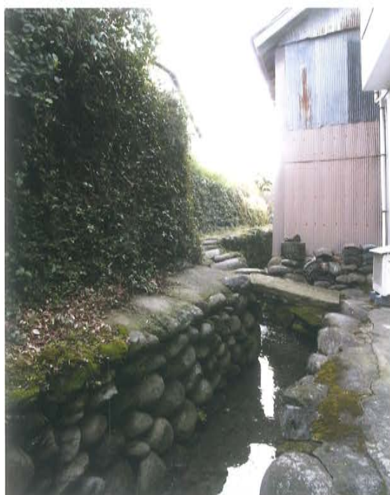
↑ 中町北側中井手沿いの玉石積
