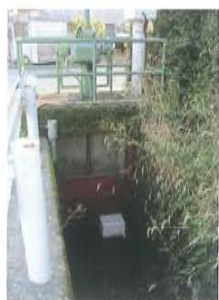
写真3-20 専勝寺横水門
