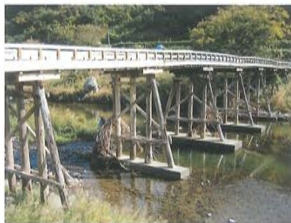
写真3-73 木造の南仙橋
