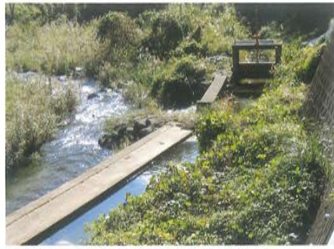
写真3-8 上井手: 取水口近傍と水門
