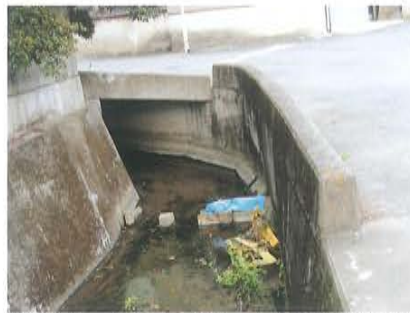
写真3-55 三面コンクリート化された旧谷川
