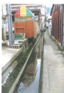
写真3-46 下町の縦支水路
