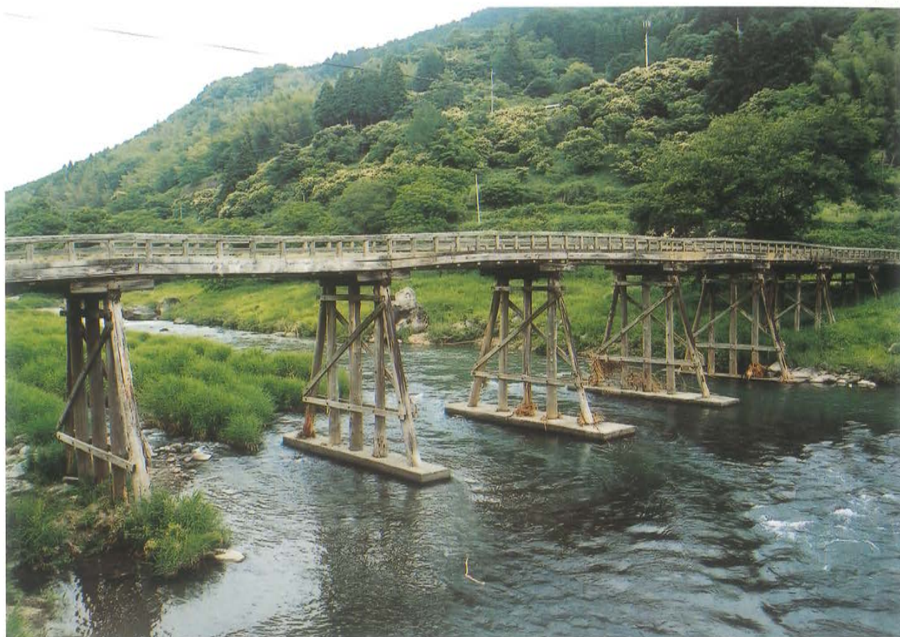
黒木町指定有形文化財 南仙橋 | 昭和29年3月架橋 一級河川・矢部川 木製橋梁、橋長63.0m、橋幅3.568m、橋脚7基（連続桁橋）
