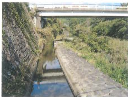
写真3-37 中井手：石積の堤防
