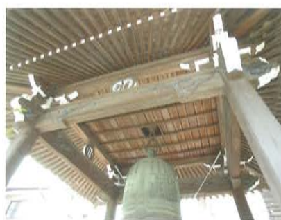
↑覺法寺鐘樓見上げ
