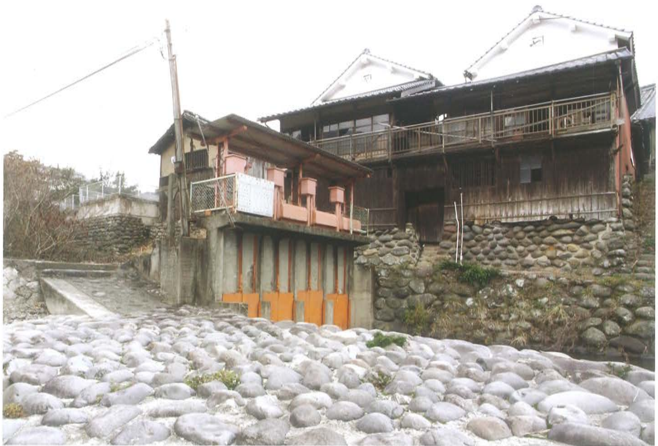
東上町の屋敷尻〔南側・黒木廻水路〕（手前）、中山岩男家倉庫（奥）
