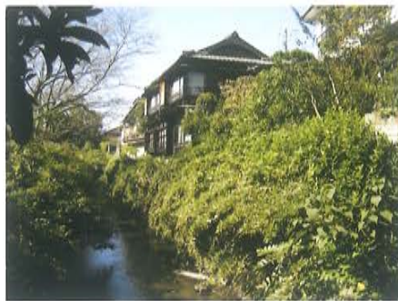
↑ 樹木が石垣を覆った黒木廻水路
