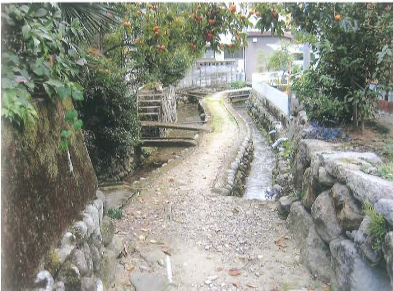
写真3-52 上井手支水路（左）と谷川支水路（右）が合流する中町と栄町の境界
