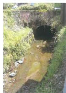
写真3-63 廻水路末端のトンネル出口
