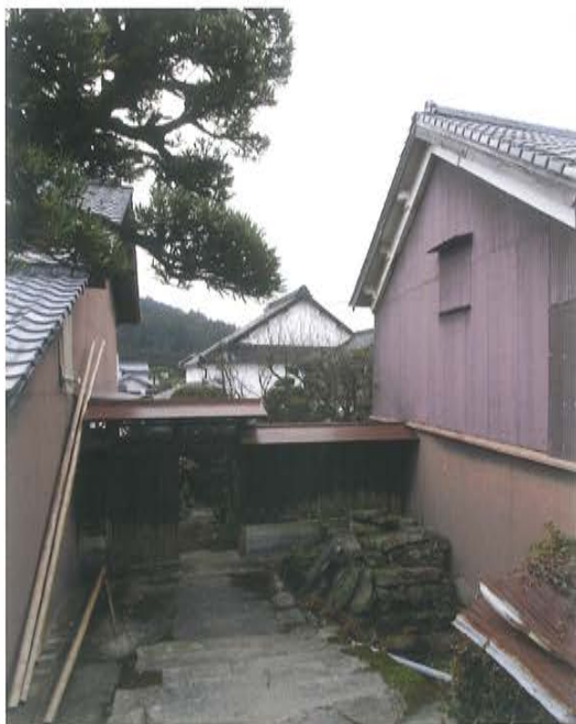
↑ 中町北側中井手沿いの景観：川島家
