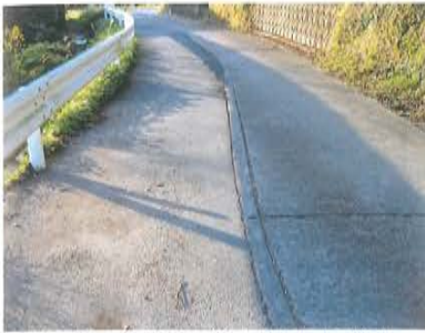
写真3-10 上井手: 築山公園下の暗渠
