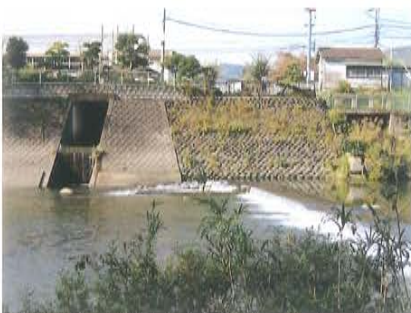
写真3-75 対岸から旧役場南の吐水口を望む
