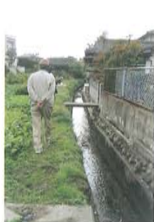
写真3-47 下町南側支水路
