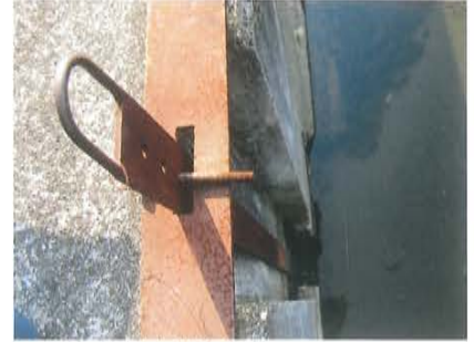
写真3-28 助水路取入口
