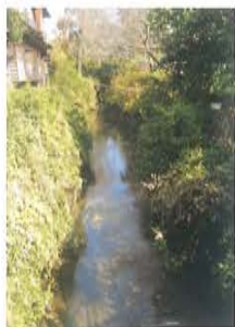
写真3-60 廻水路：取水口付近
