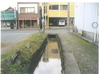
写真3-45 中町と栄町境の縦支水路
