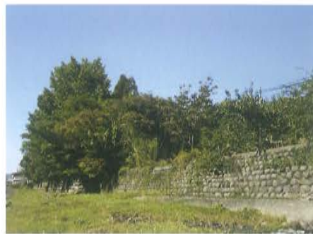
↑ 矢部川と黒木廻水路に挟まれた堤防
