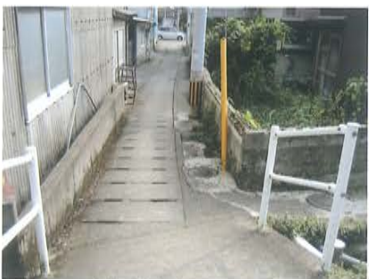
写真3-44 中井手支水路：西上町と中町境の暗渠
