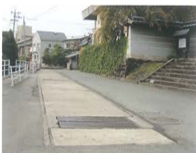
写真3-21 中井手：専勝寺前の暗渠
