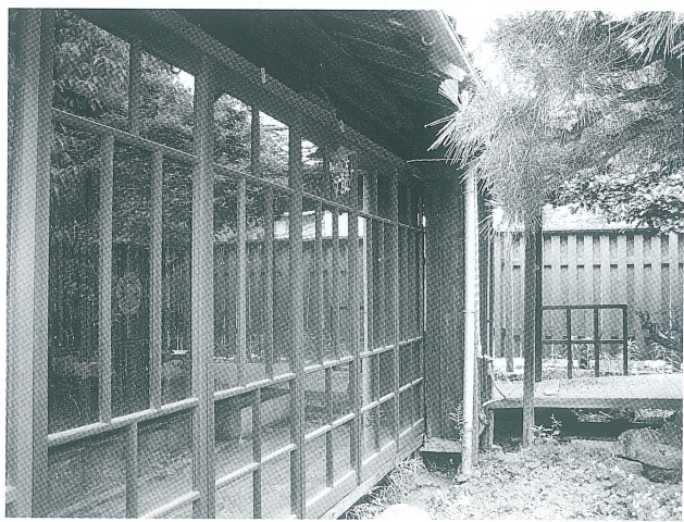
写真5 主屋北面縁側ガラス戸
