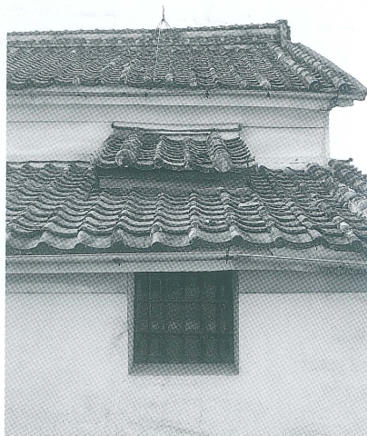
写真6 主屋東面の煙出しと格子窓
