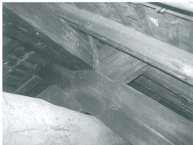
写真 18 地棟に架けた登り梁
