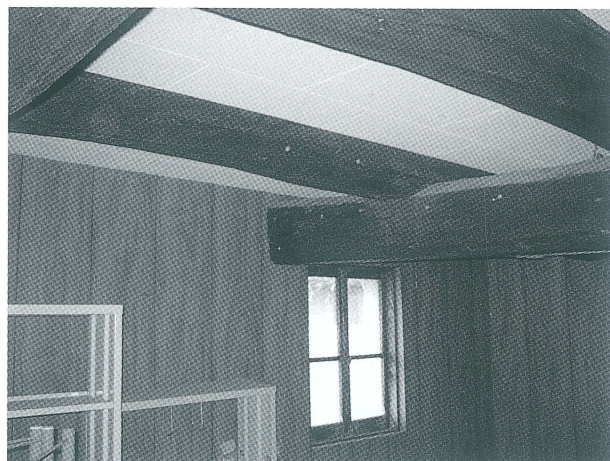
写真 40 2階ニカイマ内部
