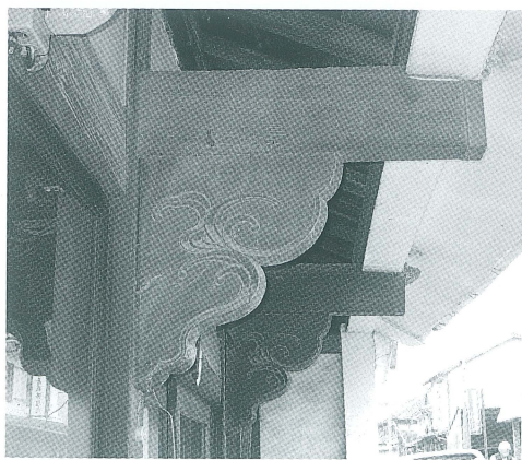
写真7 主屋正面下屋の持ち送り
