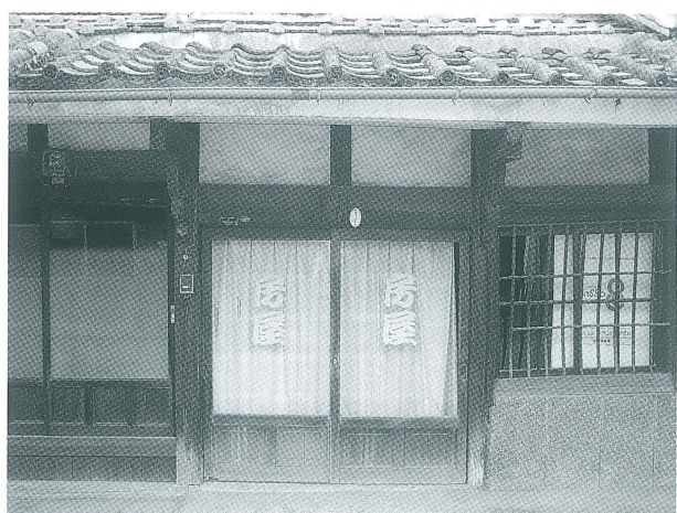
写真 43 1階正面開口部
