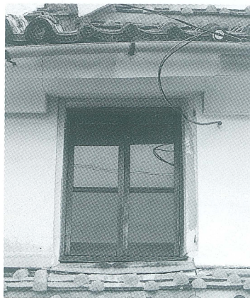
写真8 主屋2階正面窓の金具跡
