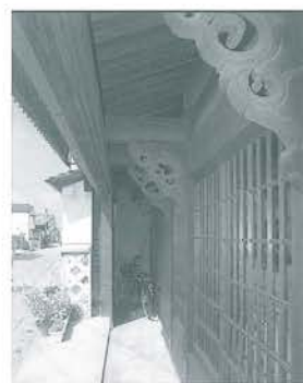
↑ 諸富弘家 下屋庇軒下
