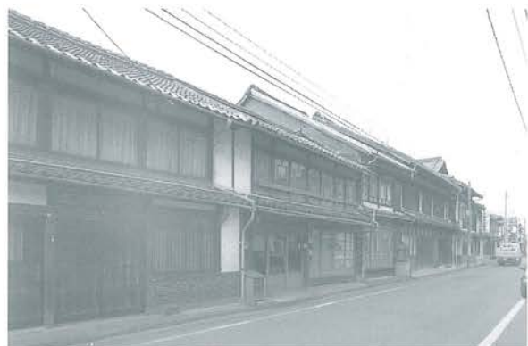
↑平入真壁造開放型 ↓小梁間両下屋開放型
