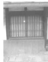
腰壁 (洗い出し)
