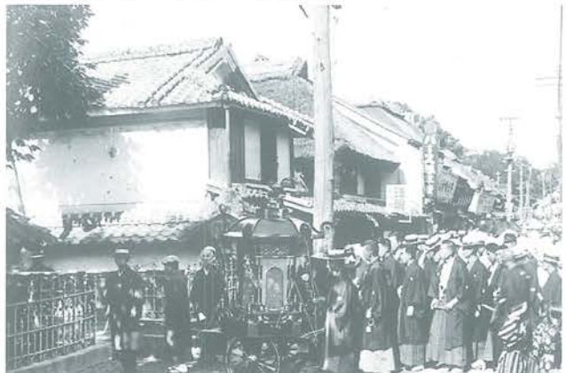
↓西宮野町北側の町家群 道路拡幅前
