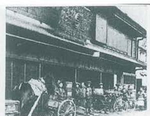
↑宮崎勝家外観旧状
