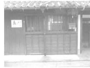
腰壁 (ささら子下見板張り)
