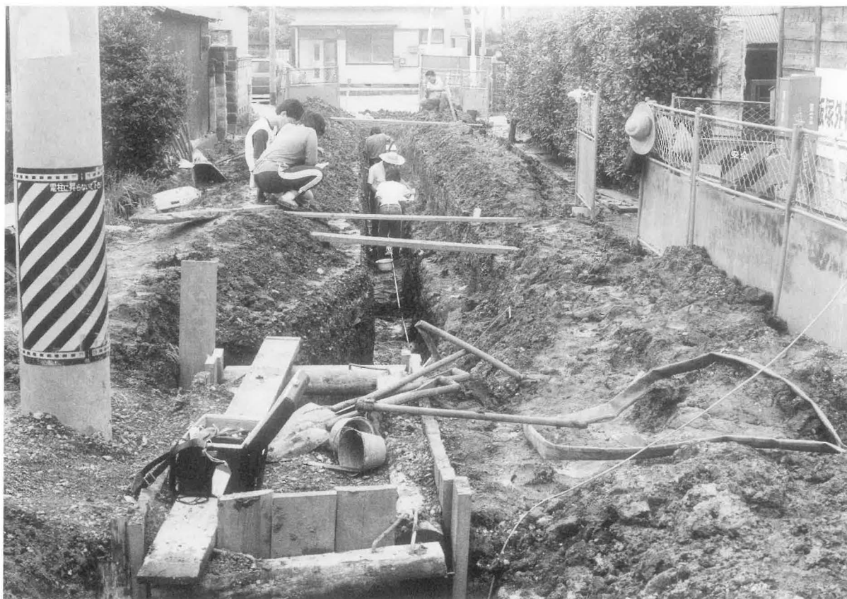
2、第1トレンチと電柱の養生
