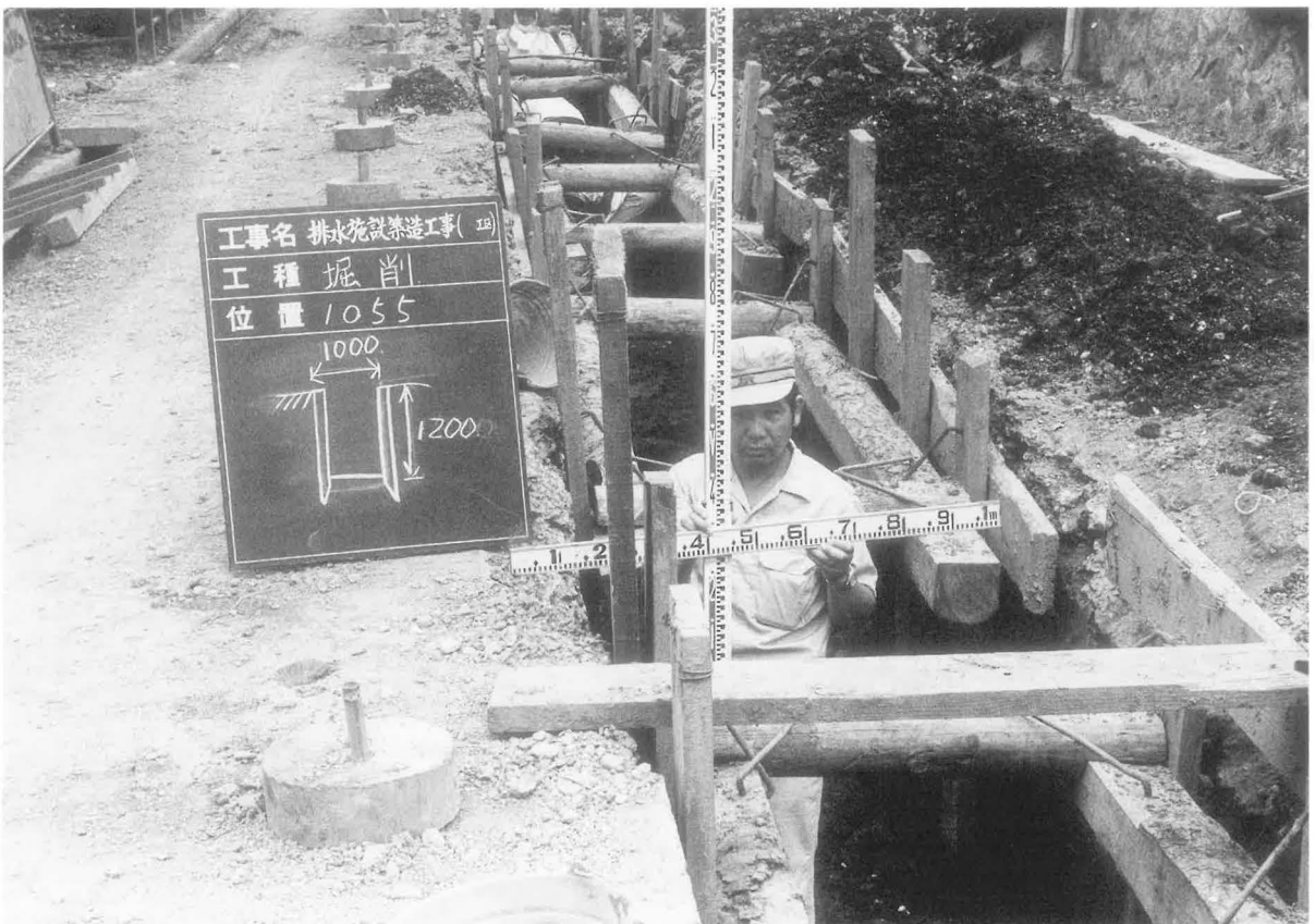
2、矢板を用いた崩落防止の支保工設置作業
