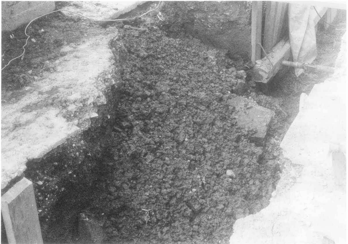
1、トレンチ南壁の崩落状況
