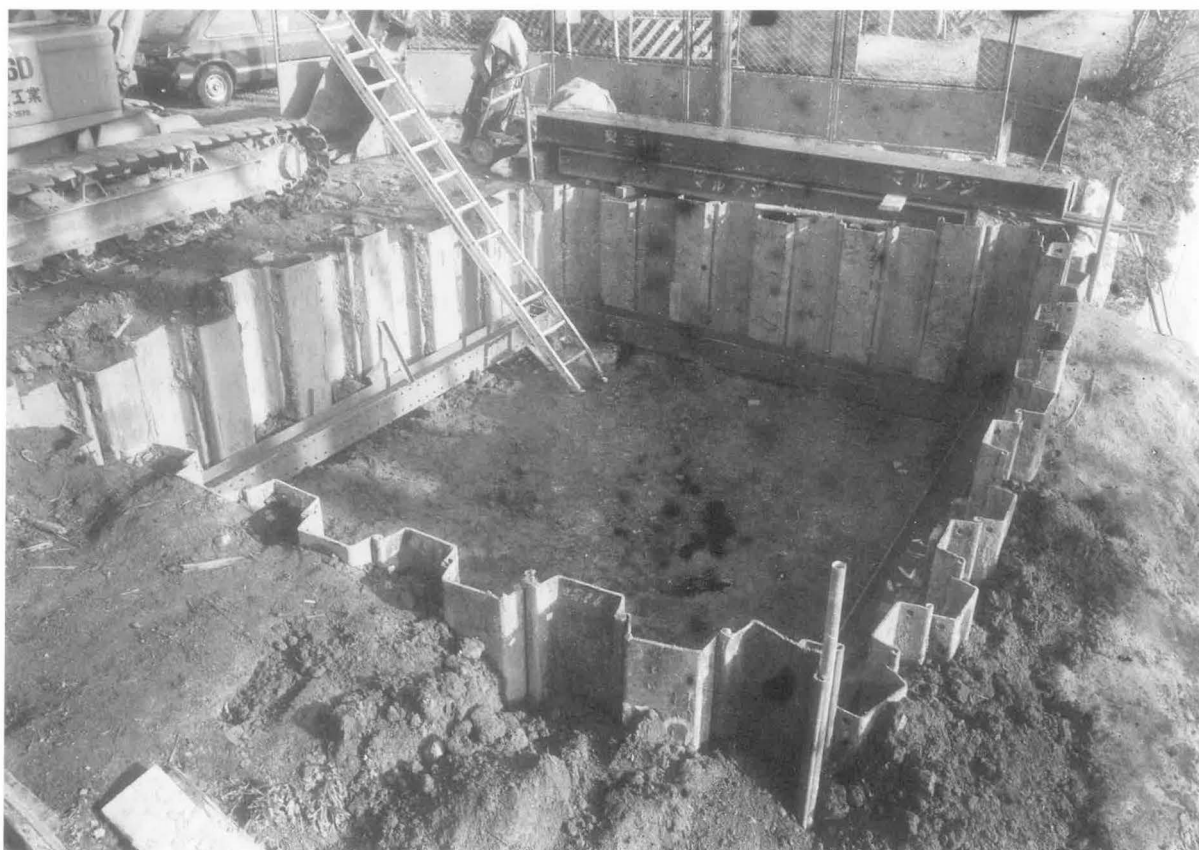
2、鉄製支保工に囲まれた第3グリッドの全景
