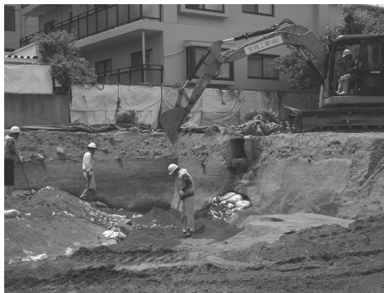
写真5 土嚢および真砂土による養生作業
