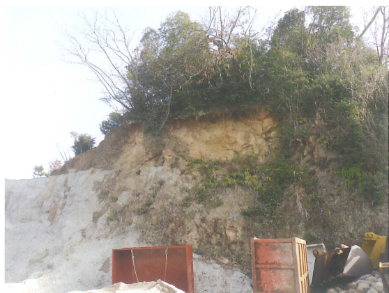
(2) 北西崖面部分（南西より）
