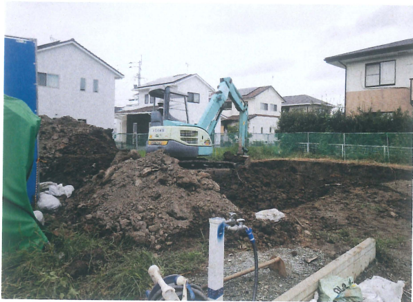
稲富・道免遺跡第2次 表土除去作業 (南東より)
